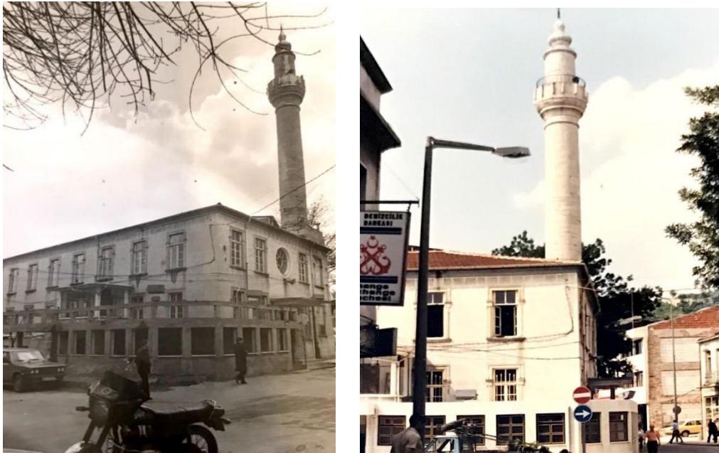
Resim 6- 3.2.2. Şubat ve Temmuz ayları arasında çekilen fotoğraflarda ki abdesthane ve minare yenilenmesi. (Vakıflar Genel Müdürlüğü)
