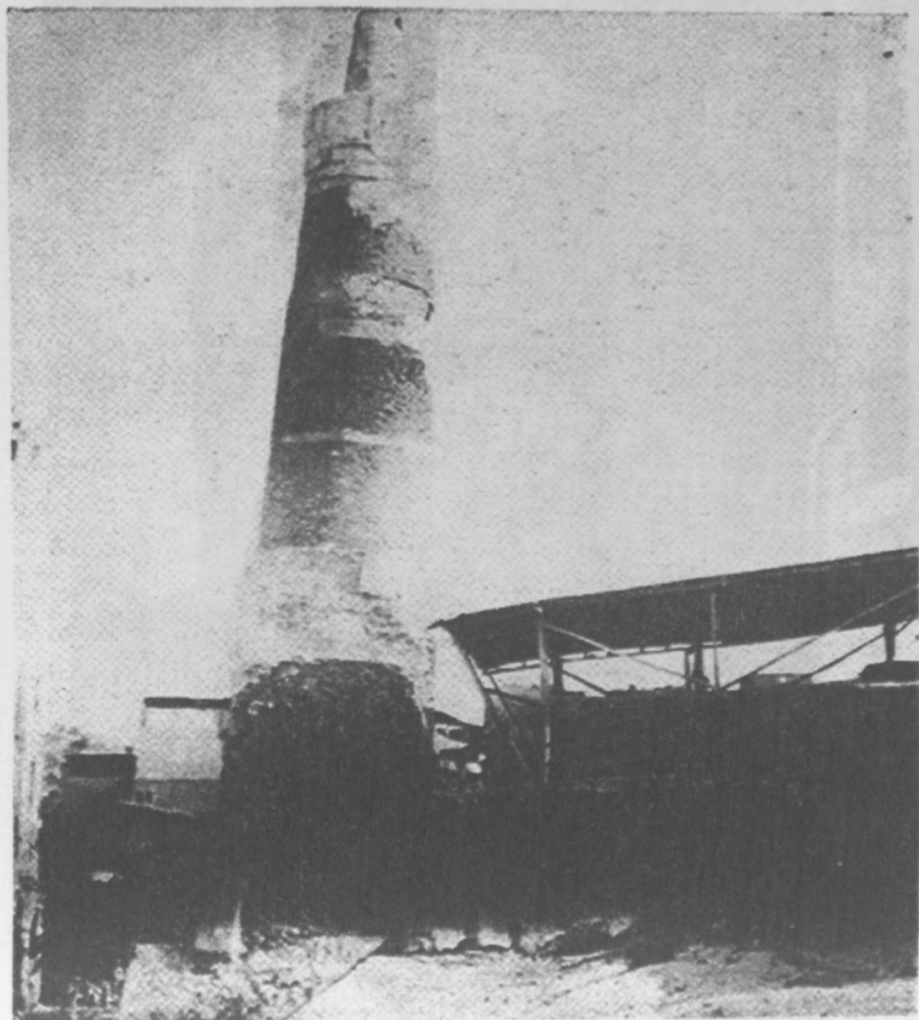
Resim: 40 — Siirt, Ulu Cami; restorasyondan önce, (Vakıflar Gen. Müd. arşivi)
