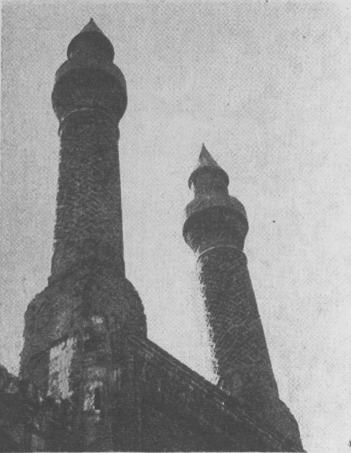
Resim: 49 — Sivas, Çifte Minareli Medrese. Pl: 49 — Sivas, The Çifte Minareli Medrese.
