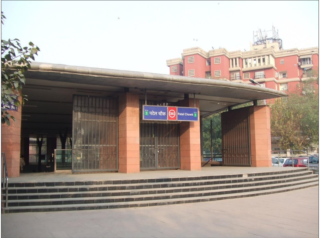
Şekil 40: Patel Chowk İstasyonu Giriş Yapısı (Url-26).
