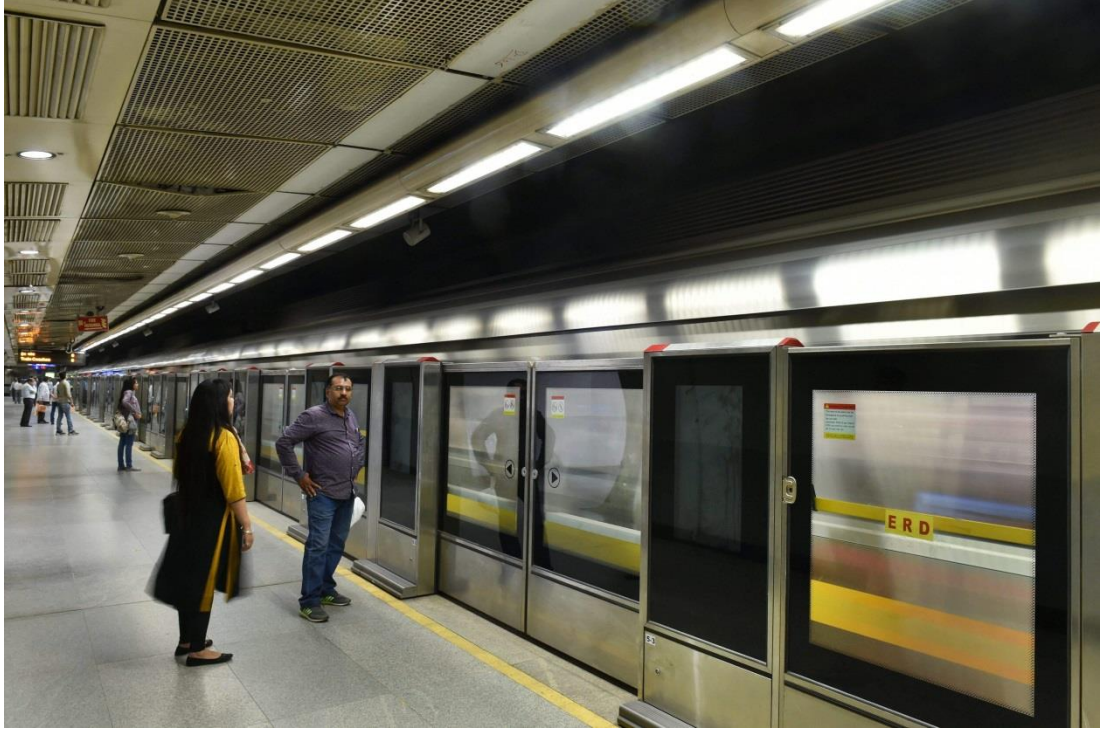
Şekil 24: Peron/Platform Mekanı ve Peron Ayırıcı Kapı Sistemi (PAKS), Delhi, Hindistan (Url-13).
