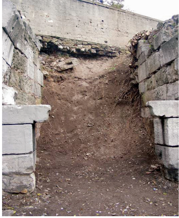
Fotoğraf 3- Kapının Temizlikten sonraki durumu
