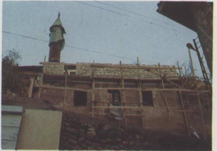
Resim 17- Zonguldak Safranbolu Kütükçü Camii Batı Cephesi Onarım sırasında
