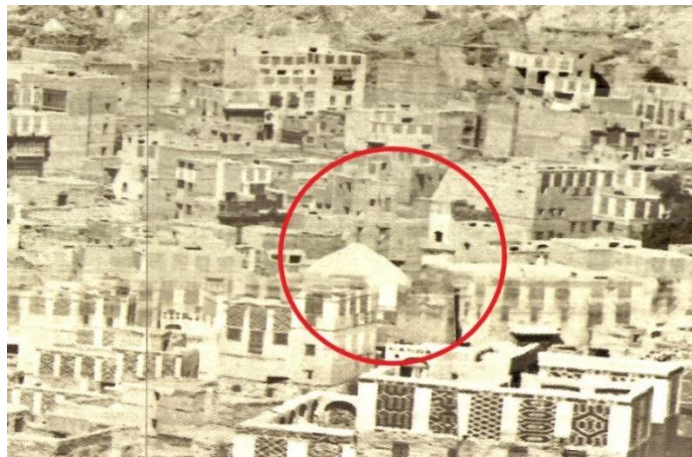
Şekil 3.119.: Hz. Peygamber'in Osmanlı devrindeki mescide dönüştürülmüş olan evini gösteren fotoğraf (IRCICA, 2013, -panoramik bir fotoğraftan alınan kesit-)
