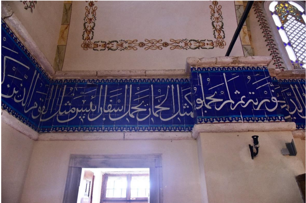
Fotoğraf 81 Aynı yerin restorasyon sonrası çekilen fotoğrafı
