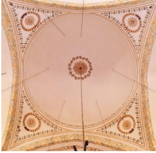
Fotoğraf 16 Restorasyon sonrası kubbe içi kalem işleri
