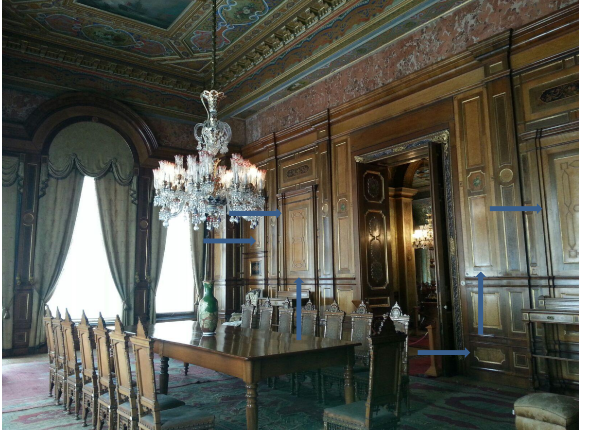
Şekil 71: 21 No'lu Oda'nın marketri tekniği ile yapılmış duvar kaplamaları
