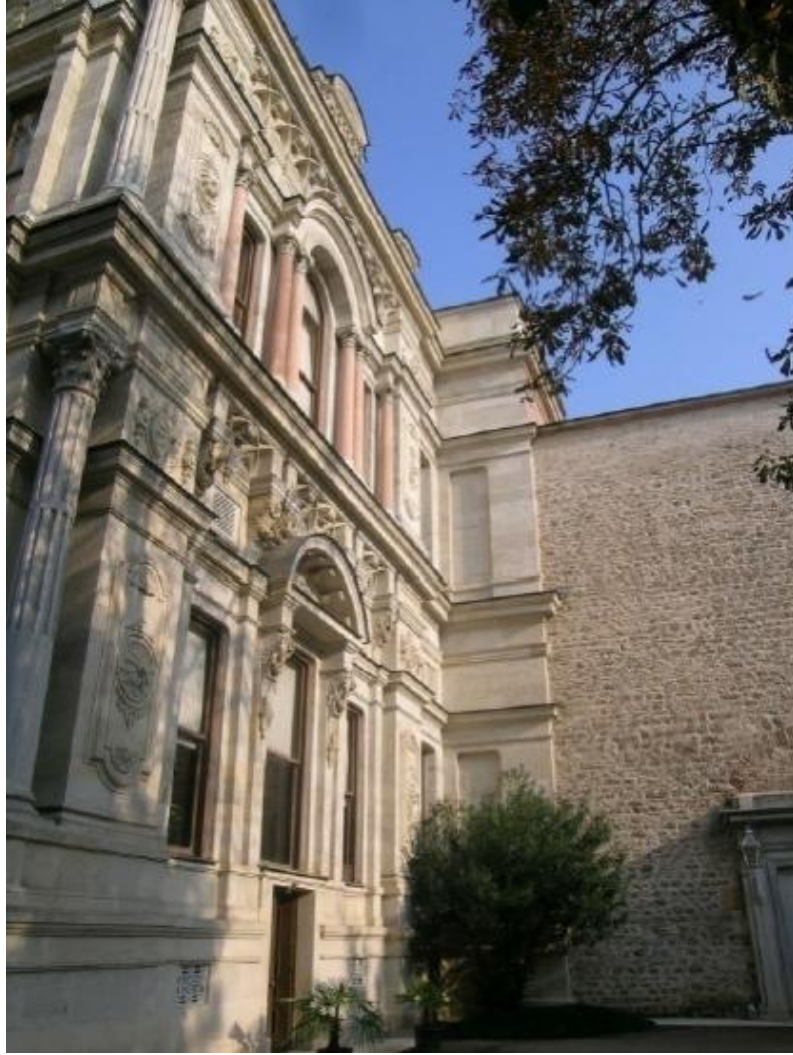
Şekil 8: Beylerbeyi Sarayı, Doğu Cephe Mabeyn Kısmı
