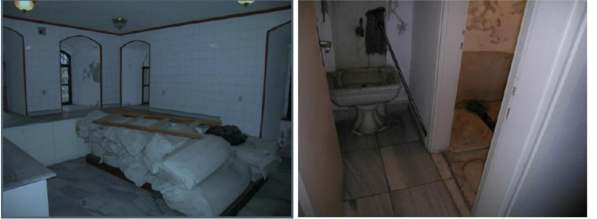
Şekil 26: Sarı Köşk bodrum kat mekânı
