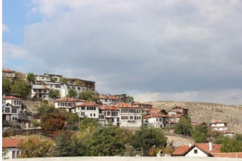
Resim 2-4 Beypazarı evlerinin topoğrafyaya uygun yerleşimi
