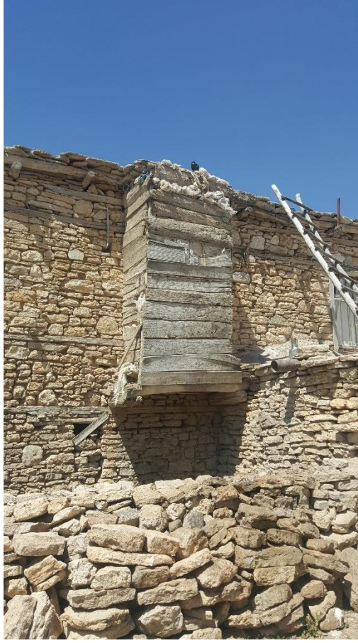
Şekil 5.76 8 numaralı konut. Ahşap karkas sistem hela. (2020)
