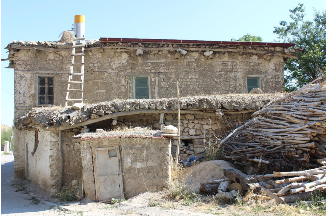
Şekil 2.1 Konya, İvriz’de sivil mimarlık örneği (2019)
