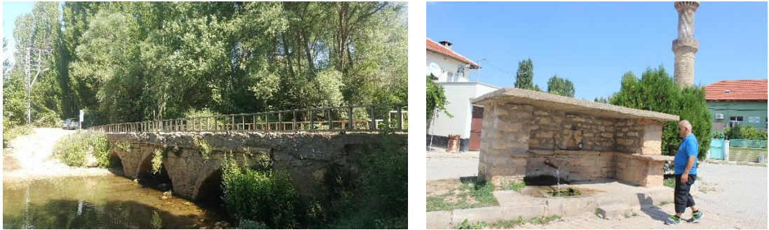
Şekil 5.12 Emen köyünde bulunan köprü ve çeşme (2019)
