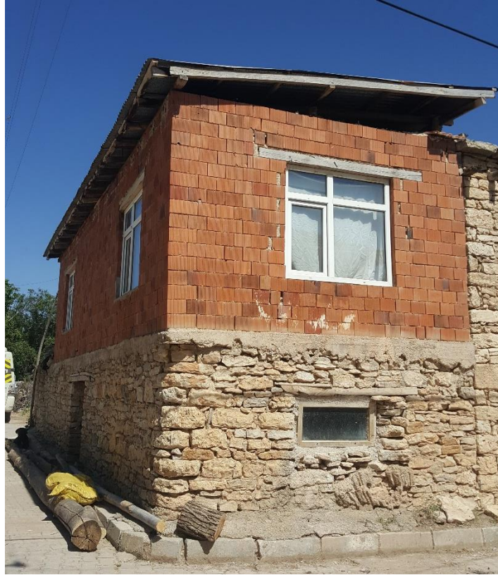
Şekil 5.19 Yığma taş+tuğla sistem örneği (2019)
