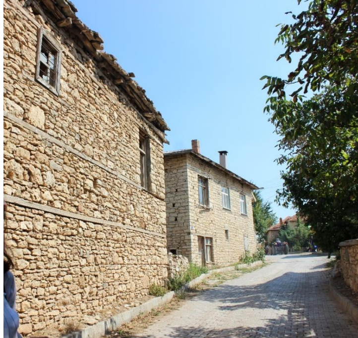
Şekil 5.86 Yığma taş duvar örneği (2019)
