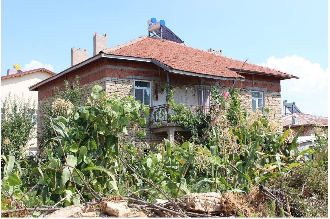
Şekil 5.33 Üst örtüsü toprak dam iken kırma çatı olarak değiştirilen çatı örneği (2019)
