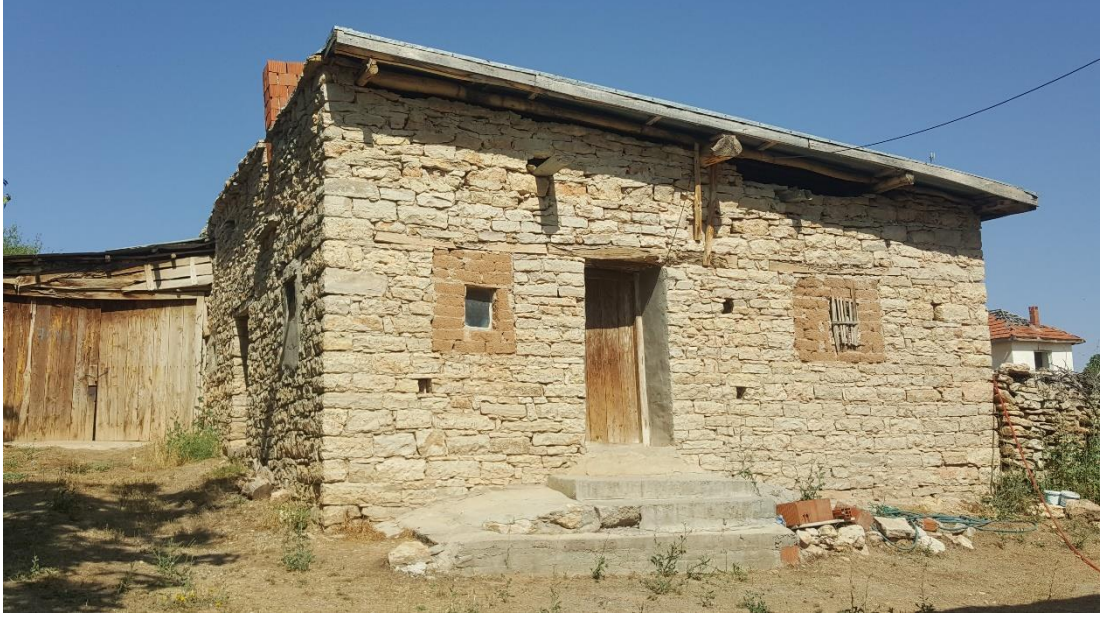
Şekil 5.89 4 numaralı konut tandır. Yığma taş duvar tandır örneği (2020)
