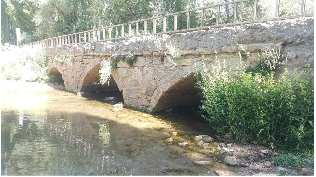
Şekil 5.51 Emen köyü Yazı Deresi üzerinde bulunan köprü (2020)
