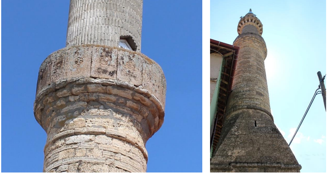
Şekil 5.48 Şerefe korkulukları ve minare gövdesi (2020)
