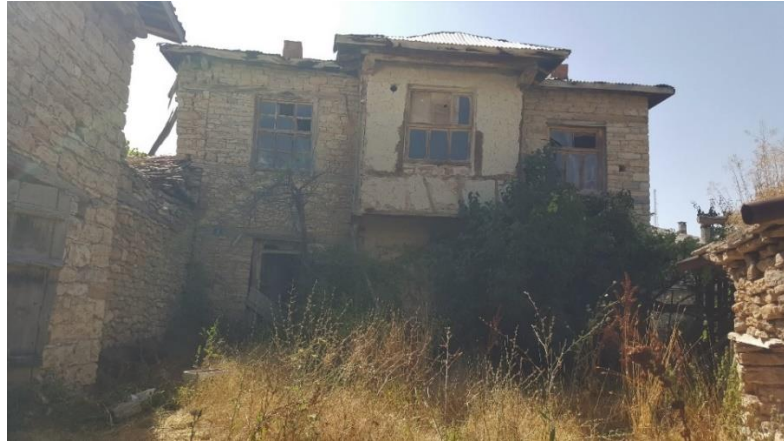
Şekil 5.85 4 numaralı konut. Giriş cephesi çıkma örneği (2020)
