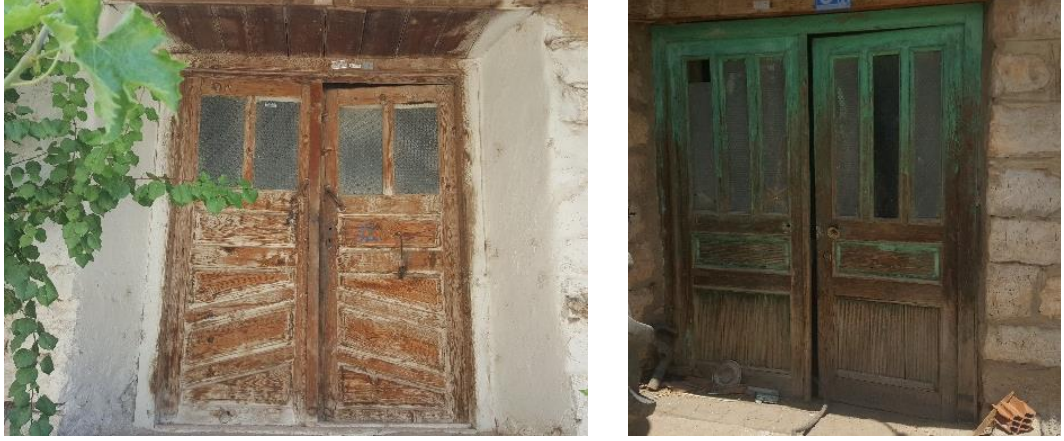
Şekil 5.95 3 ve 13 numaralı konutlar. Ahşap çift kanatlı dış kapı örnekleri (2020)
