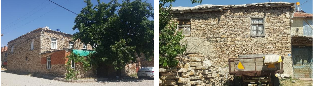
Şekil 5.92 Toprak dam örnekleri (2020)
