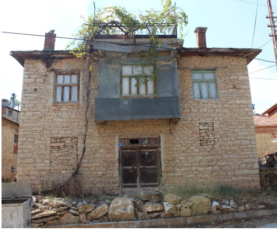
Şekil 5.82 Çıkma örneği (2020)
