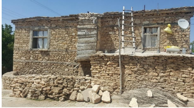
Şekil 5.84 8 numaralı konut. Ahşap hatıllı taş duvar örgü örneği (2020)
