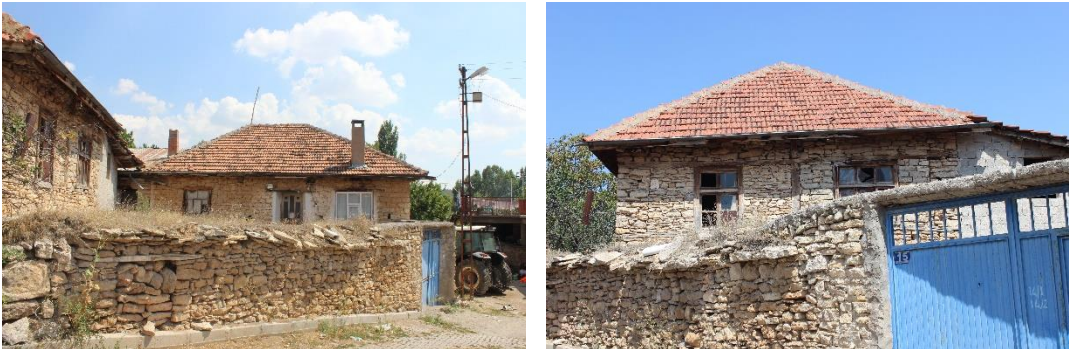
Şekil 5.90 Kırma çatı örnekleri (2019)
