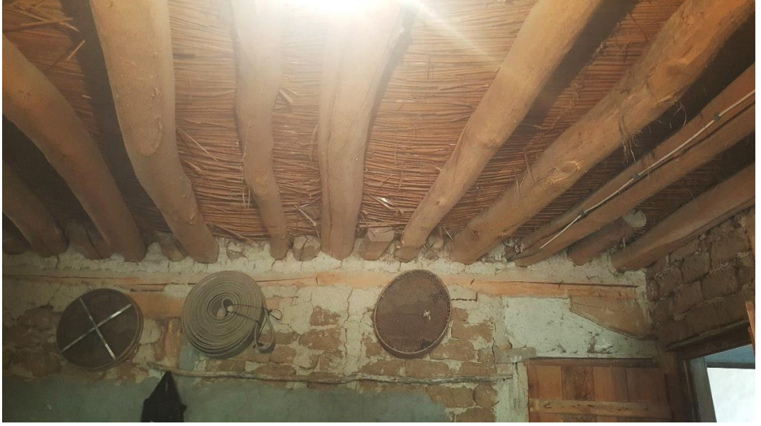
Şekil 5.87 4 numaralı konut. Kerpiç iç duvar örneği (2020)
