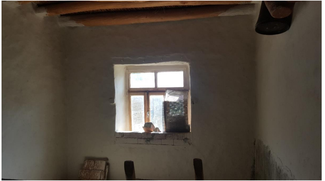
Şekil 5.88 4 numaralı konut. Sıvalı iç duvar örneği (2020)
