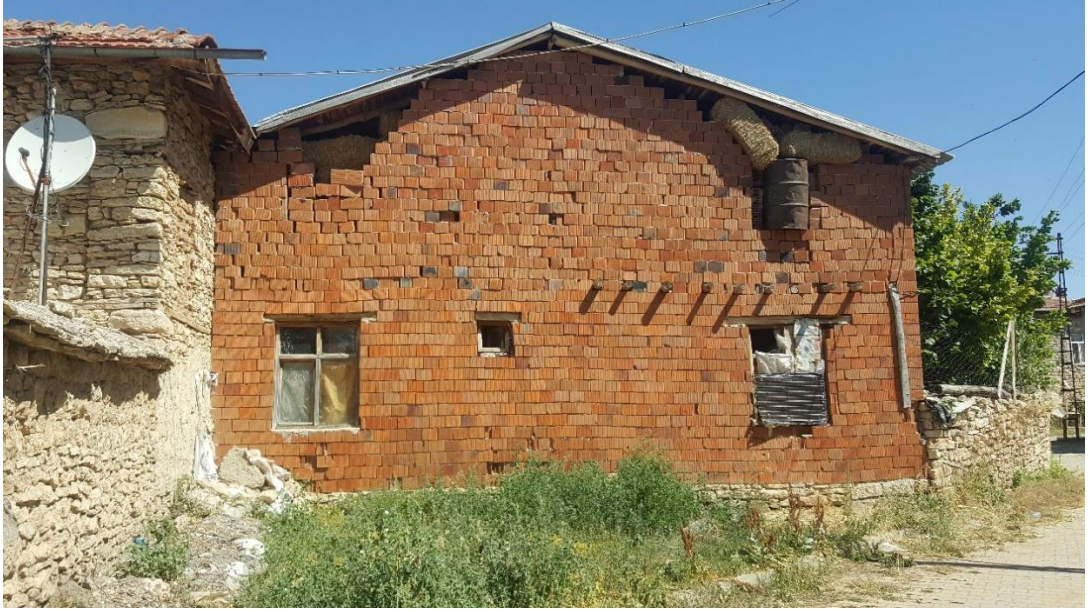
Şekil 5.94 Yığma tuğla duvar örneği (2020)
