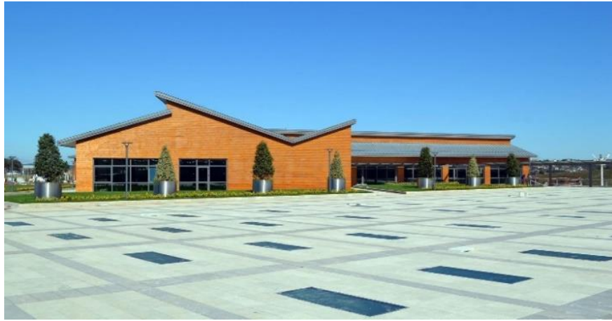
Şekil 4.46. Tuzla Terakki Okulları Kampüs Meydanı cam döşemesi (URL-45).
