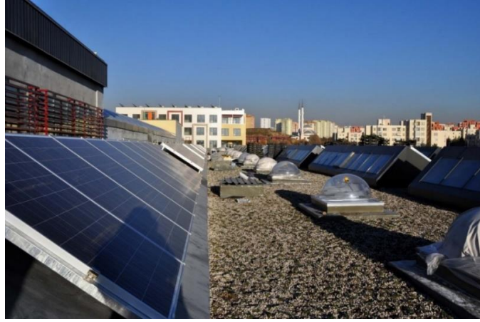
Şekil 4.9. Atölye bölümü üzerinde kahverengi çatı uygulaması (URL-39).
