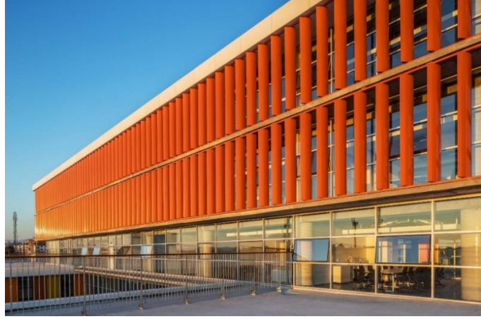
Şekil 4.157. Özel İAOSB Nedim Uysal MTAL idari mekânların doğu cephesinde görüntüsü (URL-50).
