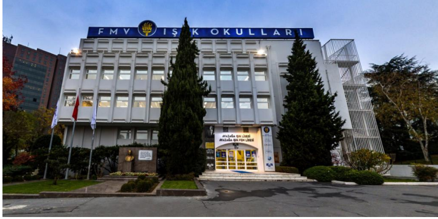
Şekil 4.100. FMV Ayazağa Işık Lisesi binasına tören alanından bakış.
