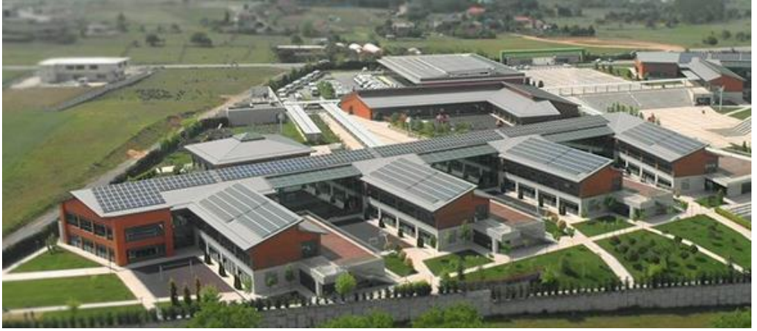
Şekil 4.31. Tuzla Terakki Okulları çatısına yerleştirilen fotovoltaik güneş panelleri (Terakki Vakfı Okulları Fotoğraf Arşivi).
