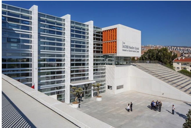
Şekil 4.131. Özel İAOSB Nedim Uysal MTAL güzey cephesinde yatay güneş kırıcılar (URL-52).
