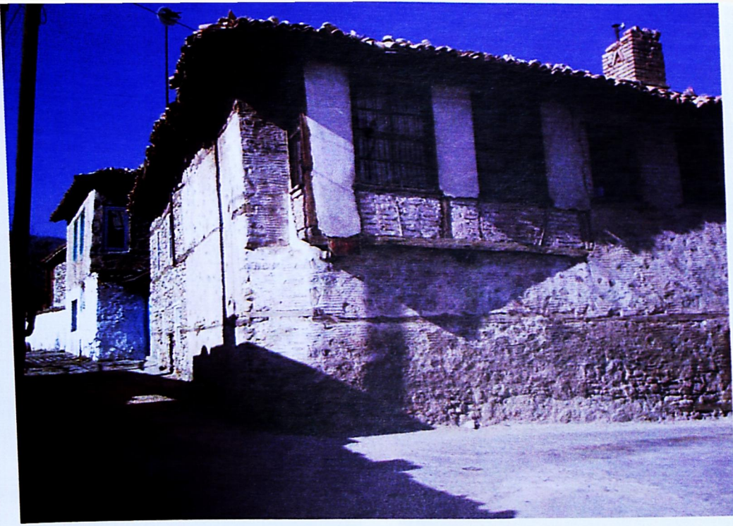
Fot.17: Buldan evlerinde Hımiş Duvar Örgüsü.
