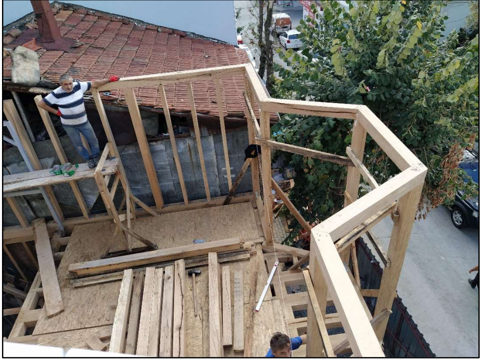
Zemin Kat Ahşap Döşemesi ve İskeleti
