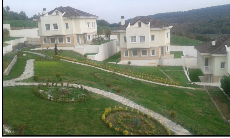
Resim 4.6 : Projede Tamamlanan Bloklar ve Genel Peyzaj Durumu
