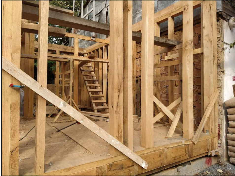
Zemin Kat Ahşap Döşemesi ve İskeleti
