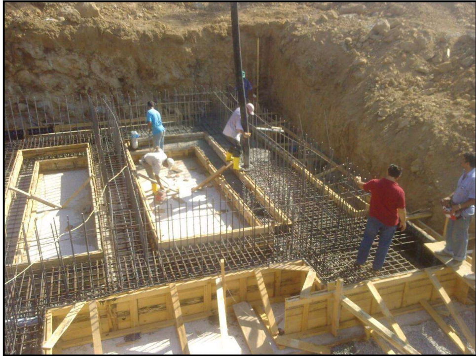
Proje alanı, temel betonunun dökülmesi
