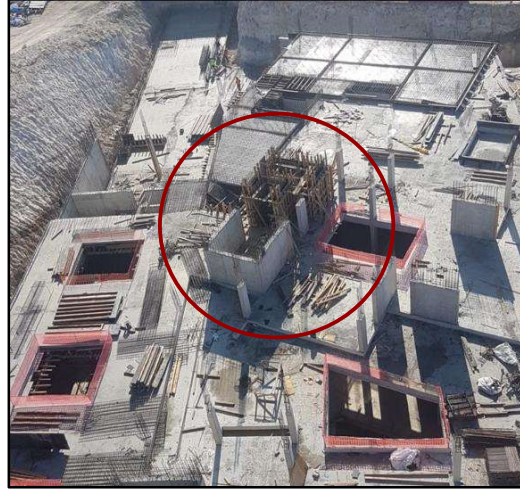
Resim 4.15 : Tamamlanmış Perde Duvar İmalatı
