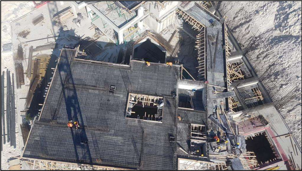
Proje Temel Demirinin Bağlanması ve Beton Dökümü Aşamaları
