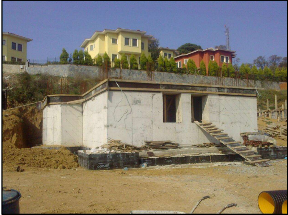
Kaba inşaat aşaması (bahçe katı perde duvar imalatı)
