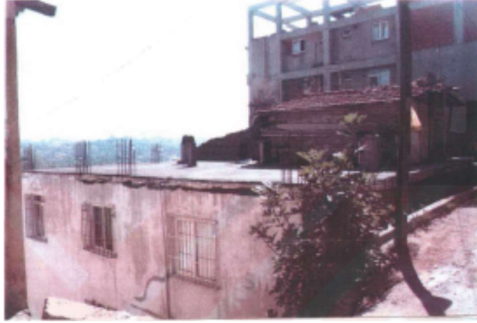
Resim 4.1 : Sonradan kat çıkmak üzere beton filizi bırakılmış bir bina
