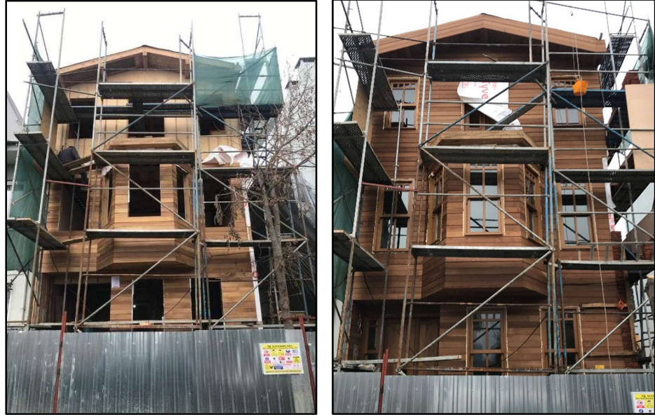
Resim 4.3 : Şantiye’nin 15 Aralık 2020 ve 15 Ocak 2021 tarihli mevcut durumları
