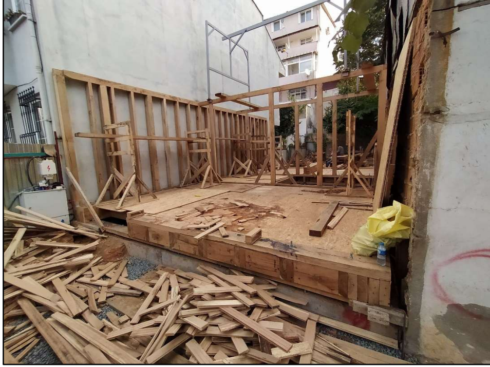
Zemin Kat Ahşap Döşemesi ve İskeleti
