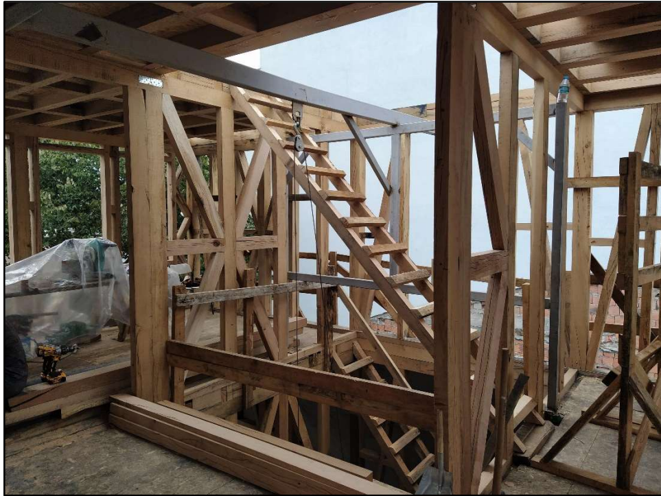
2. Kat Ahşap Merdiven Kovası ve Bölme Duvarlar
