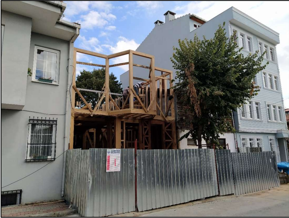
1. Kat Ahşap Cumba Yapımı
