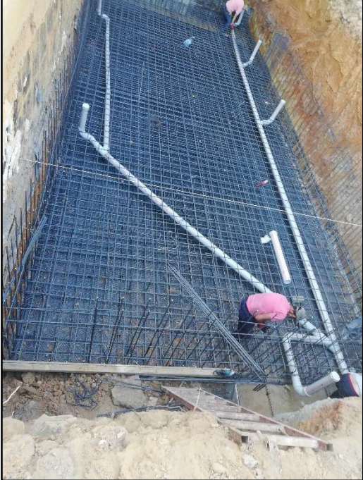
Temel betonu için demir bağlanması ve bodrum kat perde duvar kalıpları
