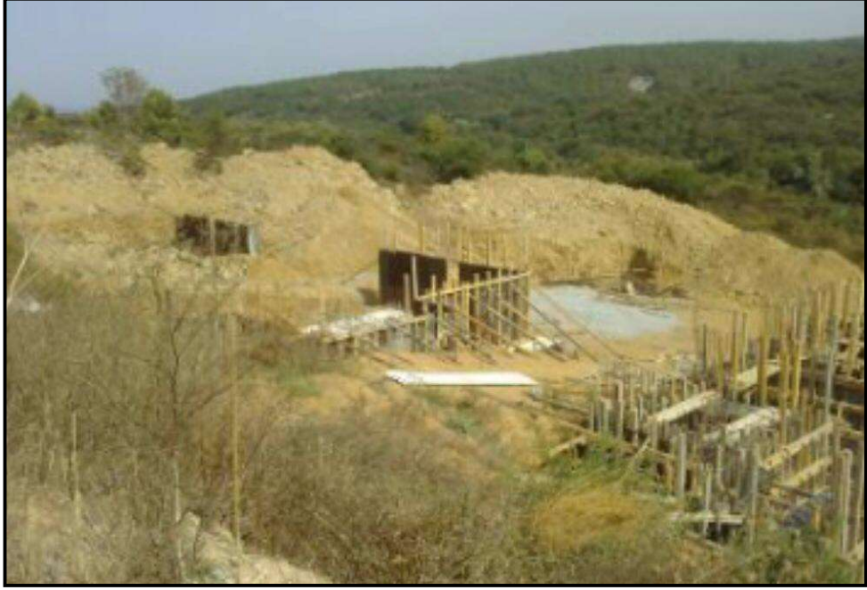
Proje alanı, Temel kalıpları ve betonun dökülmesi
