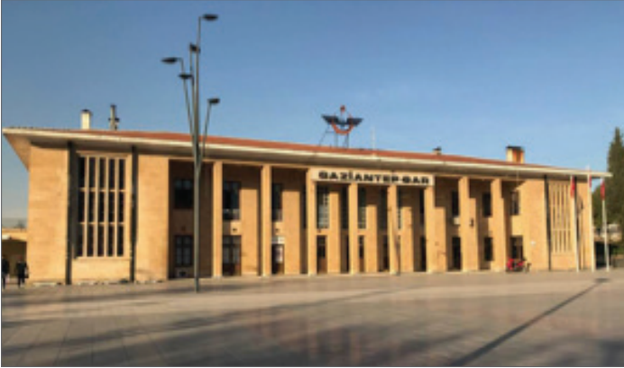
Şekil 9 Gaziantep Tren Garı güney cephesi, (Türkan Uzun, 2018)
