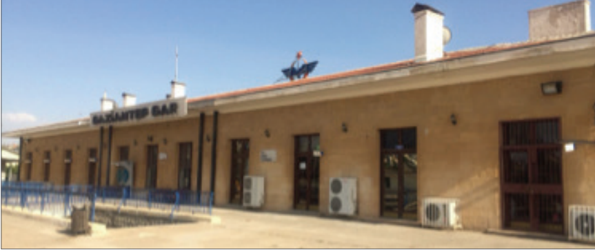
Şekil 22 Gar Binası Kuzey Cephe, (Merve K., 2018)
