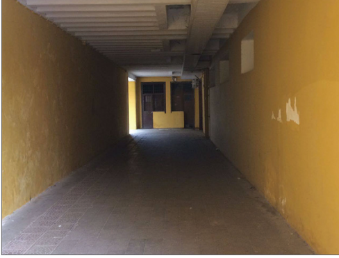
Şekil 29 Gaziantep Tren Garı Arka Bölümündeki Alt Geçit ve Nervürlü Döşeme (Merve K., 2017)
