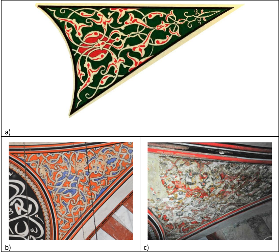
Şekil 3. 59 a) Jones'a ait Süleymaniye Camisi Pandantif Süslemeleri Detayı Çizimi (90° Sağa Döndürülmüştür), (Jones, 1856), b), c) 2007-2010 Raspa Çalışmaları Öncesi, Sonrası Görselleri, (İrteş S., 2021).
