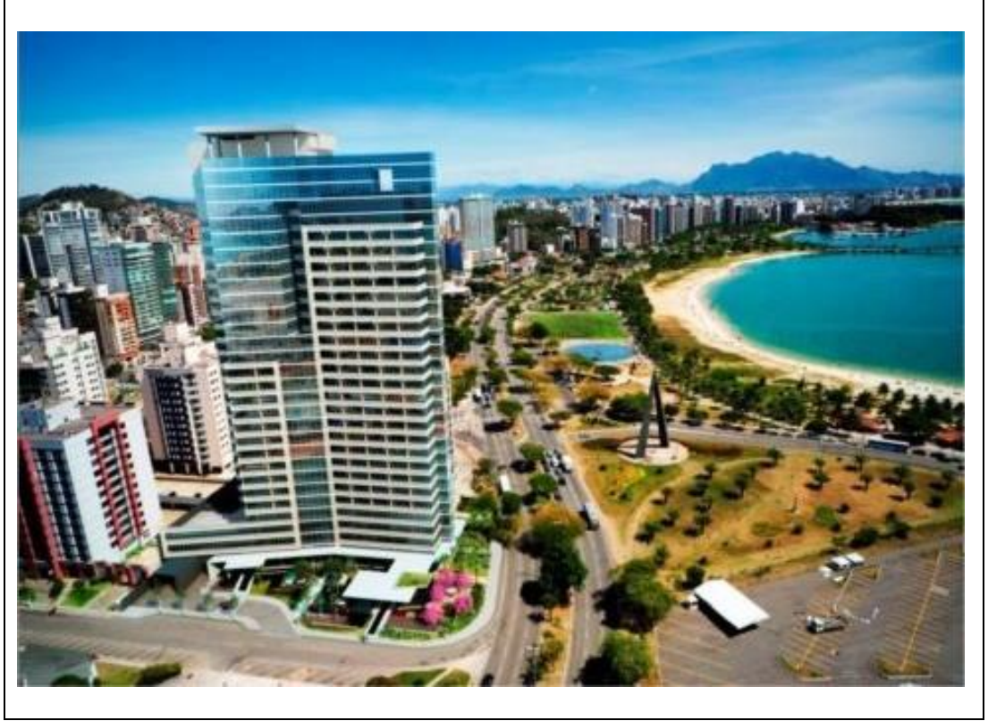
Şekil 2. 15 Fibrasa Connection Projesi İçin Gerçekleştirilen AG Uygulama Görüntüsü (Url-8, 28.03.2024)
