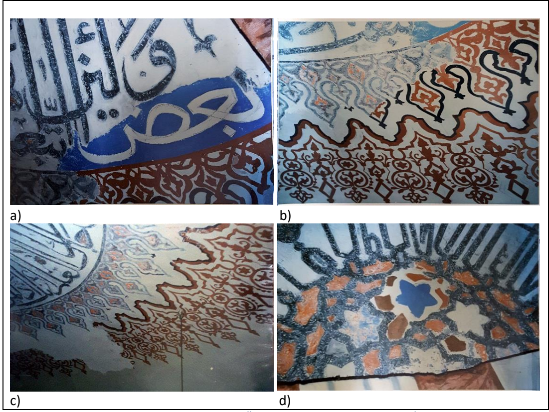
Şekil 3. 39 Sırasıyla, Yarım Kubbe Raspa Çalışması Örneği ile Raspa Sonuç Aşamaları, İVBMA, (Şen, 2019, s. 261).
