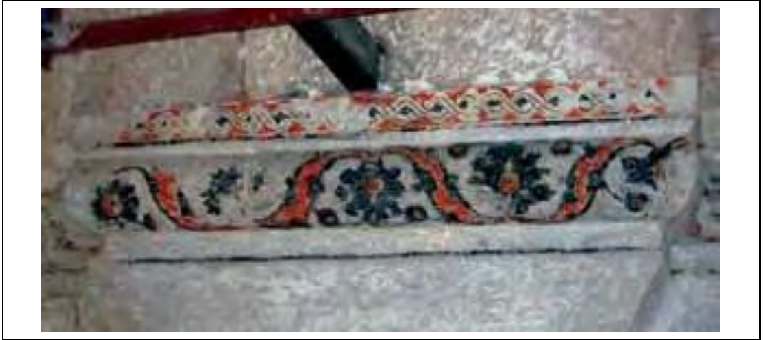
Şekil 3. 50 "1. kat silmesi üzerinde ortaya çıkarılan kalemîşi bordür", (Çobanoğlu & Önel, 2014).
