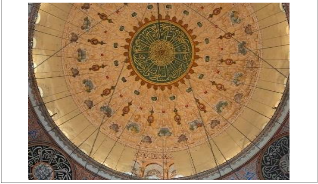
Şekil 3. 19 1957 Restorasyon Çalışmaları Sonrası Ana Kubbe, (İrteş S. , Süleymaniye Camii Kalemışleri Üzerine Bir Değerlendirme, 2021)
