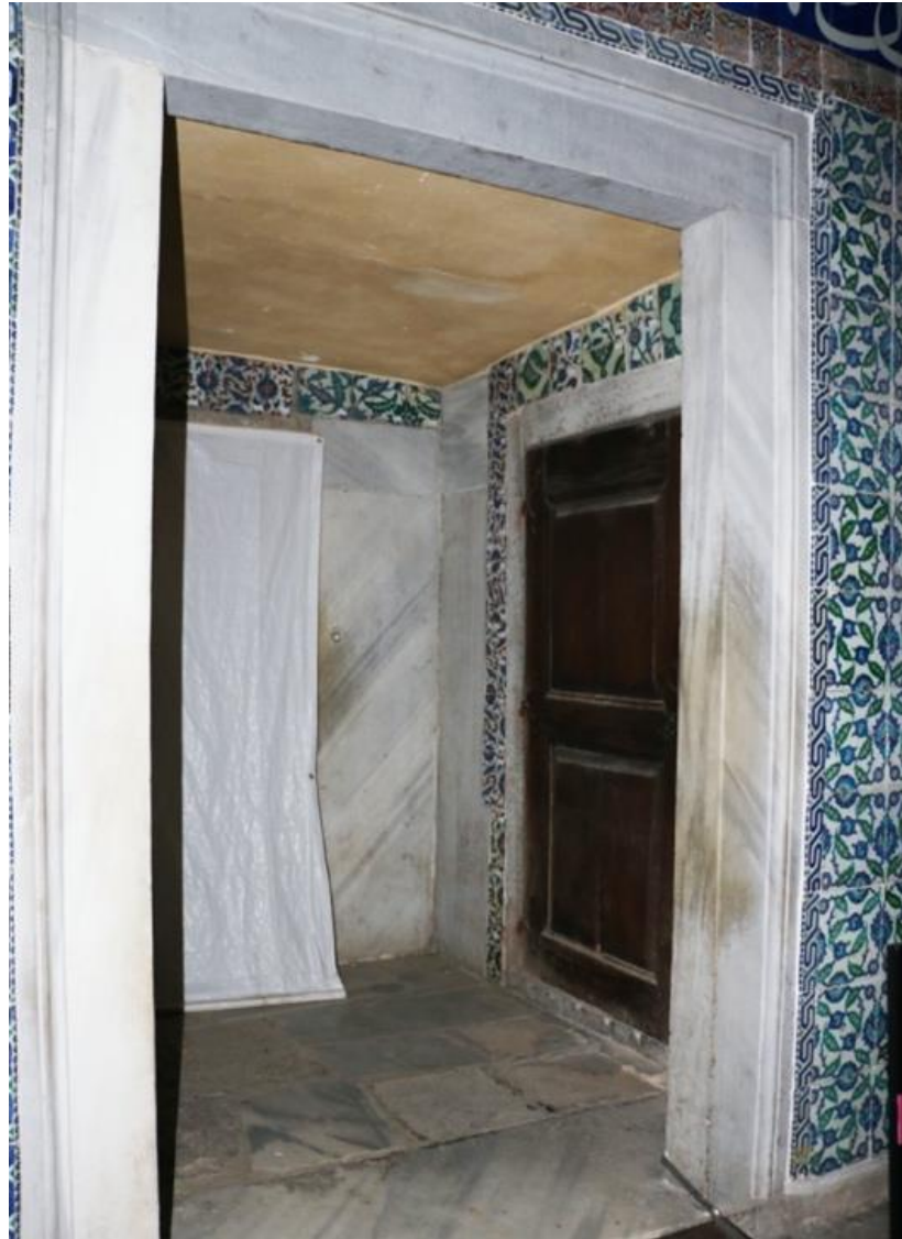
R. 66. III. Murad Has Odası Batı Cephesinde bulunan I. Ahmed Odası kapısı ve Havuzlu Köşk'e inen kapı. (R: Z. Alp.)
