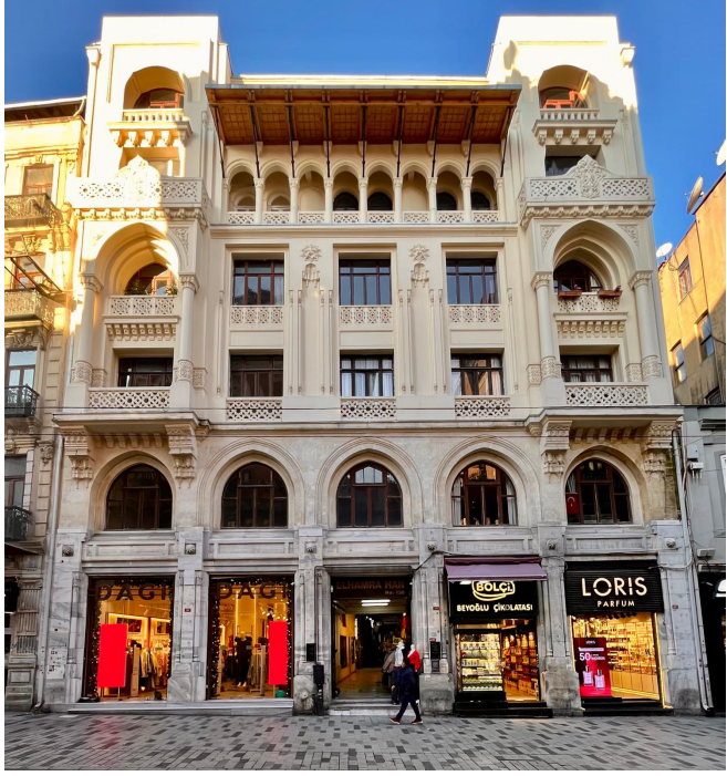
Fot. 2: Elhamra Han'ın Giriş Cephesi (2024)
