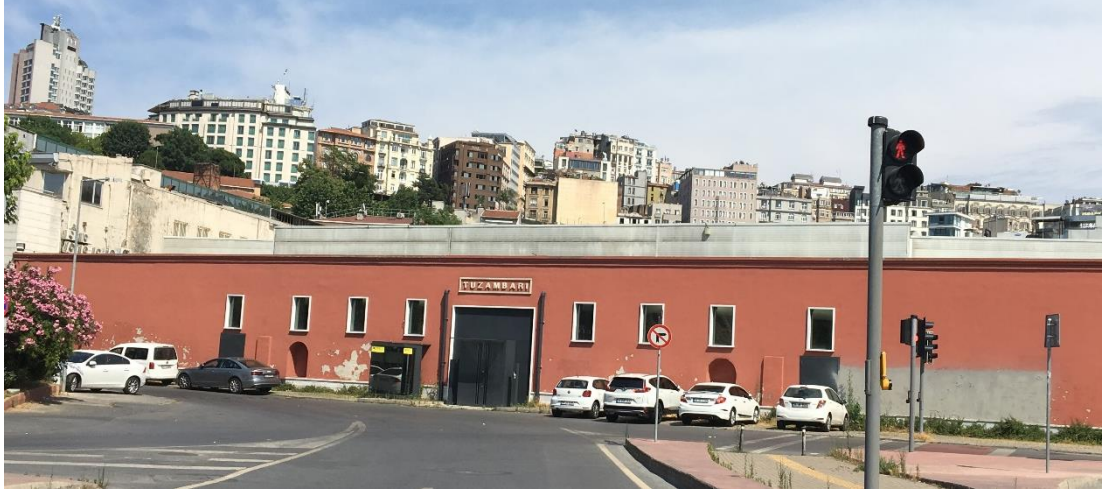
Şekil 64 Tuz ambarı giriş cephesi
