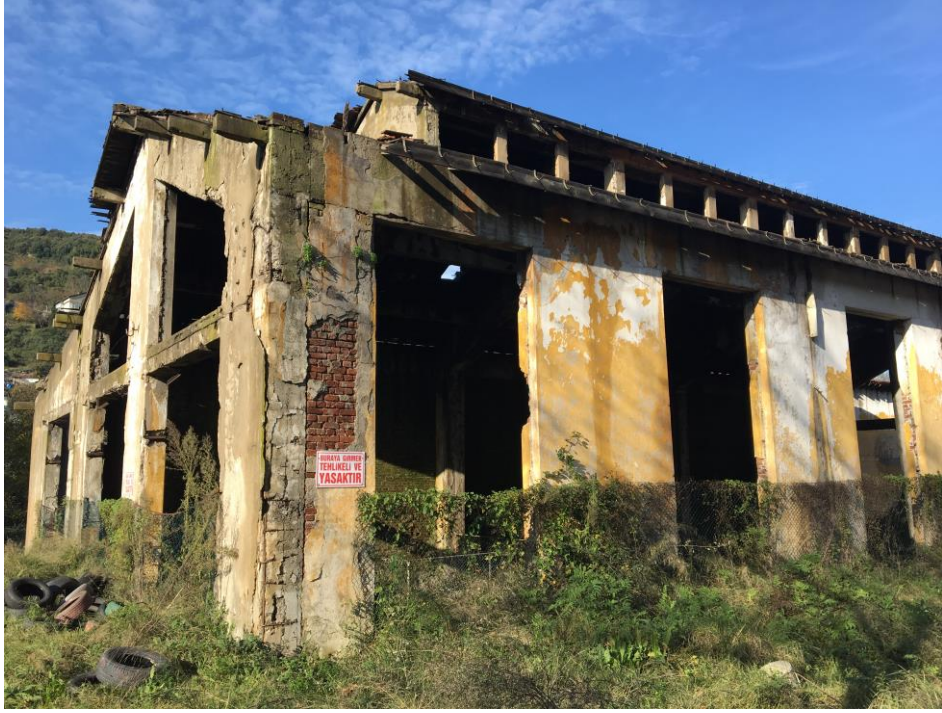
Şekil 105 Atölye binası güneybatı cephesi
