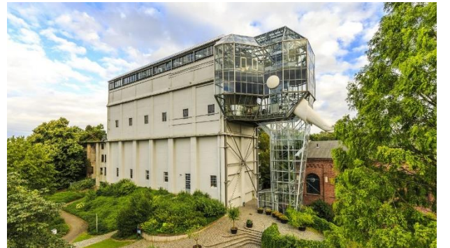
Şekil 25 Yapıya yapılan cam strüktür eklemesi (Maxipark, 2019)
