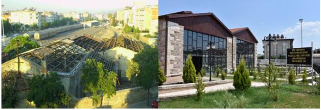
Şekil 71 Nazilli, TCDD Hangar Binası restorasyonu öncesi ve sonrası (Tren Haber, 2016)
