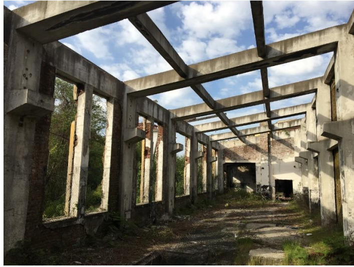
Şekil 119 Bakım Atölyesinin iç mekan fotoğrafları, Kasım 2018
