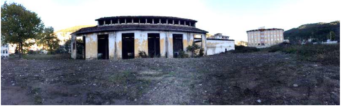
Şekil 118 Ereğli TCDD Lokomotif Bakım Atölyesi
