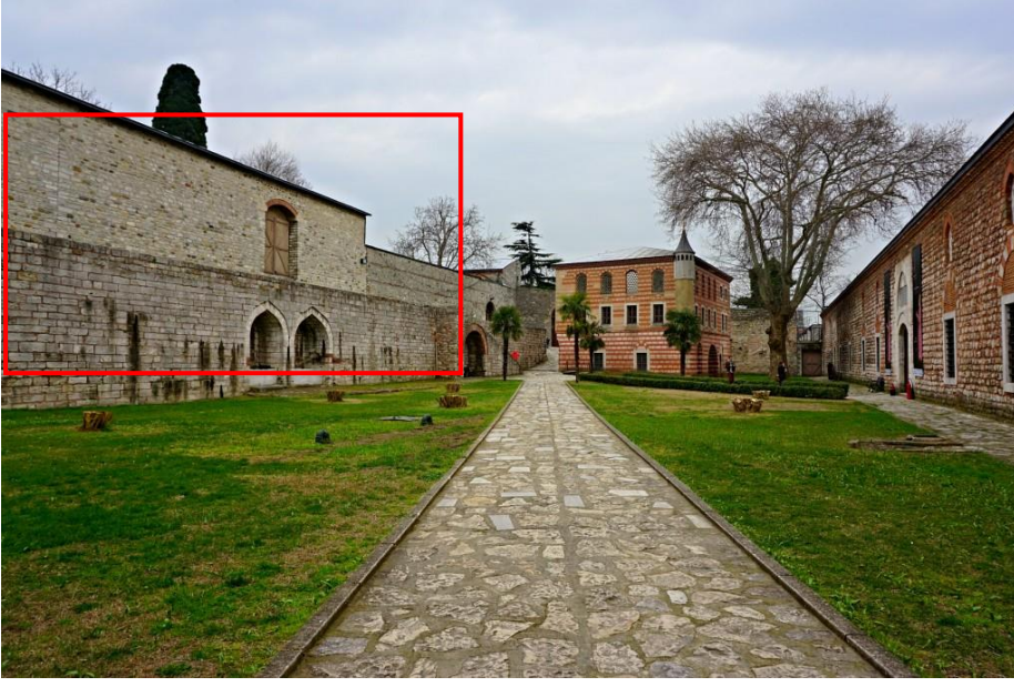
Resim 3 .119: Has Ahırlar avlusunda set üzerinde bulunması gereken yapının günümüzdeki durumu.
