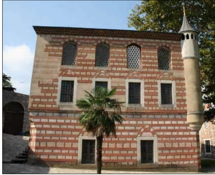
Resim 3.83: Beşir Ağa Cami'nin doğu cephesi. 433
