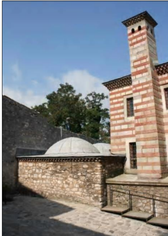
Resim 3.84: Beşir Ağa Camii Hamamı. 434
