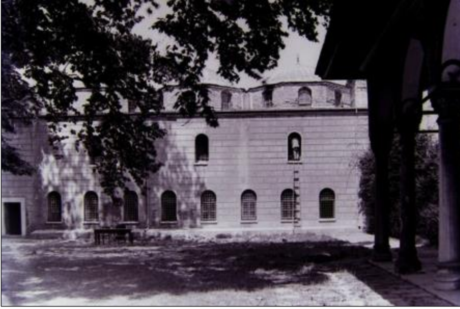
Resim 3.44: Tahsin Öz'ün müdürlüğünde yürütülen onarım çalışmaları öncesi Dış Hazine. (TSMA- Tasnifsiz)
