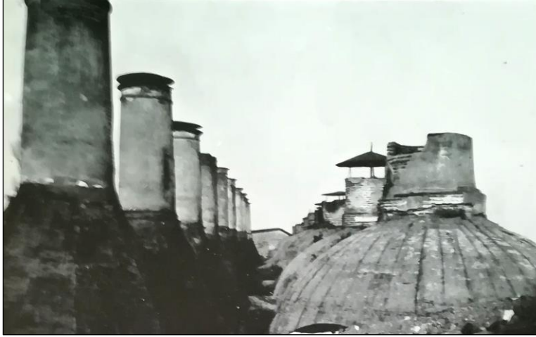
Resim 3.65: 1943 onarımlarından önce Mutfak bacalarının ve kubbelerinin durumu. 392
