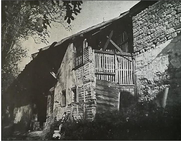
Resim 3.66: Yağhane cephesinin önünde bulunan gecekondu niteliğinde bulunan ahşap yapılar. 393
