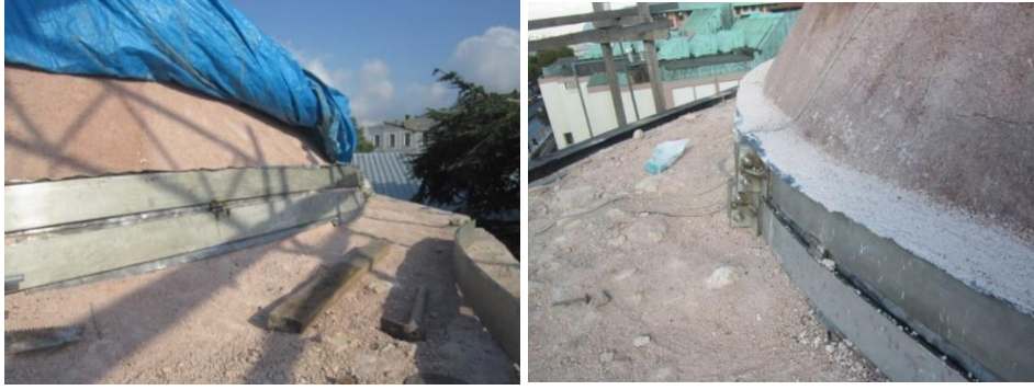
Fotoğraf 4. 122. Paslanmaz çelik çekme çemberi ile kuşaklama yapılması (A.ASLAN)
