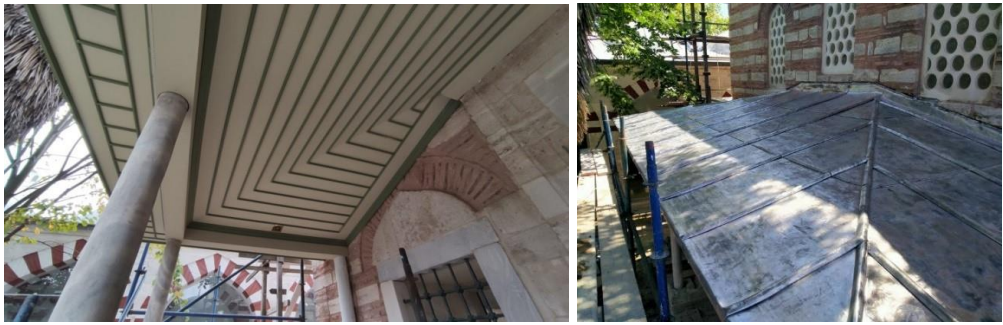
Fotoğraf 4. 100. Ahşap saçak yapılması (A.ASLAN)
