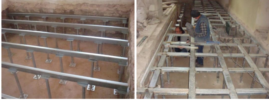
Fotoğraf 4. 126. Döşeme altı tesisat geçişleri için paslanmazdan yükseltme platformu yapılması (A.ASLAN)
