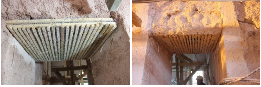
Fotoğraf 4. 53. Bağdadi sıva yapılması (A.ASLAN)
