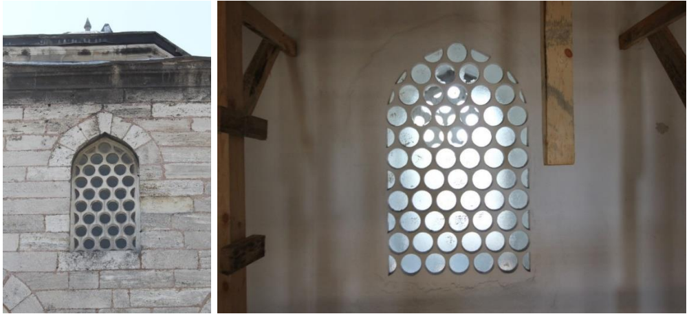
Fotoğraf 4. 3. Beton İçlik ve Dışlık pencereler (A.ASLAN)
