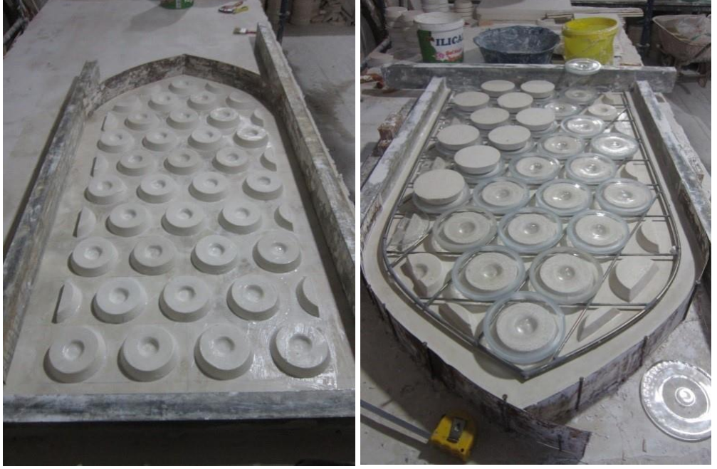
Fotoğraf 4. 88. Dışlık pencerelere fildişi camların ve erkek kalıpların yerleştirilmesi (A.ASLAN)
