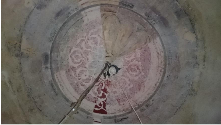
Fotoğraf 4. 12. Dershane kubbesi raspa sonrası çıkan bezeme (A.ASLAN)
