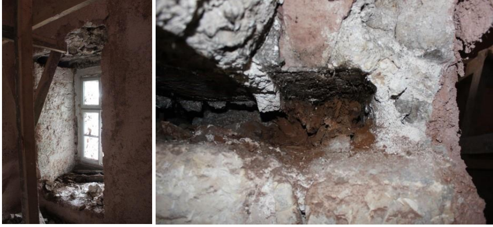
Fotoğraf 4. 36. Çürüyen ahşap hatılların sökülmesi (A.ASLAN)
