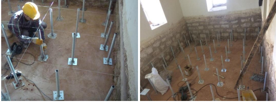
Fotoğraf 4. 125. Döşeme altı tesisat geçişleri için paslanmazdan yükseltme platformu yapılması (A.ASLAN)
