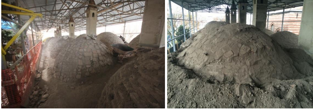
Fotoğraf 4. 105. Niteliksiz dolgu malzemelerinin yapıdan uzaklaştırılması (A.ASLAN)
