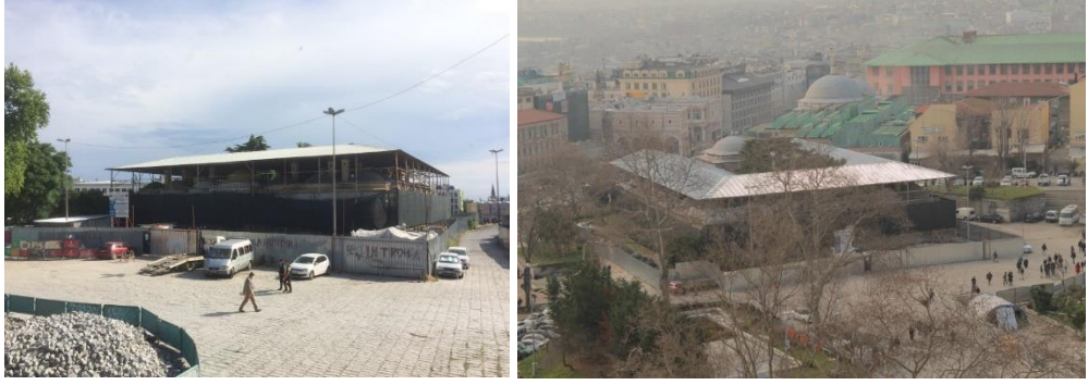
Fotoğraf 4. 104. Geçici çatı yapılıması (A.ASLAN)
