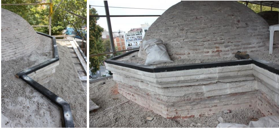
Fotoğraf 4. 113. Ahşap hatılların kasnak silmelerine çakılması (A.ASLAN)
