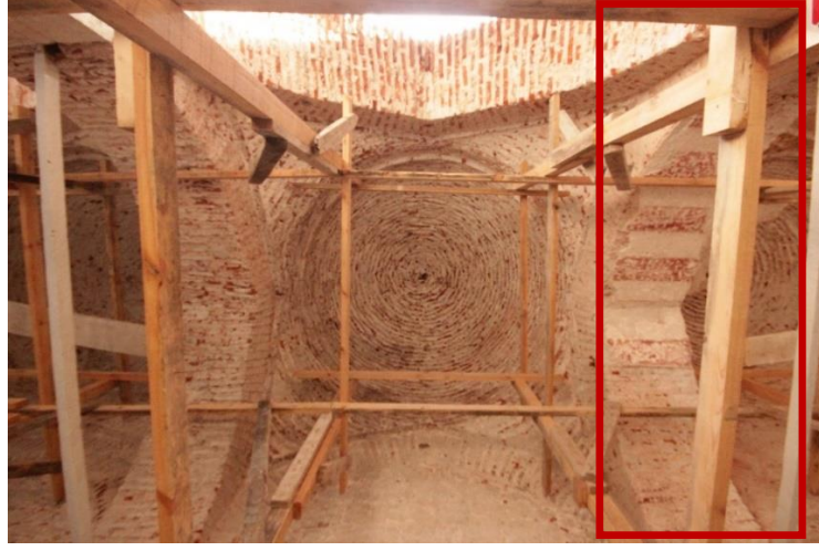
Fotoğraf 4. 18. Çimentolu sıva raspa sonrası kemerlerde ortaya çıkan kırmızı-beyaz taş taklidi (A.ASLAN)
