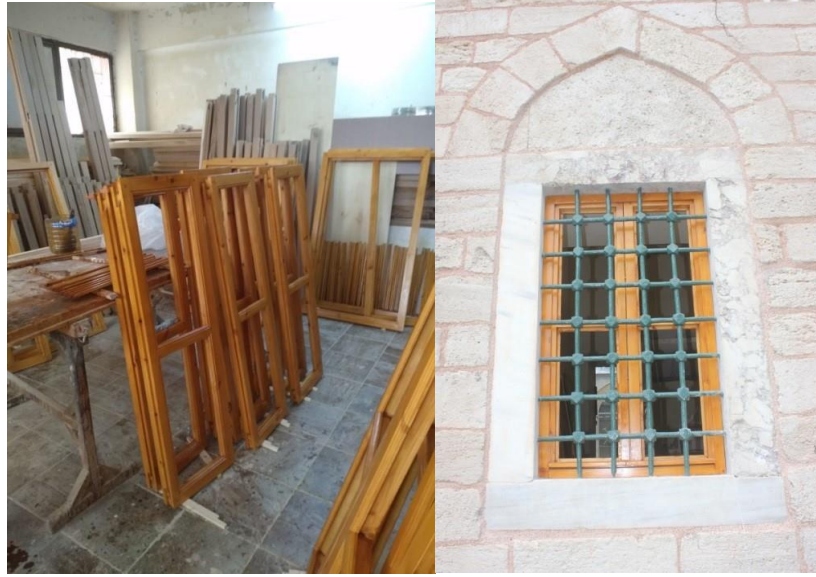
Fotoğraf 4. 96. Yeni yapılan ahşap pencere doğramaları (A.ASLAN)
