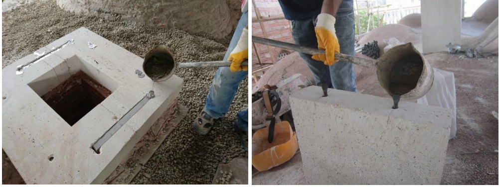
Fotoğraf 4. 47. Baca taşlarının paslanmaz kenetler ile mesnetlenmesi (A.ASLAN)
