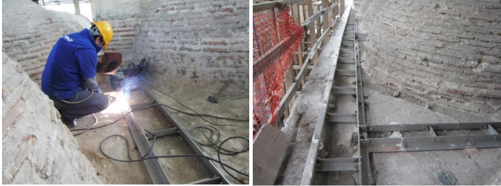
Fotoğraf 4. 119. Paslanmaz çelik hatıl uygulaması (A.ASLAN)
