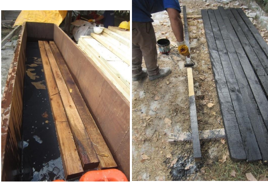
Fotoğraf 4. 112. Ahşap hatıllara koruyucu malzeme sürülmesi (A.ASLAN)
