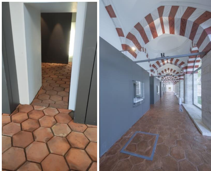
Fotoğraf 4. 141. Uygulaması yapılan şeshane döşemesi görünümü(A.ASLAN)
