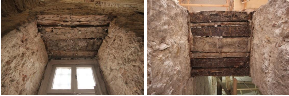
Fotoğraf 4. 35. 2 No'lu odanın pencere ve kapı üstü ahşap hatıllarının sökülmeden önceki durumu (A.ASLAN)
