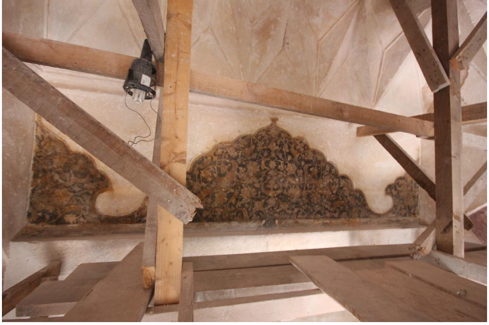
Fotoğraf 4. 23. Araştırma raspası sonrası Giriş kapısı üzerinde çıkan bezeme (A.ASLAN)
