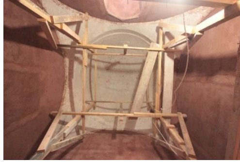
Fotoğraf 4. 51. Odalarda yapılan horasan dolgu (A.ASLAN)
