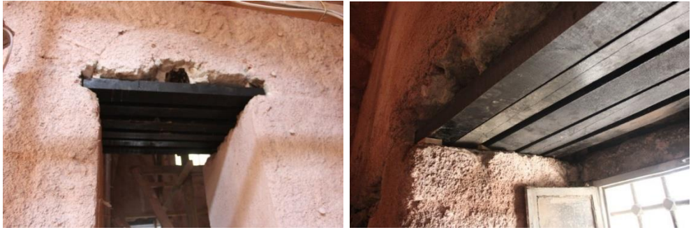
Fotoğraf 4. 39. Yeni yapılan meşe ahşap hatılların görünümü (A.ASLAN)
