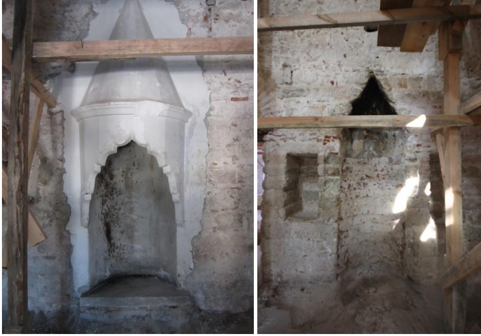
Fotoğraf 4. 7. Niteliksiz alçı yaşmak sökülmesi (A.ASLAN)
