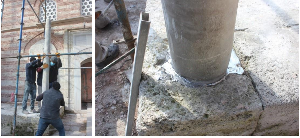
Fotoğraf 4. 98. Saçak altı özgün mermer sütunların yerleştirilmesi (A.ASLAN)
