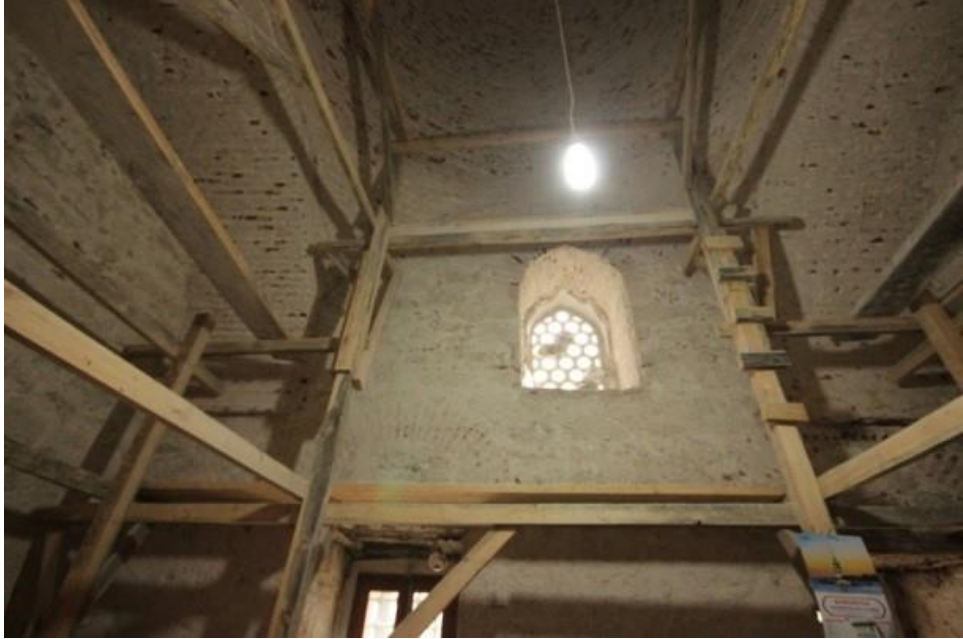
Fotoğraf 4. 28. İtinalı çimento raspası sonrası ortaya çıkarılan 3 No'lu odanın özgün malzemesi (Abdullah.ASLAN)
