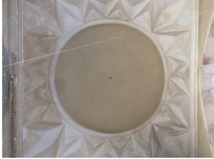
Fotoğraf 4. 63. Giriş kubbesinde yerinde döküm tekniği ile yapılan mukarnas uygulaması (A.ASLAN)
