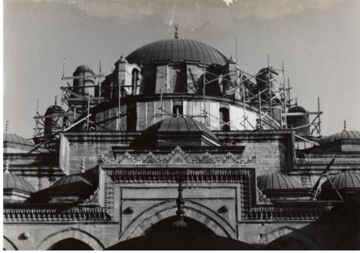
Şekil 2. 27. İstanbul II. Beyazıt Camii Ana kubbe kasnağı iskele detayı 1960'lar (Ali Saim Ülgen Arşivi, Salt Araştırma)
