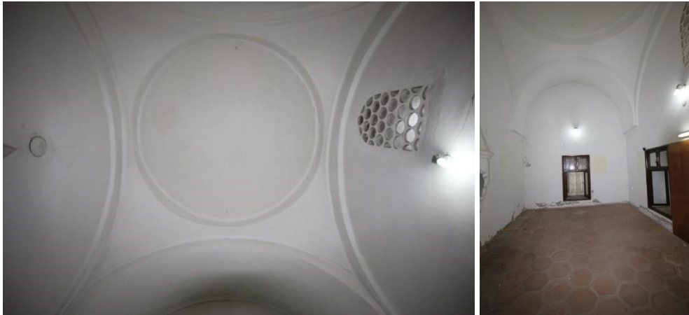
Fotoğraf 4. 26. Çimento raspası öncesi 3 No'lu odanın mevcut durumu (Abdullah. ASLAN)
