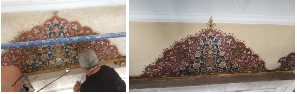
Fotoğraf 4. 67. Giriş kapısı üzerinde bulunan tezyinatın canlandırma uygulamasının yapılması (A.ASLAN)
