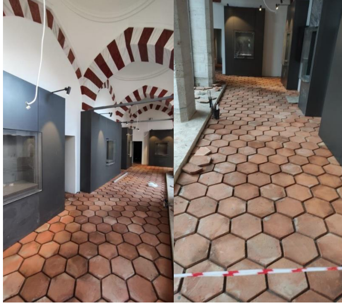
Fotoğraf 4. 140. Uygulaması yapılan şeshane döşemesi görünümü (A.ASLAN)
