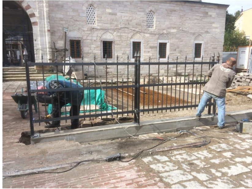
Fotoğraf 4. 132. Korkuluk montajının yapılması (A.ASLAN)
