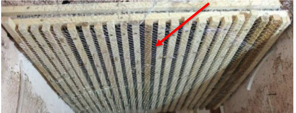
Fotoğraf 4. 54. Bağdadi sıva detayı (A.ASLAN)
