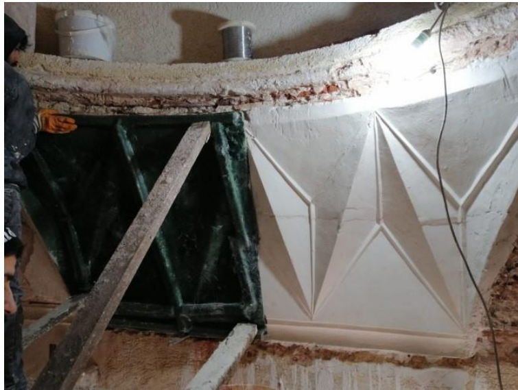
Fotoğraf 4. 62. Giriş kubbesinde yerinde döküm tekniği ile yapılan mukarnas uygulaması (A.ASLAN)
