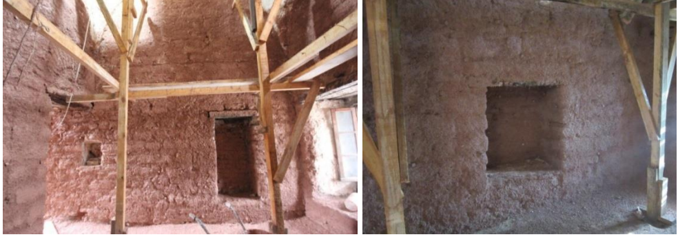
Fotoğraf 4. 51. Odalarda yapılan horasan dolgu (A.ASLAN)
