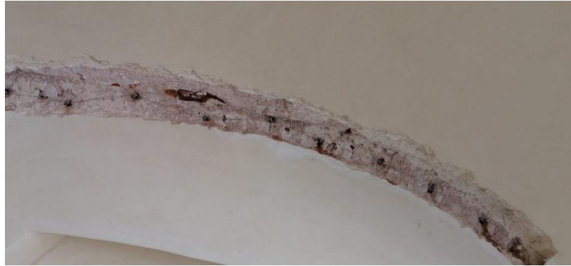
Fotoğraf 4. 64. Revaklarda bulunan profilli silmelerin yerinde döküm tekniği ile uygulamasının yapılması (A.ASLAN)
