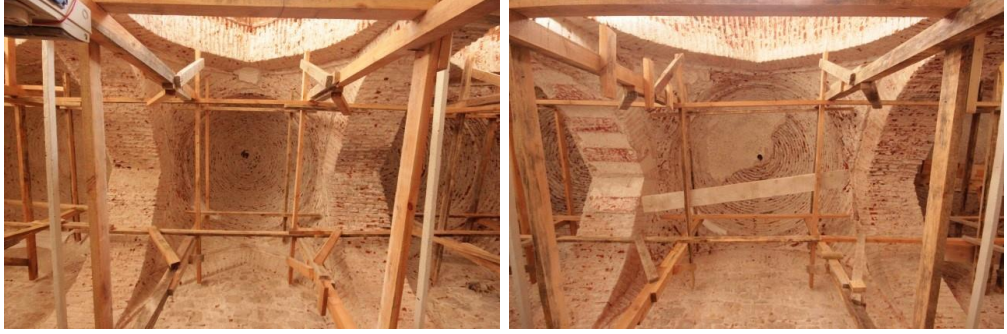
Fotoğraf 4. 32. İtinalı çimento raspası sonrası kuzeybatı kolu revaklarının görünümü (A.ASLAN)
