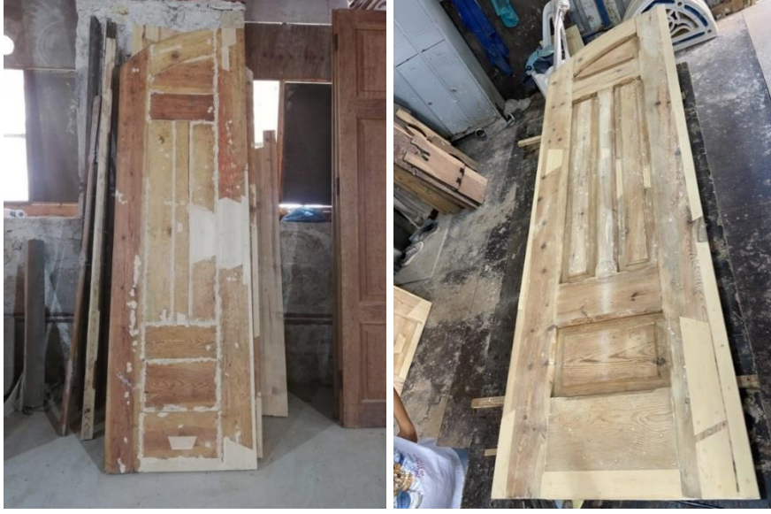
Fotoğraf 4. 93. Ahşabın bozulan kısımlarında onarım yapılması (A.ASLAN)
