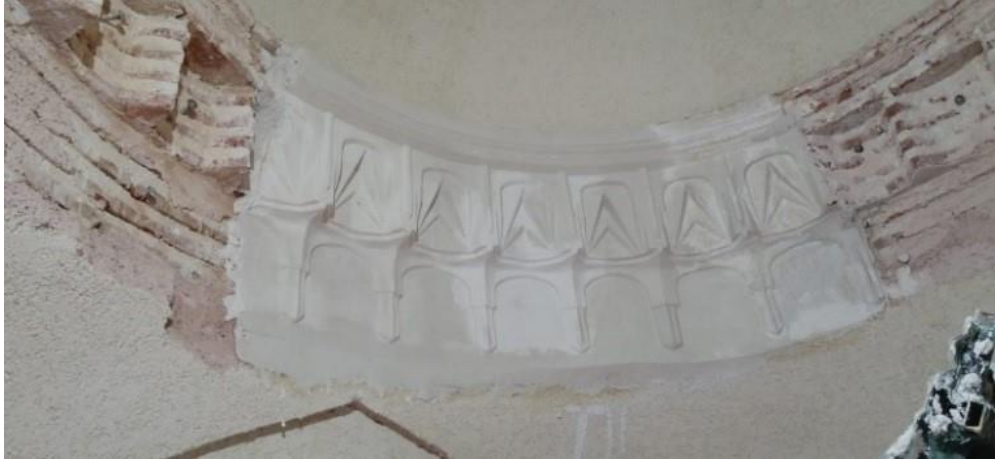
Fotoğraf 4. 60. RK1 de yerinde döküm tekniği ile yapılan mukarnas uygulaması (A.ASLAN)
