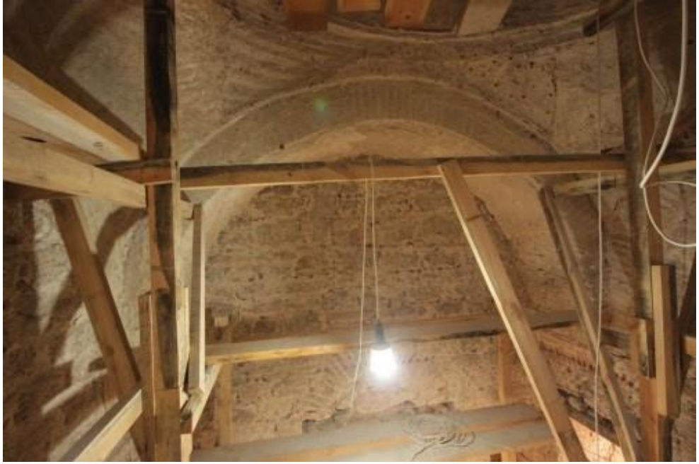
Fotoğraf 4. 30. İtinalı çimento raspası sonrası çıkarılan 10 No'lu odanın özgün malzemesi (A.ASLAN)
