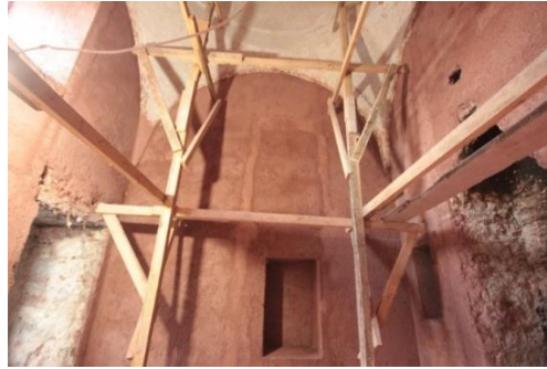
Fotoğraf 4. 52. Odalarda yapılan horasan sıva (A.ASLAN)
