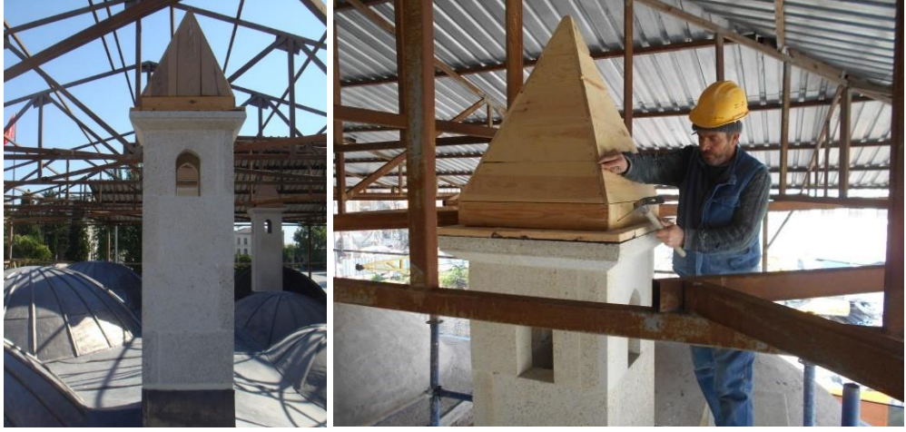
Fotoğraf 4. 49. Bacalara ahşap k lah yapılması (A.ASLAN)
