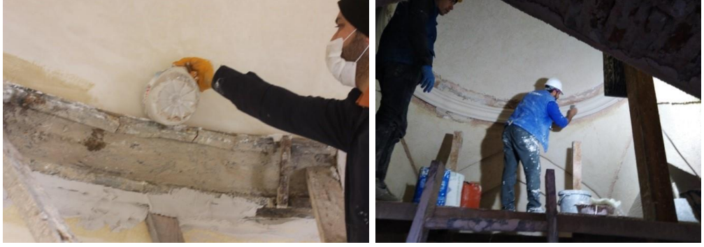
Fotoğraf 4. 65. Revaklarda bulunan profilli silmelerin yerinde döküm tekniği ile uygulamasının yapılması (A.ASLAN)
