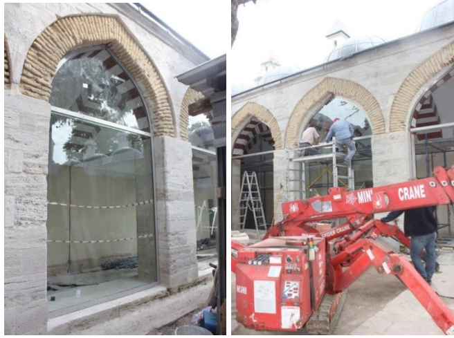
Fotoğraf 4. 128. Revakların temperli cam ile kapatılması (A.ASLAN)
