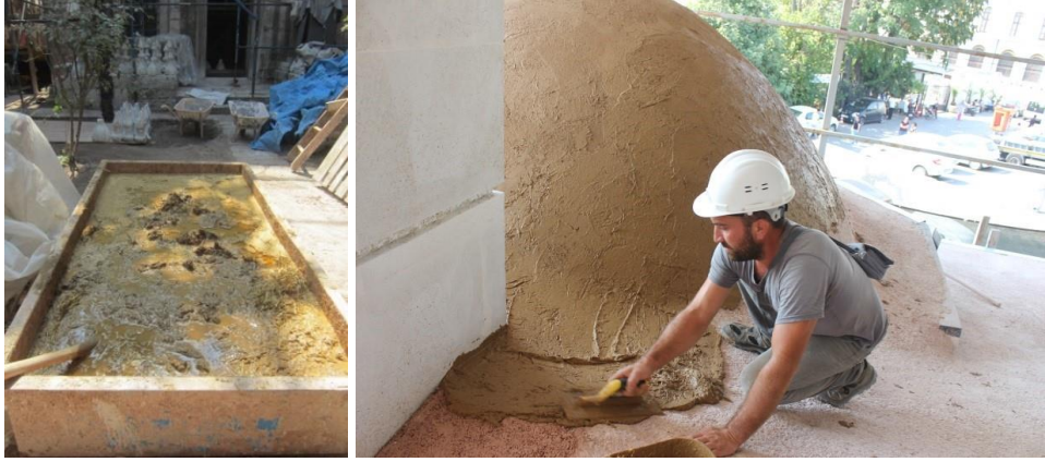
Fotoğraf 4. 110. Çamur sıva uygulaması (A.ASLAN)
