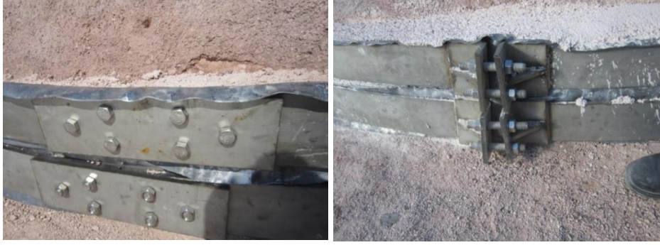
Fotoğraf 4. 121. Paslanmaz çelik çekme çemberi ile kuşaklama yapılması (A.ASLAN)
