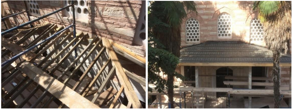
Fotoğraf 4. 99. Ahşap saçak yapılması (A.ASLAN)
