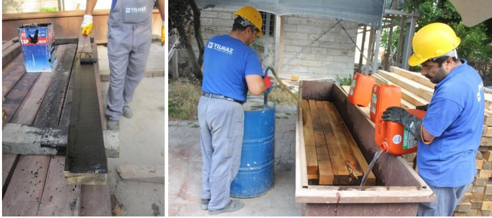
Fotoğraf 4. 37. Meşeden yeni ahşap hatılların empenye edilmesi ve koruyucu astar malzeme sürülmesi (A.ASLAN)
