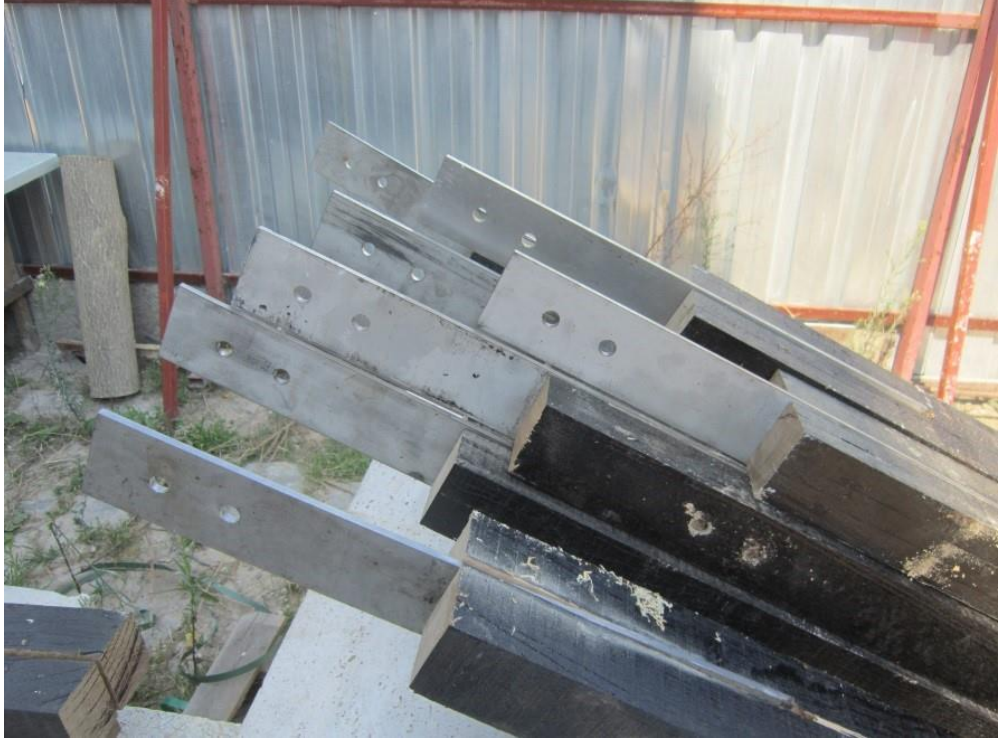
Fotoğraf 4. 38. Ahşap hatıllara yapılan paslanmaz lamalar (A.ASLAN)
