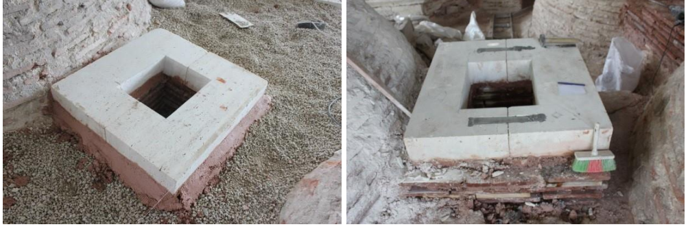
Fotoğraf 4. 46. Baca taşlarının paslanmaz kenetler ile mesnetlenmesi (A.ASLAN)
