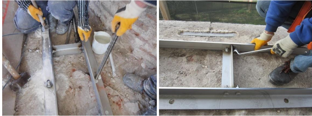
Fotoğraf 4. 120. Paslanmaz çelik hatıl uygulaması (A.ASLAN)
