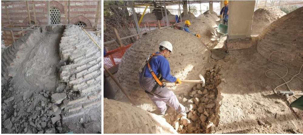
Fotoğraf 4. 106. Niteliksiz dolgu malzemelerinin yapıdan uzaklaştırılması (A.ASLAN)
