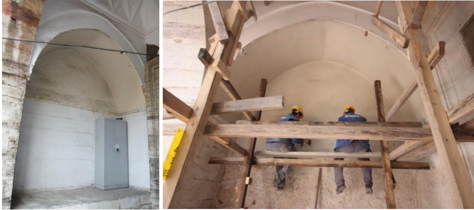
Fotoğraf 4. 33. İtinalı çimento raspası öncesi giriş mahalinin mevcut durumu (A.ASLAN)
