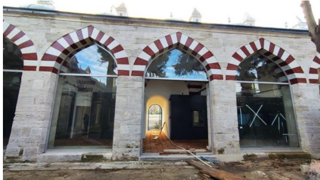
Fotoğraf 4. 129. Revakların temperli cam ile kapatılması (A.ASLAN)
