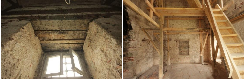
Fotoğraf 4. 29. İtinalı çimento raspası sonrası çıkarılan 10 No'lu odanın özgün malzemesi (A.ASLAN)
