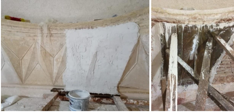
Fotoğraf 4. 61. Giriş kubbesinde yerinde döküm tekniği ile yapılan mukarnas uygulaması (A.ASLAN)
