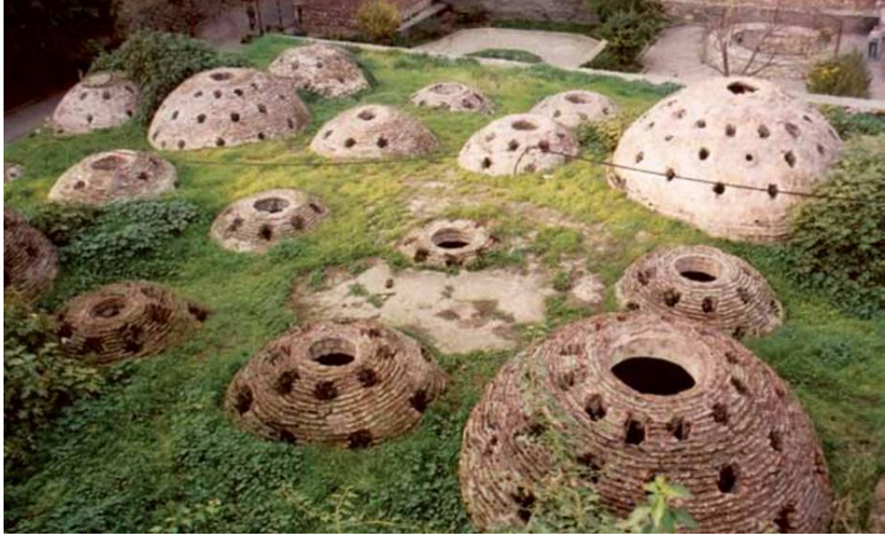
Şekil 2. 46. Beyazıt Hamamı, 2002-2015 yılları restorasyon çalışması öncesi İlıklık- sıcaklık kubbe görünümü (Eyüpgiler,2018)
