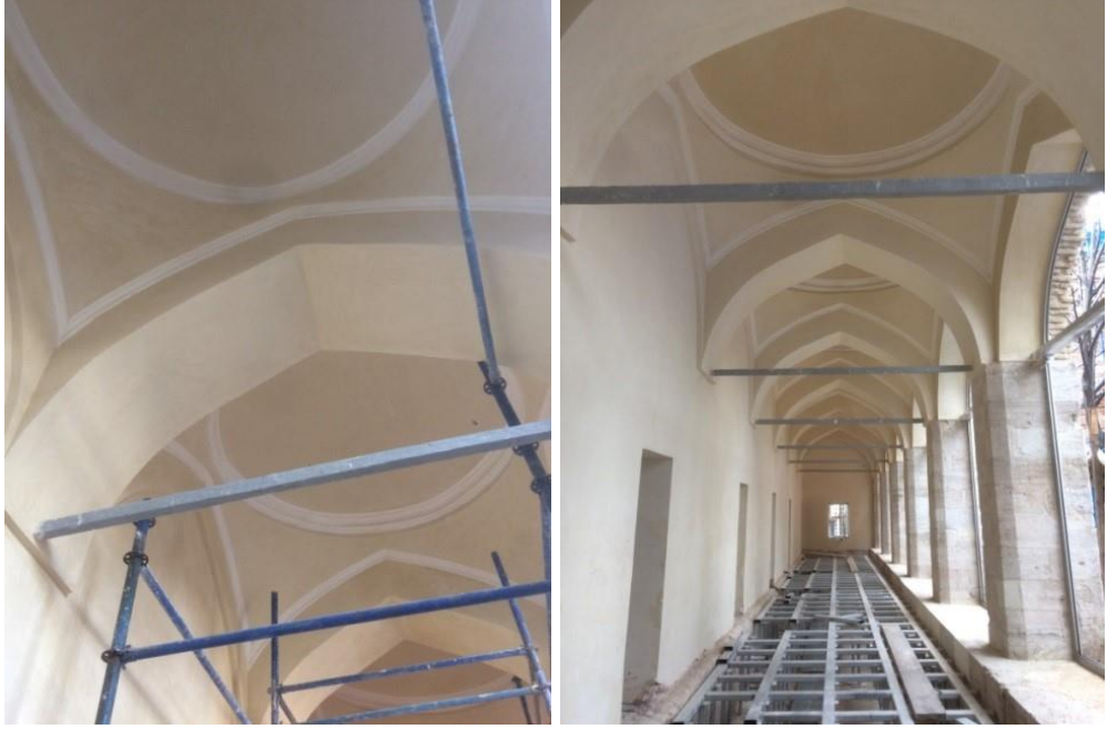
Fotoğraf 4. 55. Revaklarda nefaset sıva yapılması (A.ASLAN)
