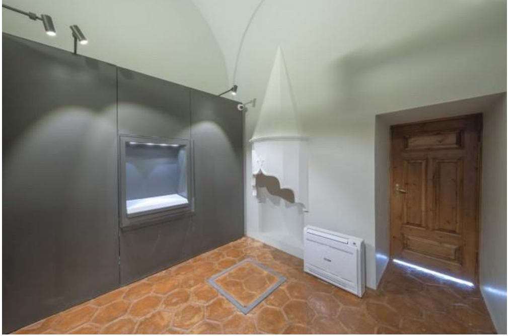
Fotoğraf 4. 144. VRF iç ünite (A.SLAN)
