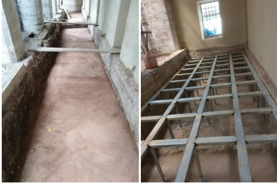
Fotoğraf 4. 124. Döşeme altı tesisat geçişleri için paslanmazdan yükseltme platformu yapılması (A.ASLAN)
