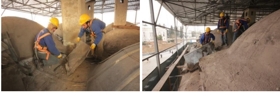
Fotoğraf 4. 101. Mevcut kurşun kaplamaların sökülmesi (A.ASLAN)
