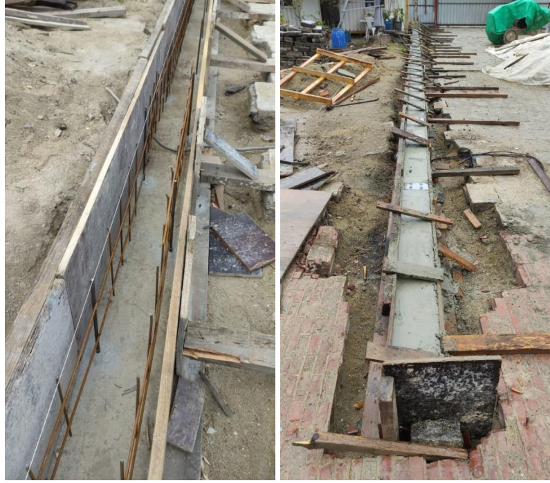
Fotoğraf 4. 131. Bahçe duvar temeli yapılması (A.ASLAN)
