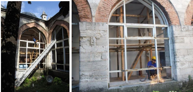
Fotoğraf 4. 1. Revaklı avludan sökülen muhdes demir doğramalar (A.ASLAN)
