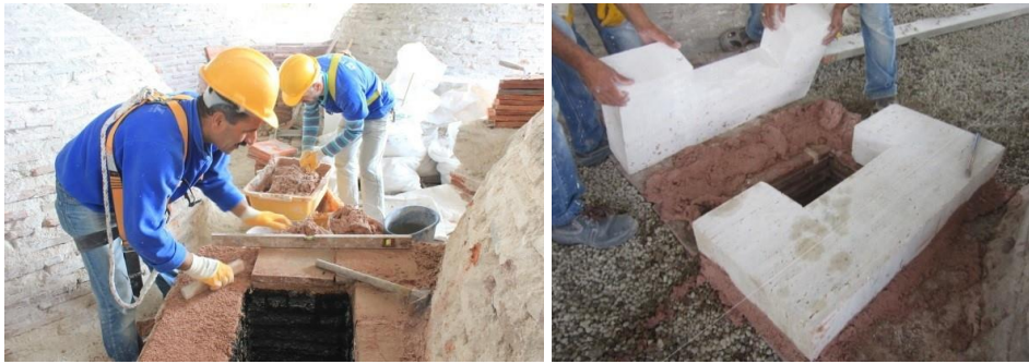
Fotoğraf 4. 45. Medrese bacalarının yeniden örülmesi (A.ASLAN)
