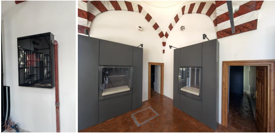
Fotoğraf 4. 151. Yangın tesisat sistemi (A.ASLAN)
