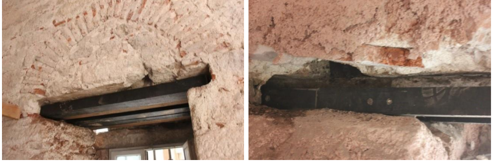
Fotoğraf 4. 40. Yeni yapılan meşe ahşap hatılların görünümü (A.ASLAN)
