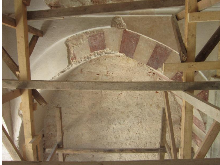
Fotoğraf 4. 19. Çimentolu sıva raspa sonrası kemerlerde ortaya çıkan kırmızı-beyaz taş taklidi(A.
