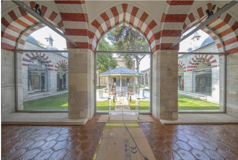
Fotoğraf 4. 71. Medrese genelinde ve giriş kısmındaki kemerlerde bulunan kırmızı-beyaz taş taklidi (A.ASLAN)
