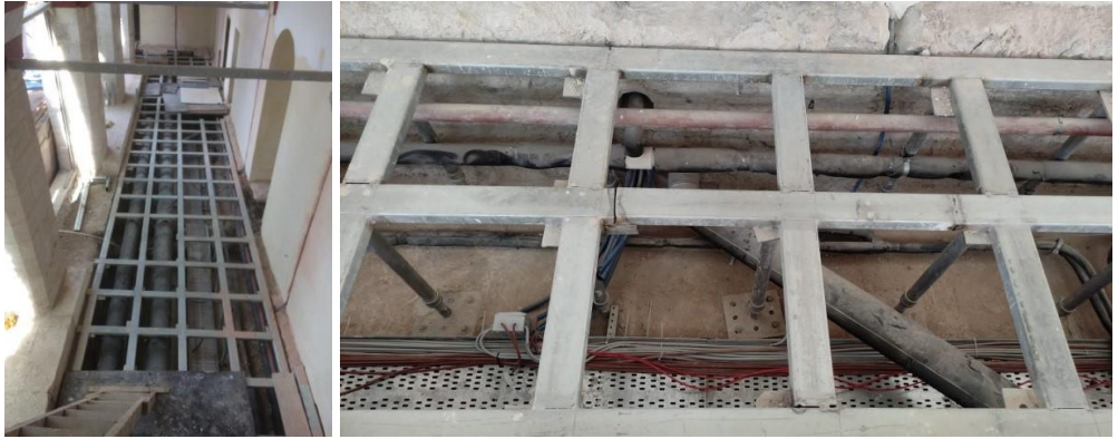
Fotoğraf 4. 143. Yükseltilmiş döşeme altından tesisat yapılması (A.ASLAN)
