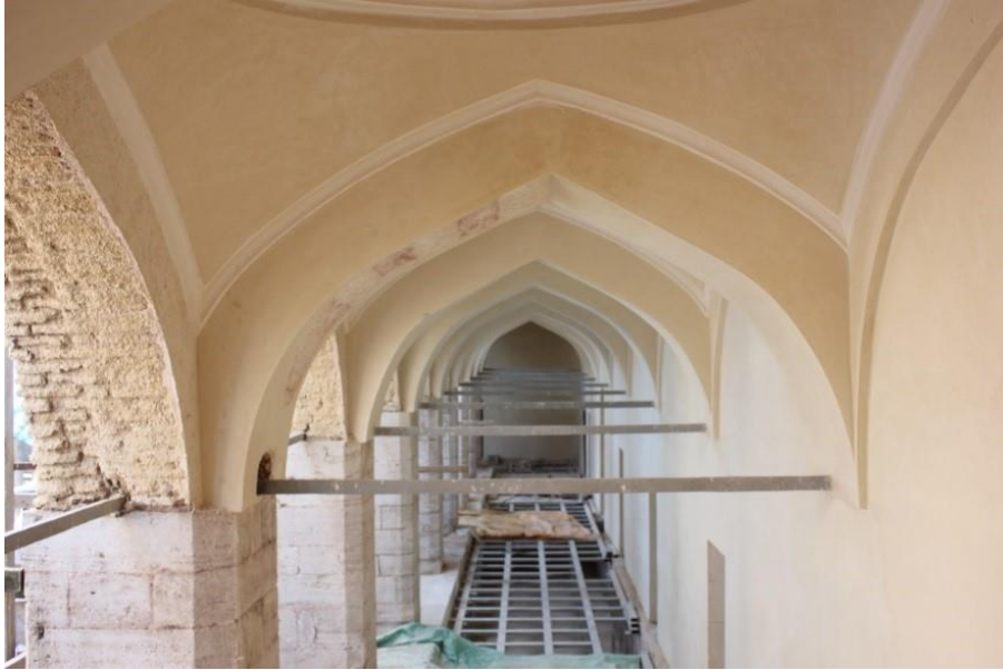
Fotoğraf 4. 66. Revaklarda bulunan profilli silmelerin yerinde döküm tekniği ile uygulamasının yapılması (A.ASLAN)
