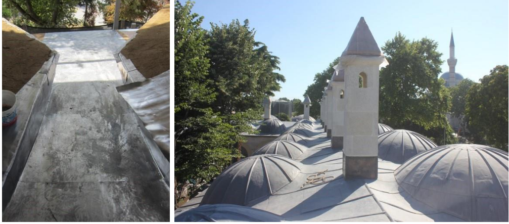
Fotoğraf 4. 116. Kurşun kaplama sonrası kubbe görünümü (A.ASLAN)
