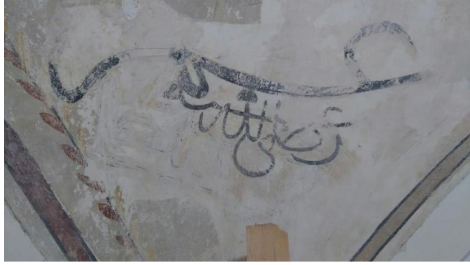
Fotoğraf 4. 15. Araştırma raspası sonrası pantişte çıkan hat (Ömer r.a) (A.ASLAN)
