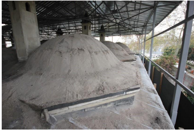
Fotoğraf 4. 102. Mevcut kurşun kaplamalarının sökülmesi (A.ASLAN)
