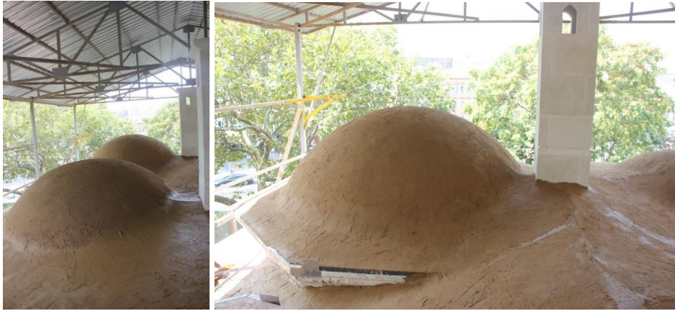
Fotoğraf 4. 111. Çamur sıva uygulaması (A.ASLAN)
