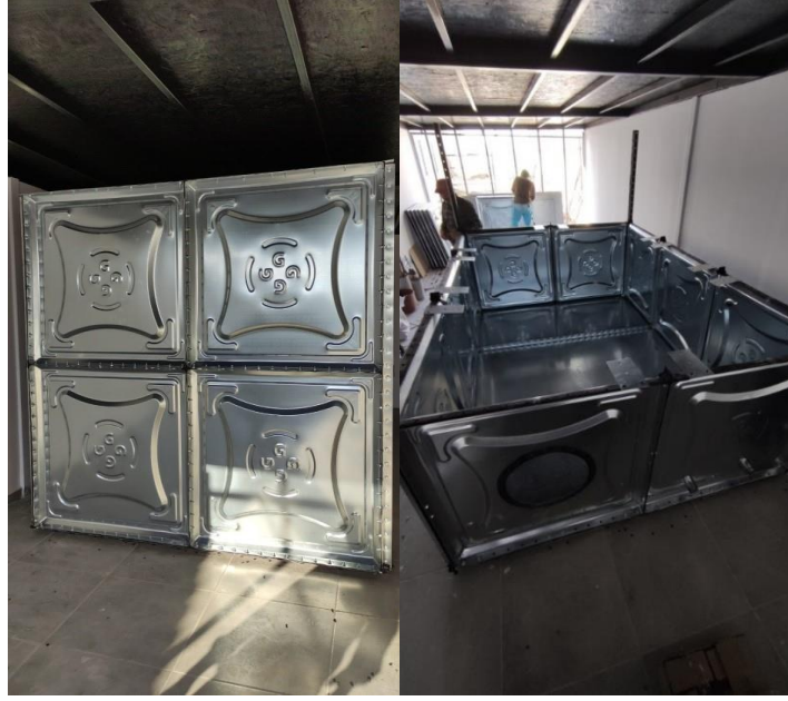
Fotoğraf 4. 149. 15 tonluk yangın deposu (A.ASLAN)
