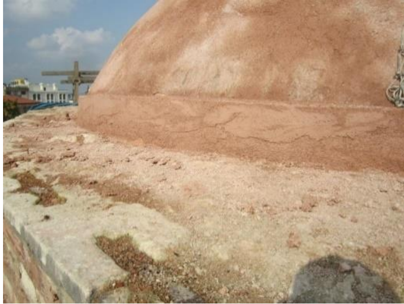
Fotoğraf 4. 123. Paslanmaz çelik çekme çemberinin horasan siva ile kapatılması (A.ASLAN)
