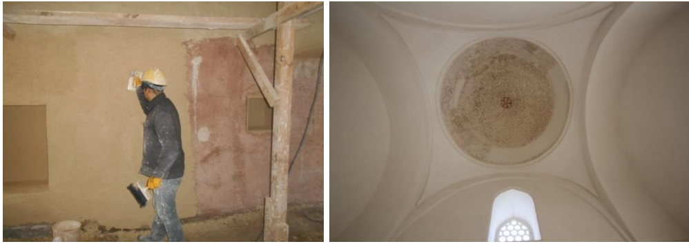
Fotoğraf 4. 56. Odalarda Nefaset sıva yapılması (A.ASLAN)
