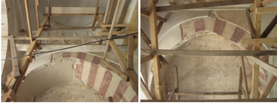
Fotoğraf 4. 34. İtinalı çimento raspası sonrası giriş mahali kemerinde çıkan kırmızı-beyaz taş taklidi bezeme (A.ASLAN)
