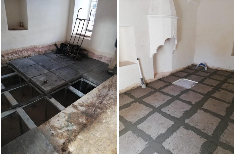
Fotoğraf 4. 127. Tesisat kanallarının, tesisat kapaklarıyla kapatılması (A.ASLAN)
