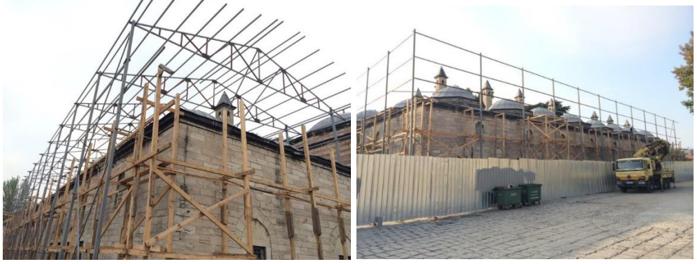
Fotoğraf 4. 103. Geçici çatı yapılıması (A.ASLAN)
