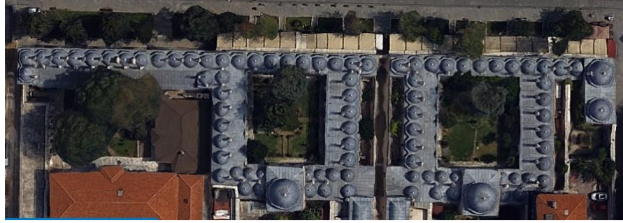
Şekil 1. 10. Süleymaniye Külliyesi Medresesi üstten görünüm (İBB, 3B İstanbul)
