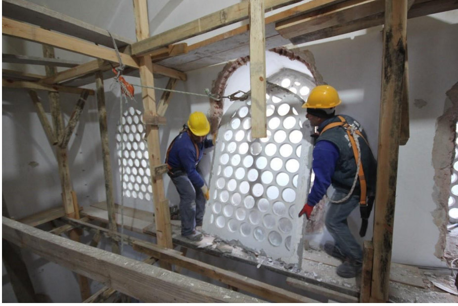
Fotoğraf 4. 4. Beton içlik pencerelerin sökülmesi (A.ASLAN)
