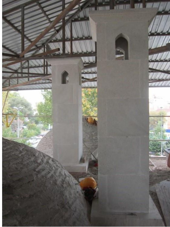
Fotoğraf 4. 48. Medrese bacalarının yeniden örülmesi(A.ASLAN)
