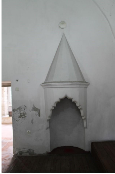
Fotoğraf 4. 6. Çimento esaslı yaşmak (A.ASLAN)
