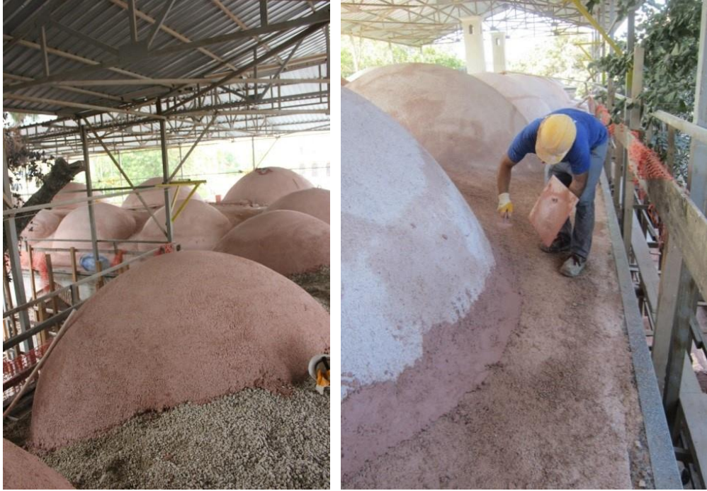
Fotoğraf 4. 109. Kubbe ve tabanların horasan sıva ile sıvanması (A.ASLAN)
