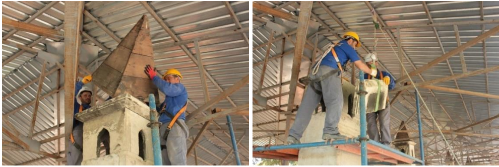
Fotoğraf 4. 43. Medrese bacalarının sökülmesi (A.ASLAN)
