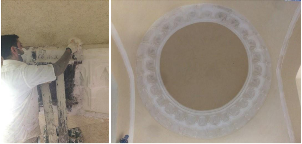
Fotoğraf 4. 59. RK1 de yerinde döküm tekniği ile yapılan mukarnas uygulaması (A.ASLAN)
