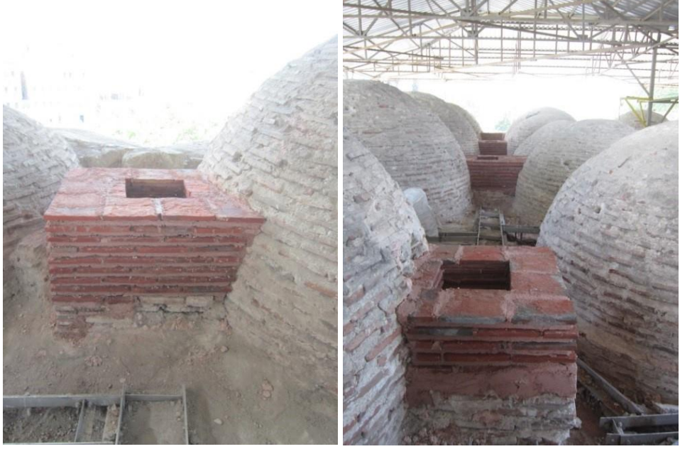
Fotoğraf 4. 44. Medrese bacalarının yeniden örülmesi (A.ASLAN)
