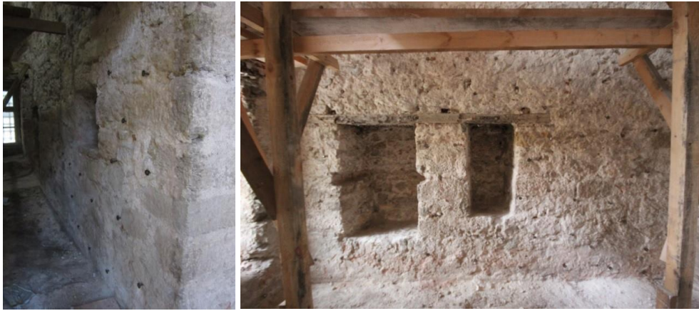
Fotoğraf 4. 50. Çimento raspası sonrası ortaya çıkan paslanmış sıva çivileri (A.ASLAN)
