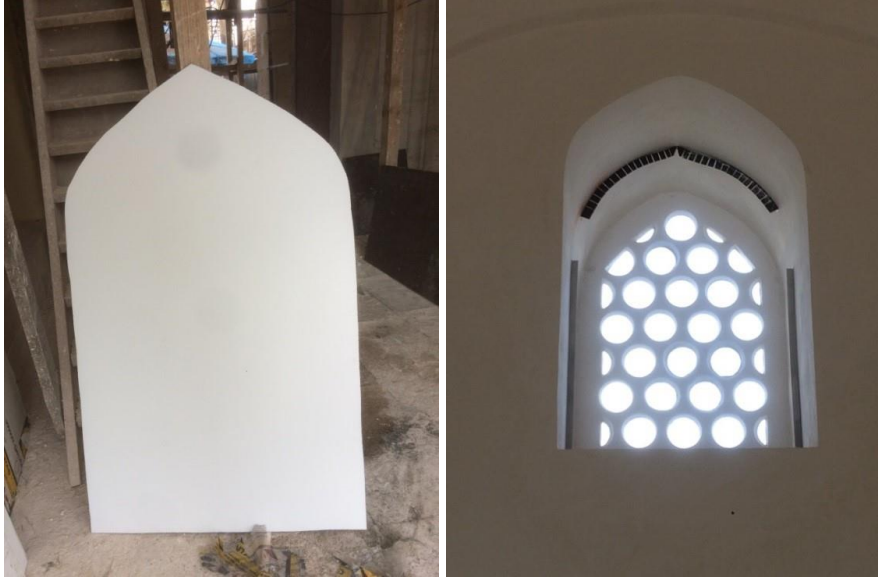
Fotoğraf 4. 134. Pencereleerde karartma yapılması (A.ASLAN)
