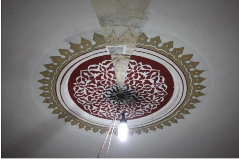
Fotoğraf 4. 11. Dershane kubbesi kalemişi araştırma raspası (A.ASLAN)
