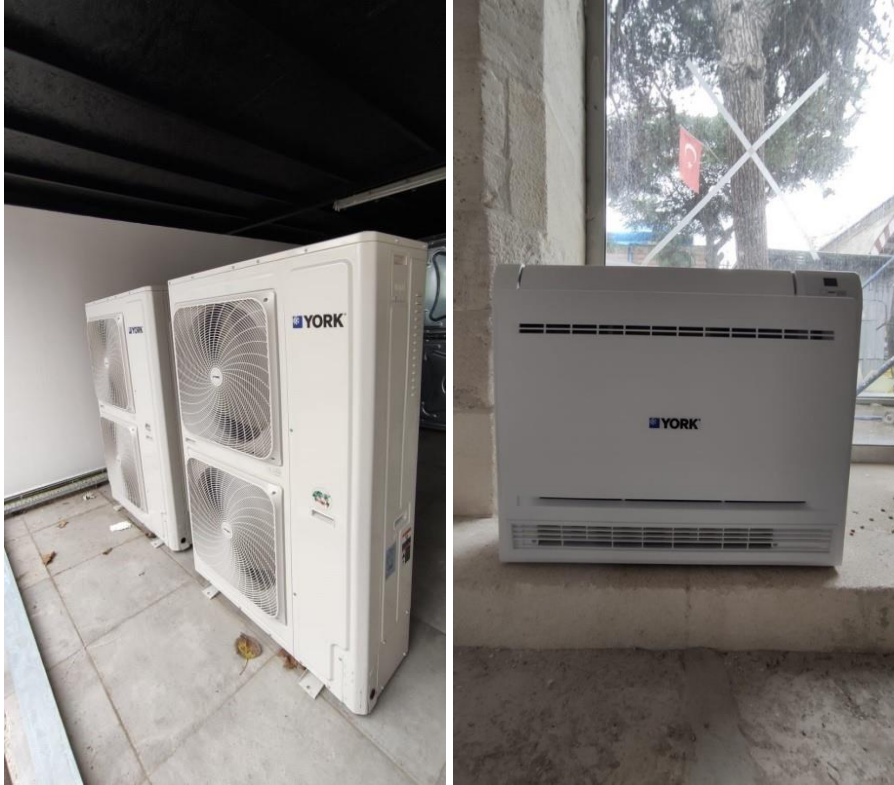
Fotoğraf 4. 145. VRF dış ünite (A.SLAN)
