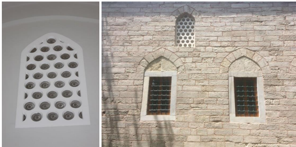
Fotoğraf 4. 91. Geleneksel yöntemler ile yapılan dışlık pencerelerin görünümü (A.ASLAN)
