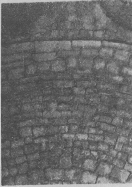
Resim : 30 — Cami kubbesinin içten görünüşü.
