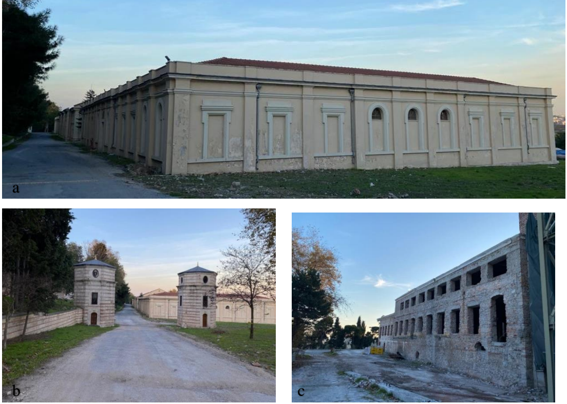
Şekil 57. a) Aziziye Depoları, b) Güvercinlik kuleleri ve c) Matbaa Binası (2021)
