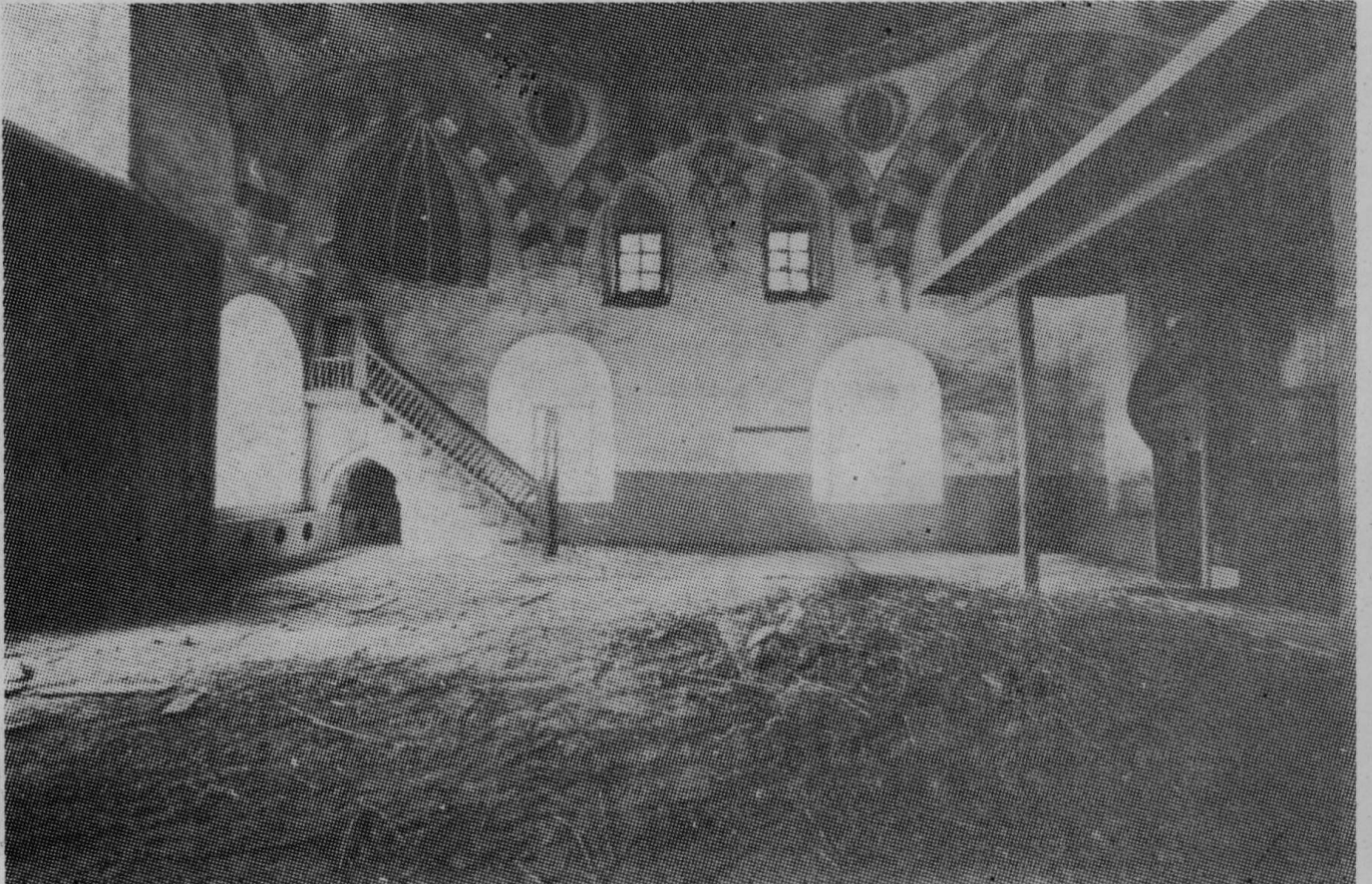
Resim : 15 Sağ yan duvarın dahili görünüşü
