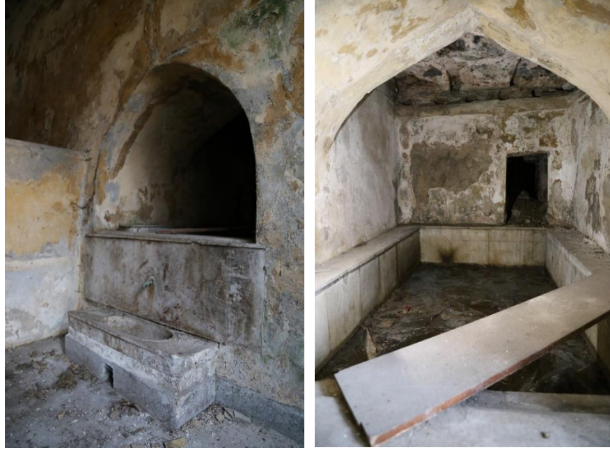
Şekil 4. 9: Ayios Eftimios Ayazması, kanal, havuz ve teknesi,2020
