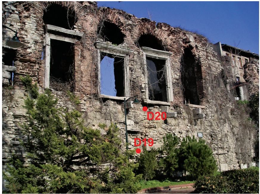
Şekil 4: D19 (Bukoleon Sarayı derz harcı) ve D20 (Bukoleon Sarayı örgü harcı) numaralı harç örneği alınan yerler (Plan, Müller-Wiener 1977).
