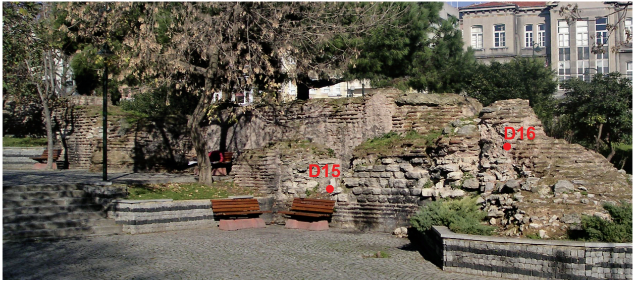
Şekil 5: D14 (Lausus S. derz harcı), D15 (derz harcı) ve D16 (Lausus S. örgü harcı) numaralı harç örneği alınan yerler (Plan, Müller-Wiener 1977).
