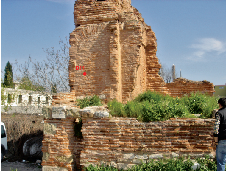
Şekil 3: D11 (Büyük Saray derz harcı) ve D12 (Büyük Saray çekirdek harcı) numaralı harç örneği alınan yerler
