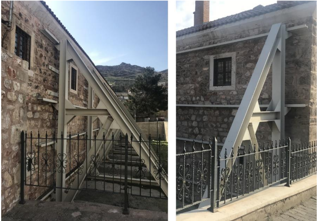
Fotoğraf 2 93. Deveciler Hanı Batı Cephe Görüntüsü (2021)
