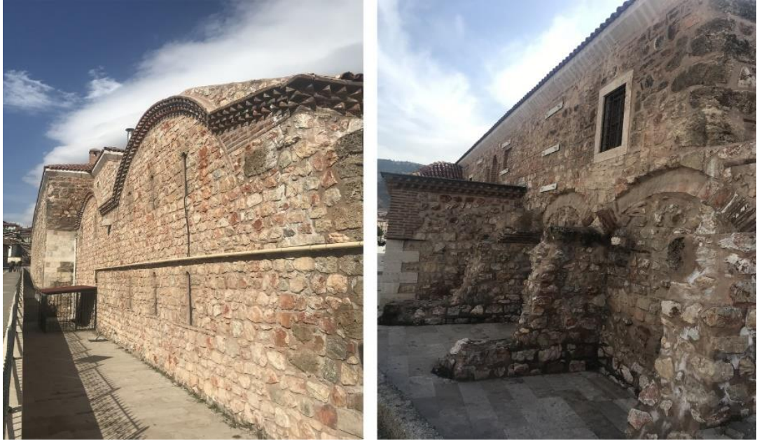
Fotoğraf 2 92. Deveciler Hanı Güney Cephesi ve Kuzey Cephesi Görüntüsü (2021)
