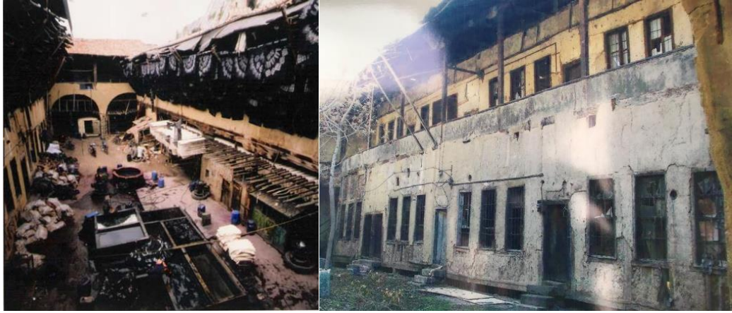
Fotoğraf 2 44. Yazmacılar Hanı avlu görünüşü (Restorasyon Öncesi) (Kaplan, 2007, S.46)
