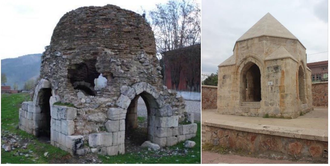
Fotoğraf 2 55. Erenler Türbesi Restorasyondan Önceki Durum (Solda) (Bilgen, 2014, sy.304), Erenler Türbesi (Sağda)(2021)
