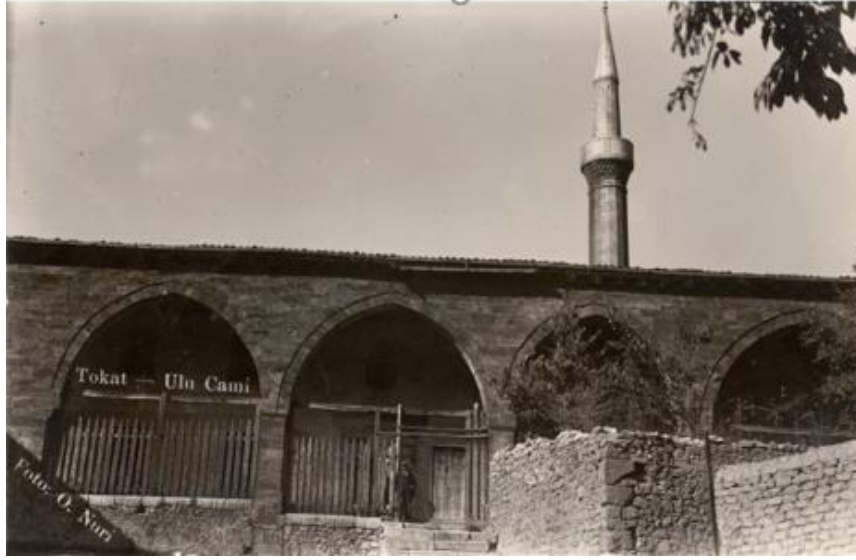
Fotoğraf 2 16. Ulu Cami Doğu Cephesi Görüntüsü, Ali Sami Ülgen Arşivi (Ülgen, 2022)
