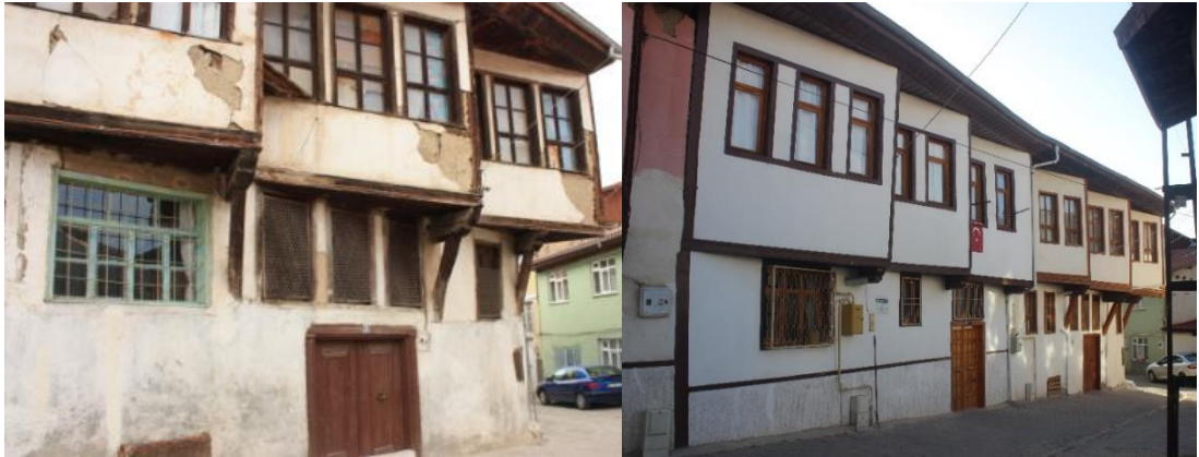
Fotoğraf 2 108. Bey Hamam Sokak Konut Mimarisi (Solda) (Akçay, 2013,sy.146) (2021) Görünümü (Sağda)
