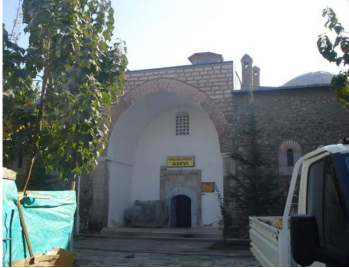
Fotoğraf 2 83. Pir Ahmet Bey (Horozoğlu) Zaviyesi (Akın, 2009, sy. 127)
