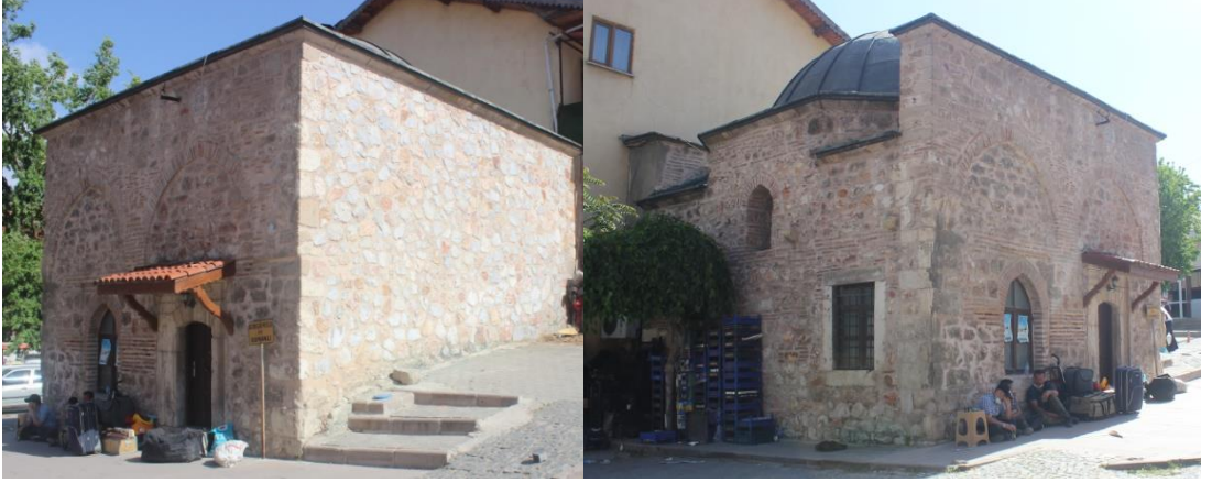
Fotoğraf 2 57. Kazancılar Mescidi Kuzey Cephesi (2021)
