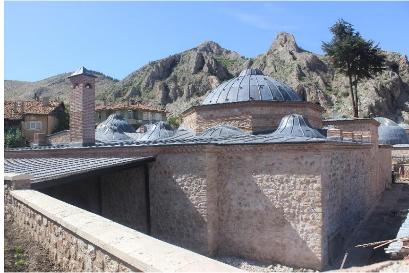
Fotoğraf 2 48. Sultan Hamamı Güney Doğu Görüntüsü (2021)
