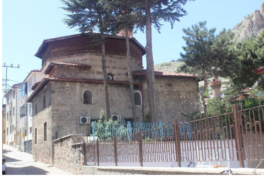
Fotoğraf 2 26. Alaca Mescit Güneydoğu Cephesi (2021)
