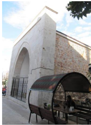
Fotoğraf 2 73.Pir Ahmet Bey Türbesi Güneydoğu Cephesi (Bilgen, 2014, sy. 327)
