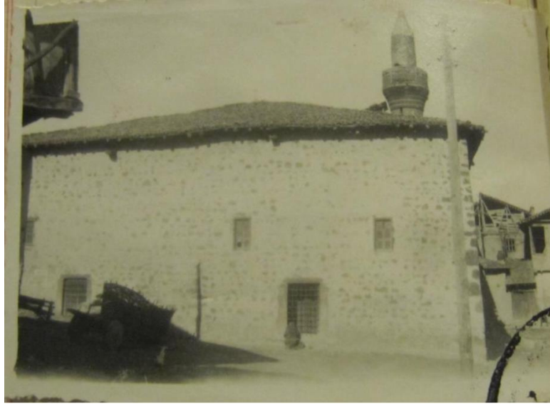
Fotoğraf 2 12. Garipler Cami Güney Cephesi, (Bilgen, 2014 sy. 84).
