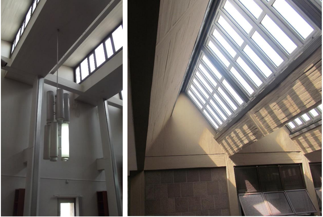
Şekil 2.25: TTK kütüphane ve iç avlu mekân etkisini oluşturan taşıyıcı elemanları
