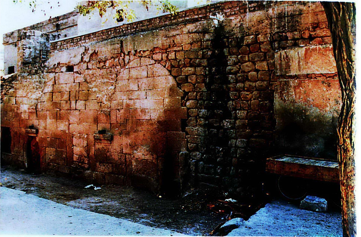
Res. 26: Sıbyan Mektebi'nin kuzeyindeki mekanların genel görünüşü.
