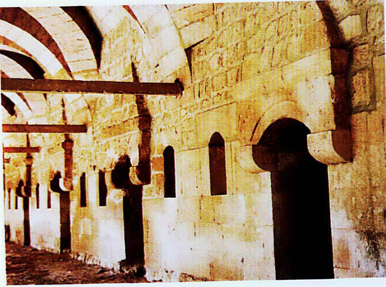
Res. 9: Revaklı avludaki ocak ve nişlerden detay.
