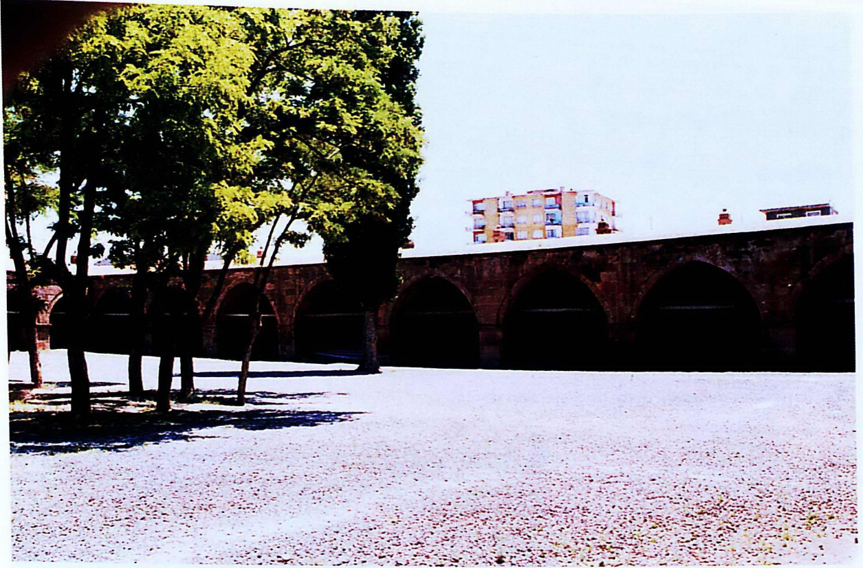
Res. 6: Kervansarayın güney revağı genel görünüşü.
