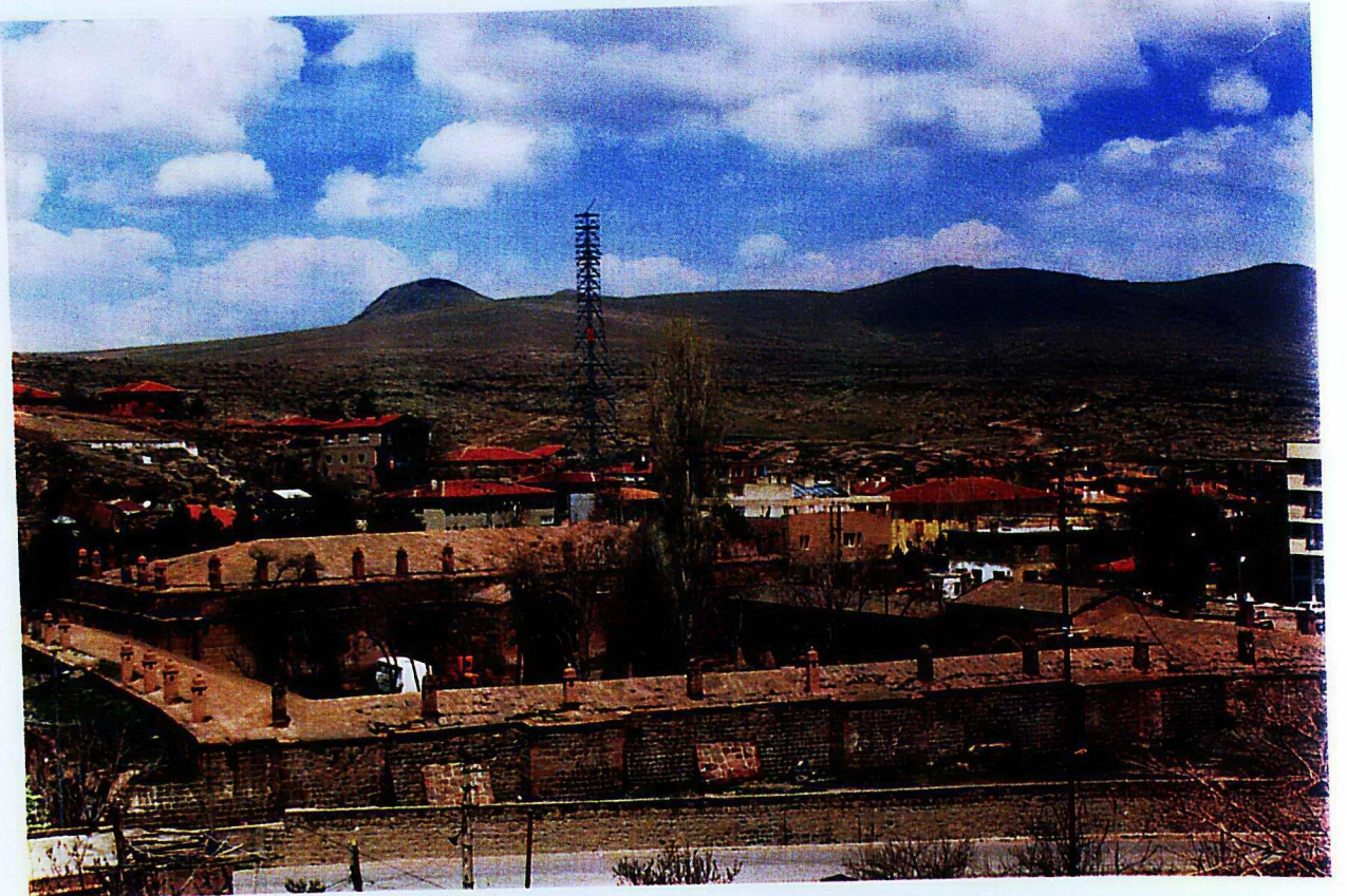
Res. 3: Kervansarayın genel görünüşü.
