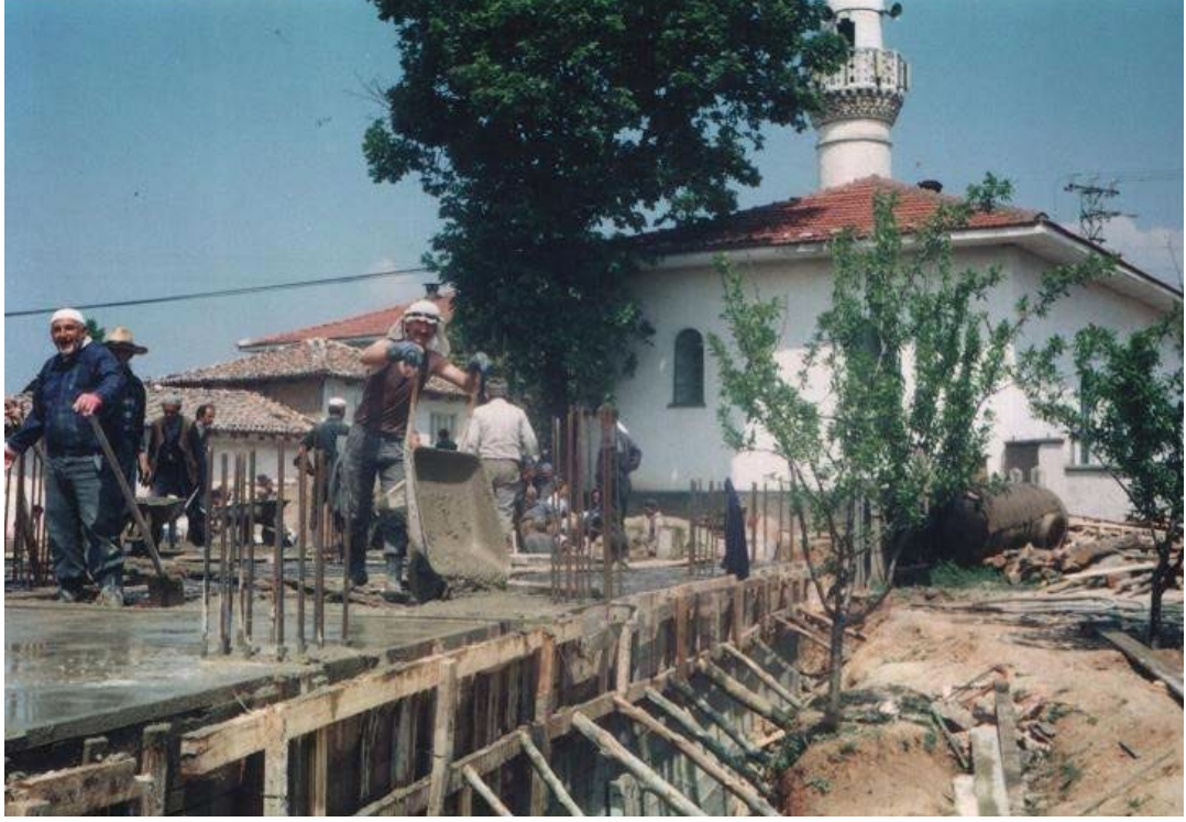
Şekil 2.3: Bursa Turanköy’de Köylüler Tarafından İmece Usulü Yapılan Cami İnşaatı (K2, 1992)
