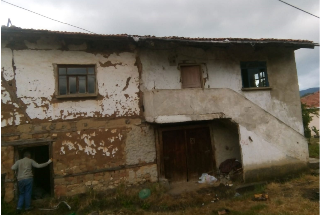
Şekil 4.1: K3'ün Eski Konut Yapısı (Yapı sahibi tarafından çekilmiştir.)
