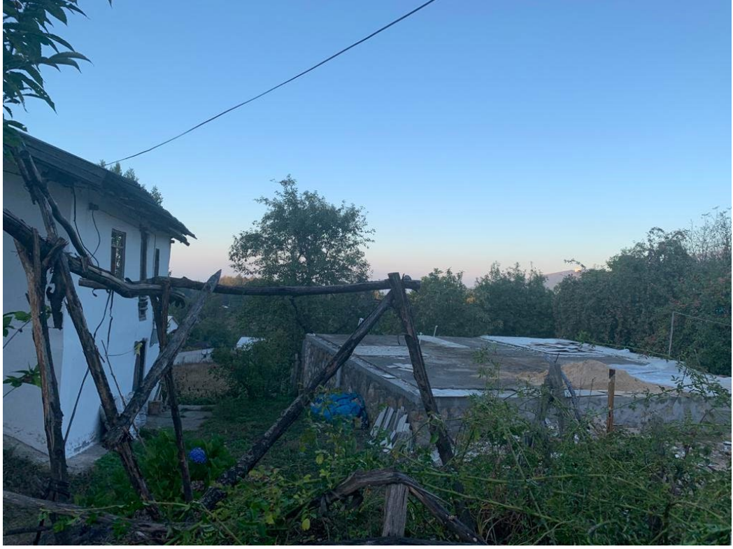
Şekil 4.11: Kaçak Yapılması Nedeniyle Yıkılan Ev (Erkan, 2020)
