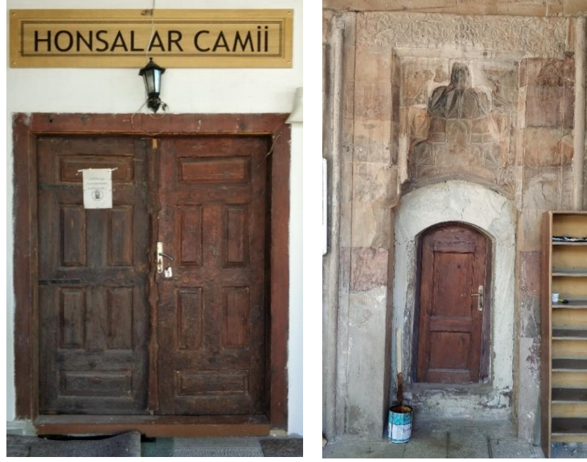
Resim 5.12 : Honsalar Camii'nin ana kapısı ve minare kapısı (Ağustos 2019)
