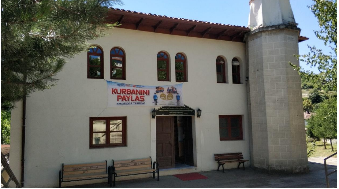
Resim 5.77 : Kötürüm Beyazıd Camii'nin dış görünümü (Ağustos 2019)
