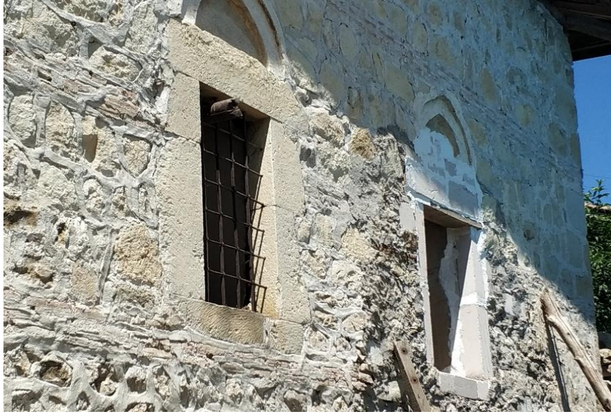
Resim 6.2 : Mehran Camii'nin doğu cephesinde giderilen hasar (Ağustos 2019)
