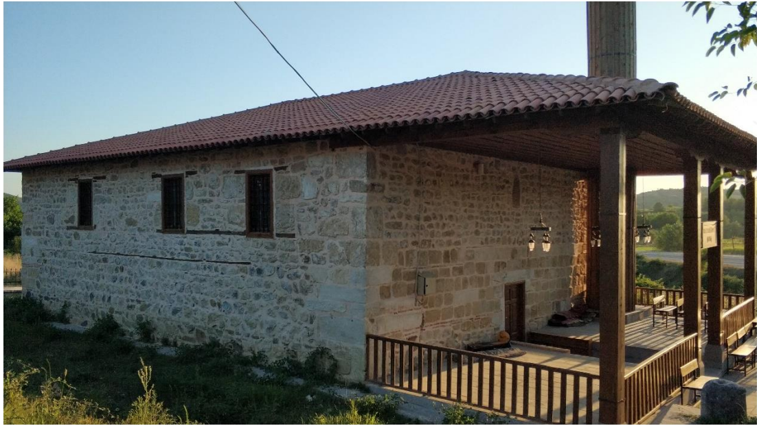
Resim 5.86 : Kornapa Camii'nin dış görünümü (Ağustos 2019)
