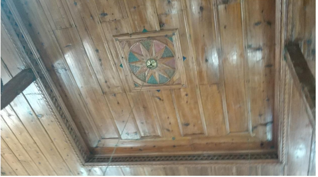
Resim 5.51 : Bolatlar Köyü Camii'nin tavanı (Ağustos 2019)
