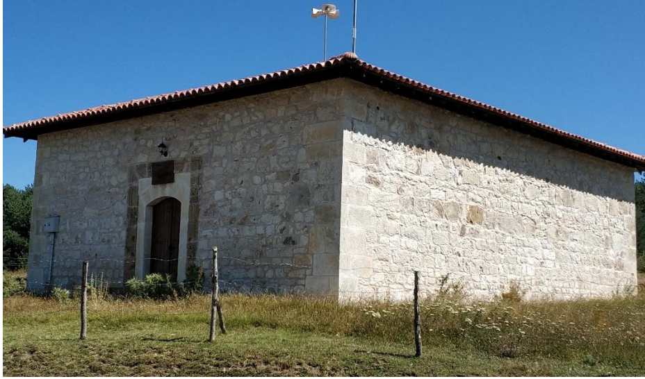
Resim 5.53 : Akmesic Devire Hatun Camii'nin dış görünümü (Ağustos 2019)
