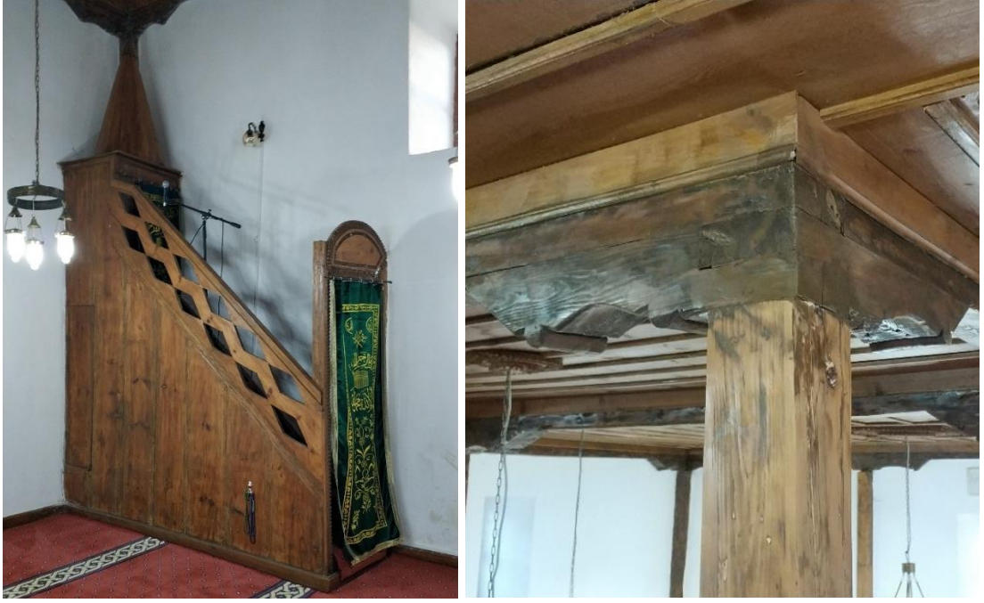
Resim 5.89 : Kornapa Camii'nin minberi ve ahşap dikmelerin birleşme detayı (Ağustos 2019)
