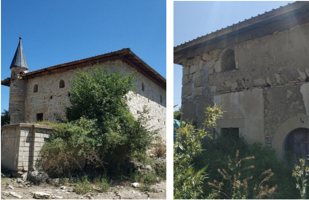
Resim 5.31 : Mehran Camii'nin güneybatıdan ve kuzeyden görünümü (Ağustos 2019)
