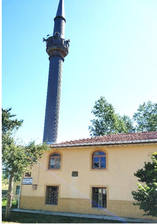
Resim 5.44 : Ali Paşa Camii'nin dış görünümü (Ağustos 2019)
