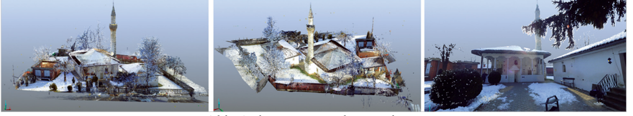
Şekil 1. Optik ve scanner sistem ile yapının ölçümü.
