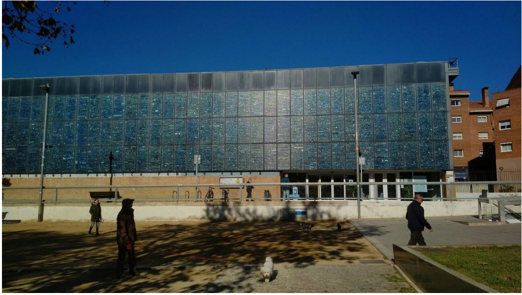
Resim 5.14: Güney cephesini kaplayan PV panellerden görünüm (Url-33).
