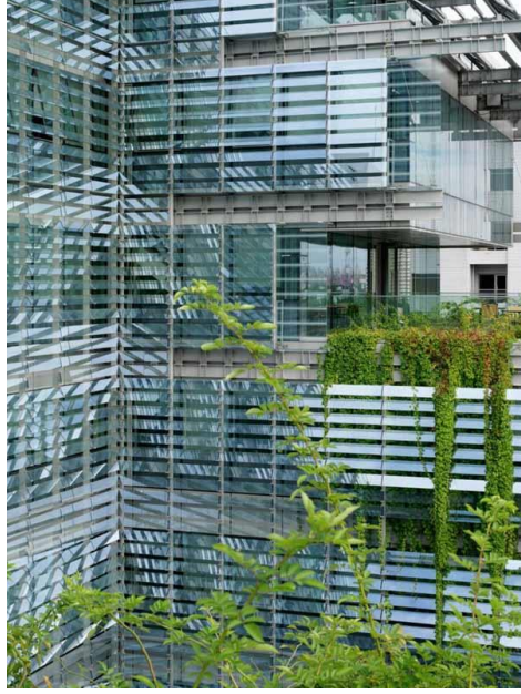
Resim 5.32: Batı cephesi-çift tabakalı cephe kuruluşu (Url-48).
