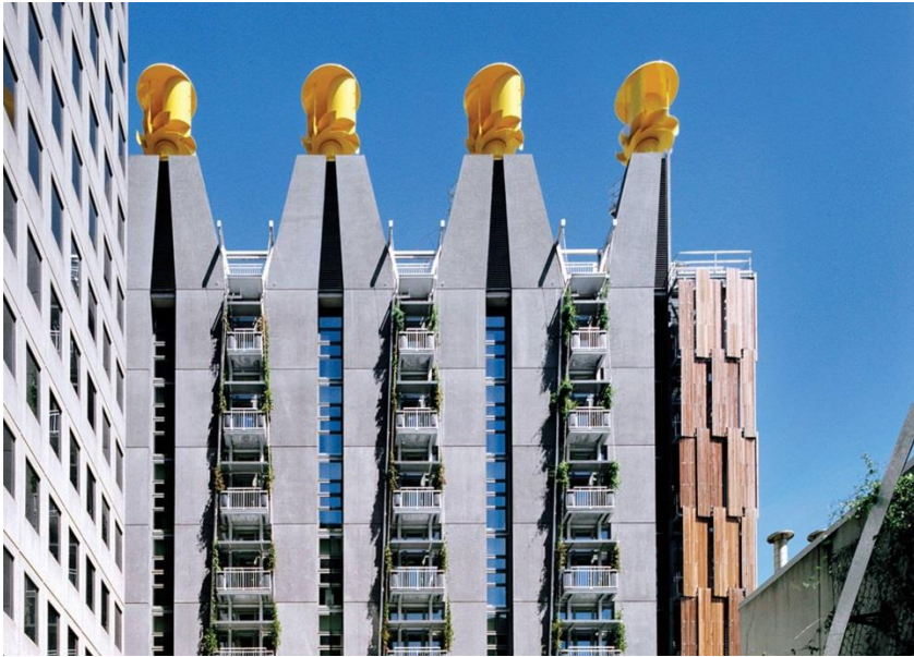
Resim 5.7: Kuzey cephesinde yer alan ısısal baca (Url-30).
