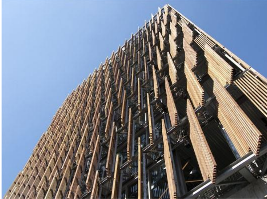
Resim 5.6: CH2 yerel yönetim binası cephe görünüşü (Url-30).
