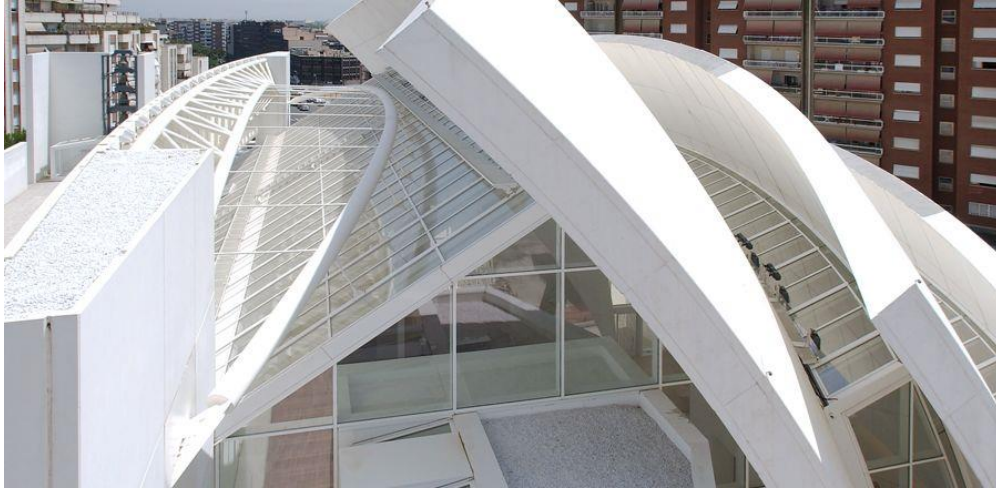
Resim 4.6: Atriumların saydam üst örtülerinde uygulanan gölgeleme elemanları (Url-21).
