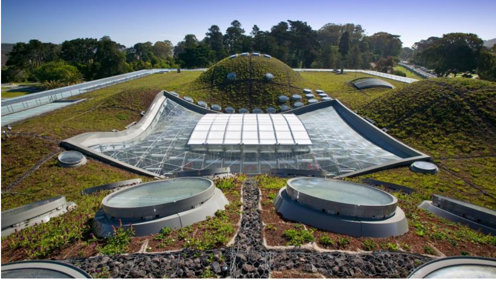
Resim 5.3: Yapı çatısında bulunan açılabilir ışıklıklar (Url-27).
