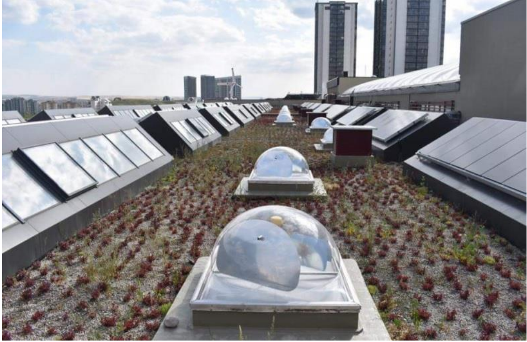
Resim 5.57: Yapının çatı kısmında kullanılan doğal aydınlatma ekipmanları(Url-57).
