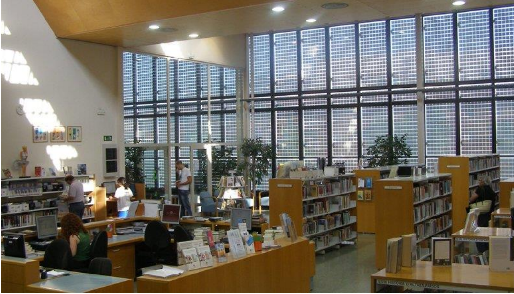
Resim 5.13: Güney cephesinde bulunan çift tabakalı PV sistemin iç mekândan görünüşü (Url-32).
