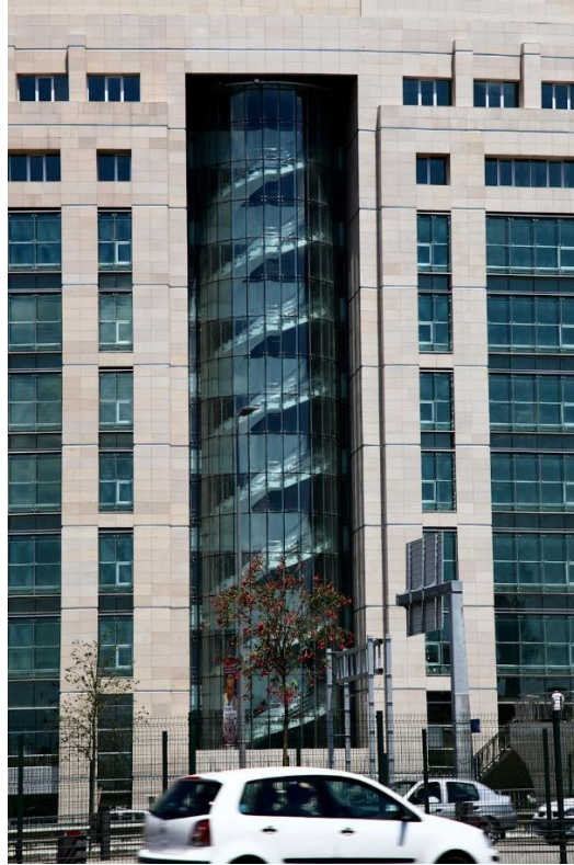
Resim 5.46: Merdiven kısmının doğal aydınlatılması (Url-52).
