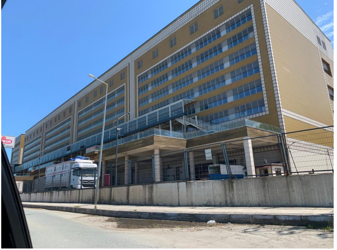
Fotoğraf 16: ÇAYKUR Satışa Hazır Paketleme Binası (Zerdeci, 2024).
