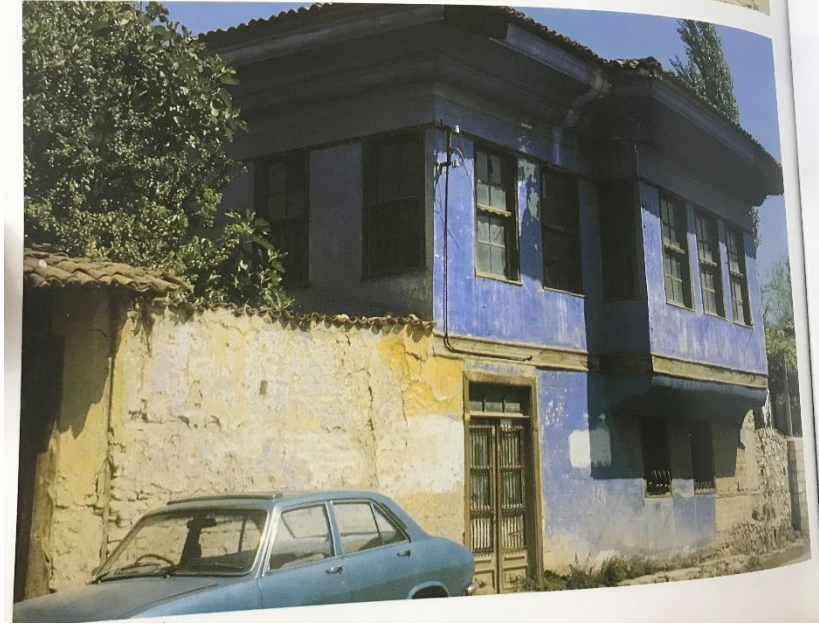
Şekil 3.5: Restitüsyon projesi oluşturulurken pencere örnekleri için belirlenen yapının görünüşü. (İnceođlu, 2004)
