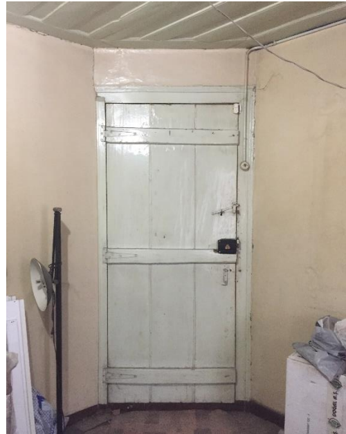
Şekil 2.20: ahşap kapının oda içinden görünüşü. (T. Özderya Arşivi, 2019)
