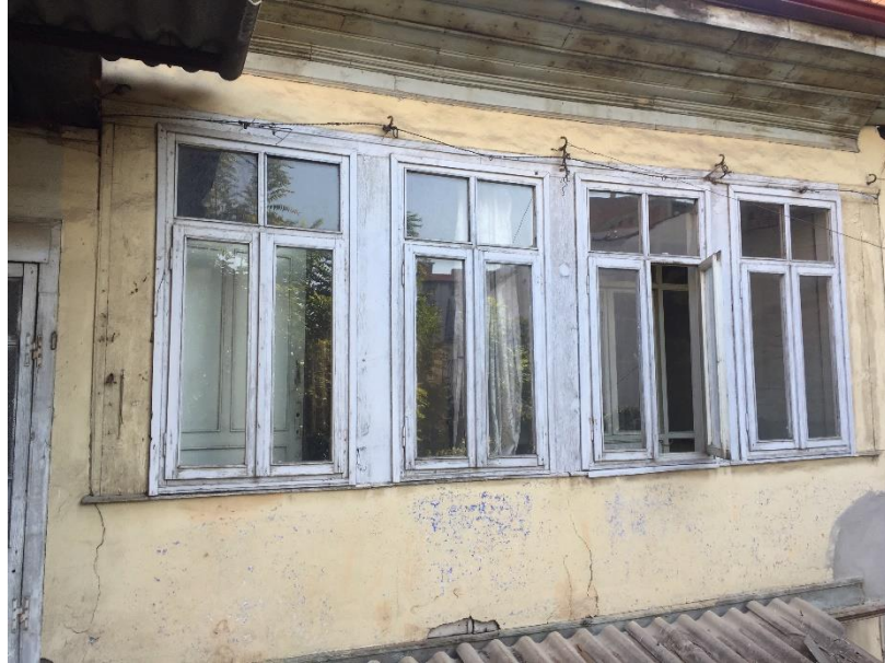
Şekil 2.71: P9 numaralı pencerelerin güneydoğu cephesinden görünüşü.( T. Özderya Arşivi, 2019)
