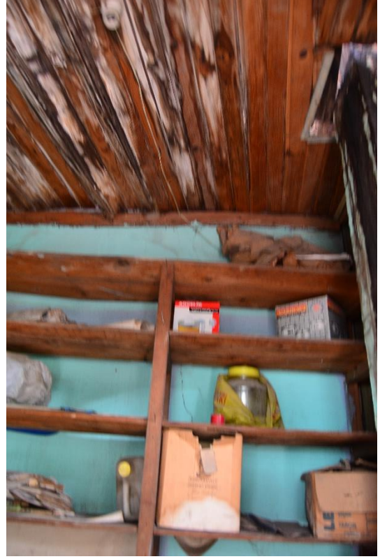
Şekil 2.31: Depo'nun tavan kaplaması. (T. Özderya Arşivi, 2019)
