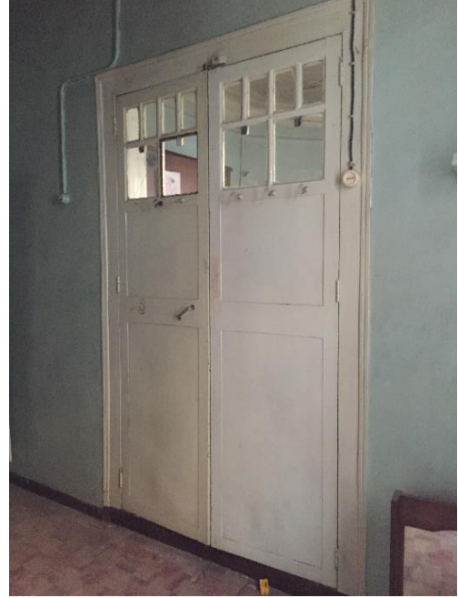
Şekil 2.23: Odaya geçiş sağlayan çift kanatlı ahşap kapı. (T. Özderya Arşivi, 2019)
