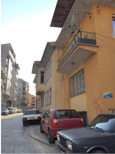
Şekil 2.42: Enver Soylu Evi Güneybatı cephesi. (T. Özderya Arşivi, 2019)
