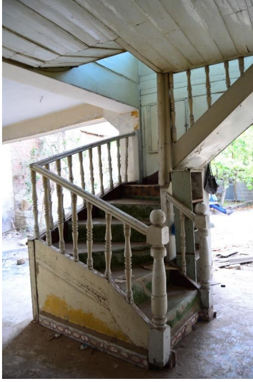
Şekil 2.44: Basamakları pvc kaplanmış merdiven. (T. Özderya Arşivi, 2019)
