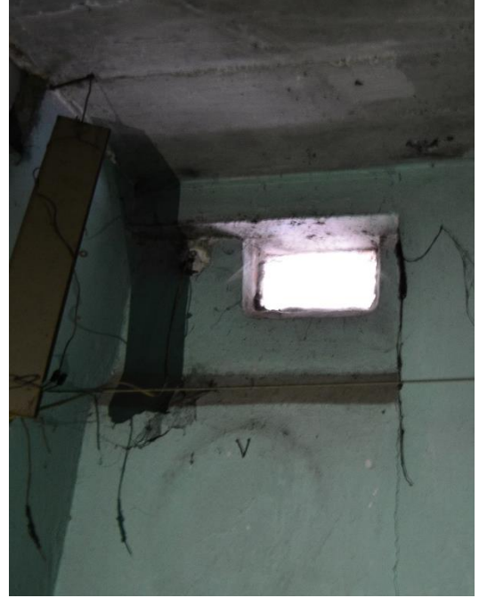
Şekil 2.10: Tuvaletin ışık almasını sağlamak için açılmış boşluğun cam ile kapatılması (T. Özdeya Arşivi, 2019).
