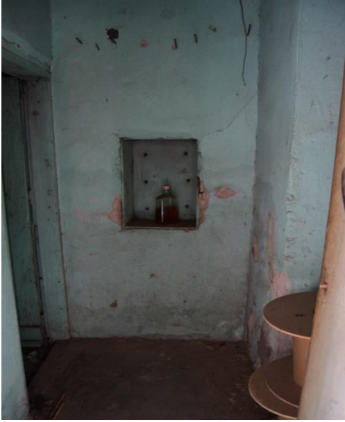
Şekil 2.11: Ahşap duvar nişi (T. Özderya Arşivi, 2019).
