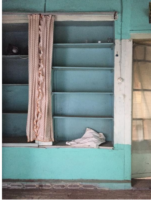
Şekil 3.4 : 104 numaralı mutfakta kapatılan pencere boşluklarının rafa dönüştürülmesi. (T. Özderya Arşivi, 2019)
