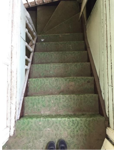
Şekil 2.47: Birinci kattan merdivenin görünüşü. (T. Özderya Arşivi, 2019)
