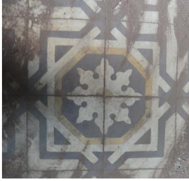
Şekil 2.50: 104 Mutfak zemin kaplaması. T. Özderya Arşivi, 2019)
