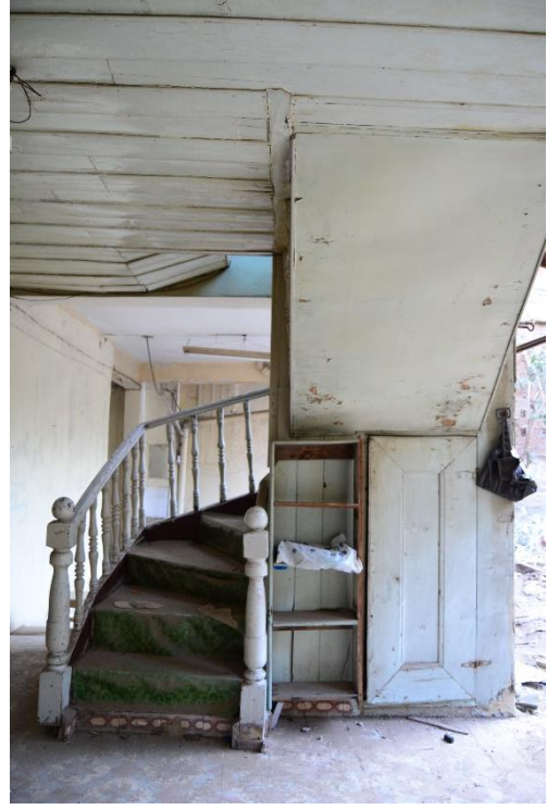
Şekil 2.45: Merdiven altı kapatılarak dolap . (T. Özderya Arşivi, 2019)
