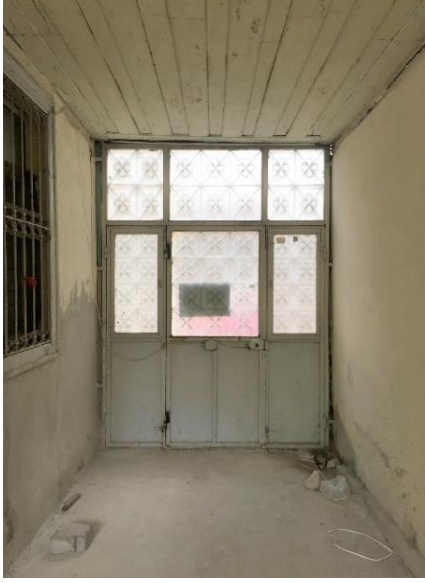
Şekil 2.55: Demir giriş kapısının iç mekandan görünüşü. ( T. Özderya Arşivi, 2019)
