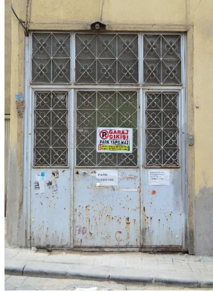
Şekil 2.56: Demir giriş kapısının sokaktan görünüşü. ( T. Özderya Arşivi, 2019)
