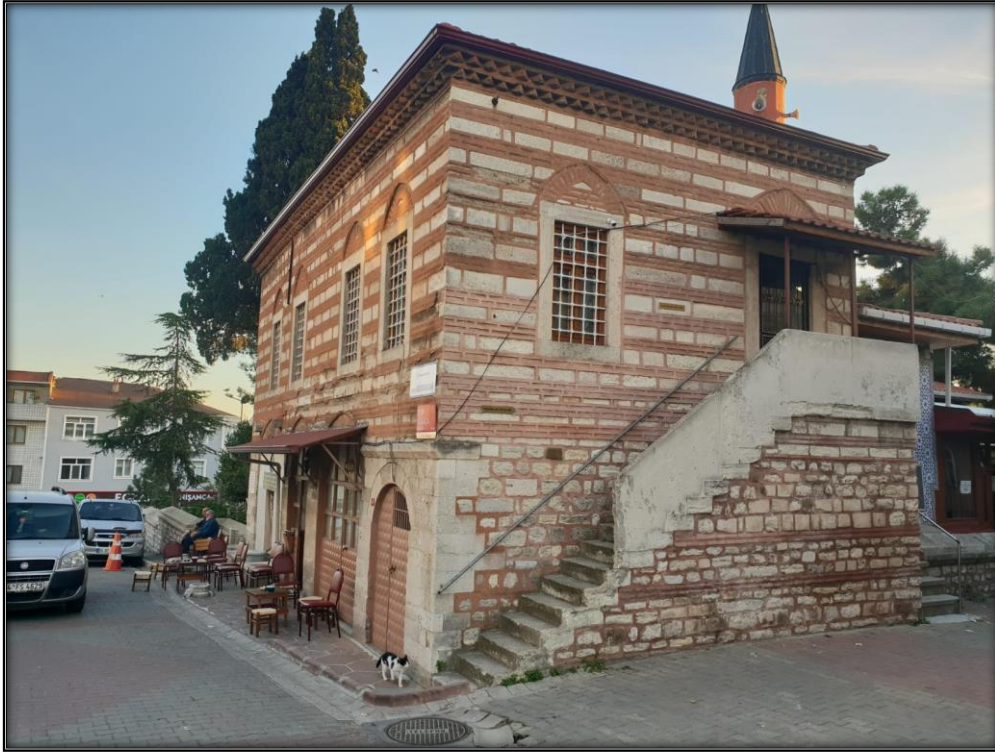
Şekil 53: Mektep Kuzey Cephesi Görünüşü (A.GÜVEN, 2019)
