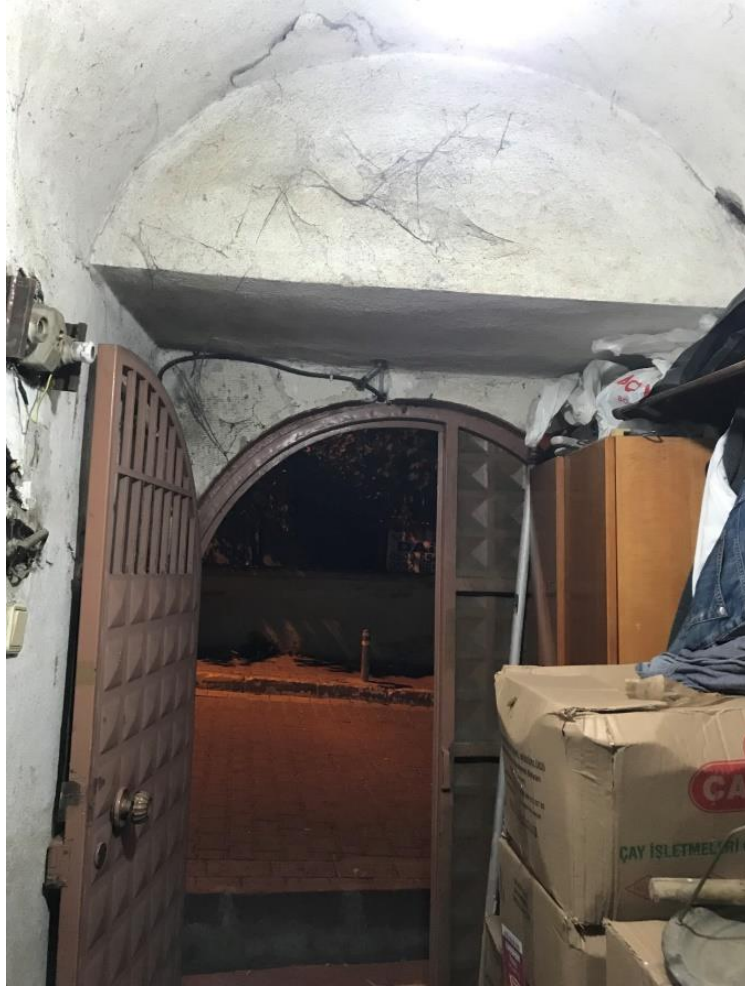
Şekil 30: Z01 Oda İçten Görünüm (A.GÜVEN 2019)
