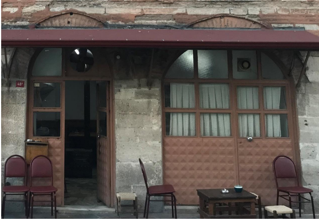
Şekil 45: K1 ve K2 kapıları dıştan görünüm (A.GÜVEN 2019)
