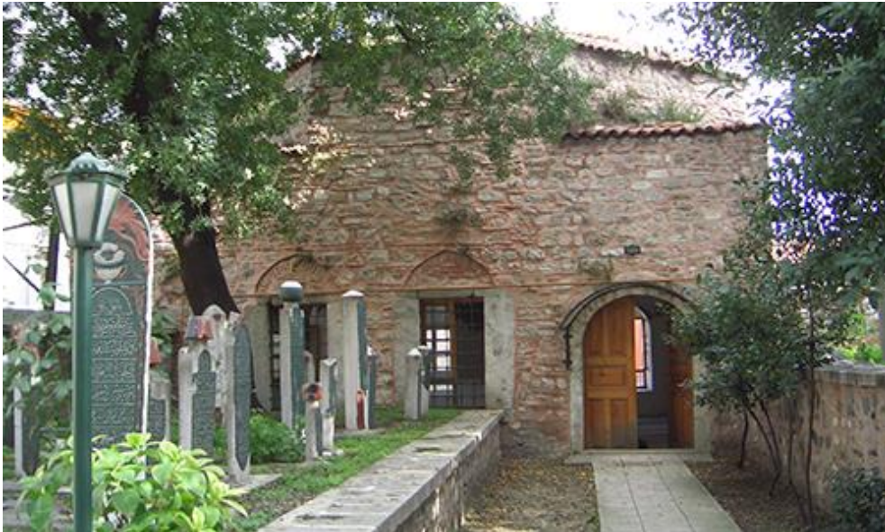
Şekil 11: Şeyh Murat Paşa Tekkesi dıştan görünüm (Eyüpsultan Belediyesi)
