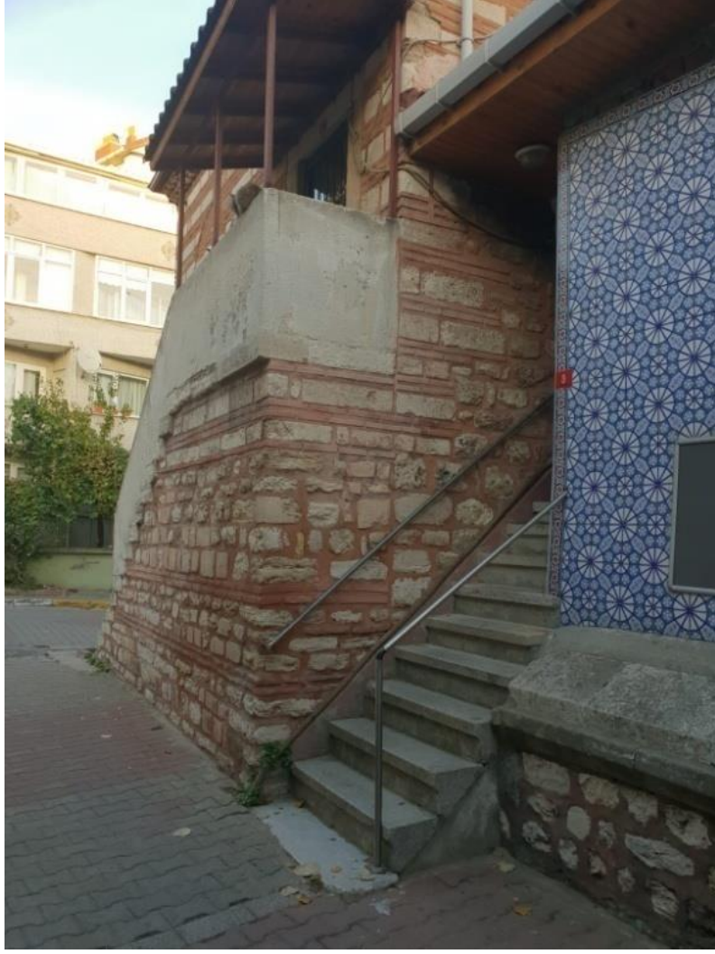
Şekil 58: Mektep Batı Cephesi Görünüşü (A.GÜVEN, 2019)
