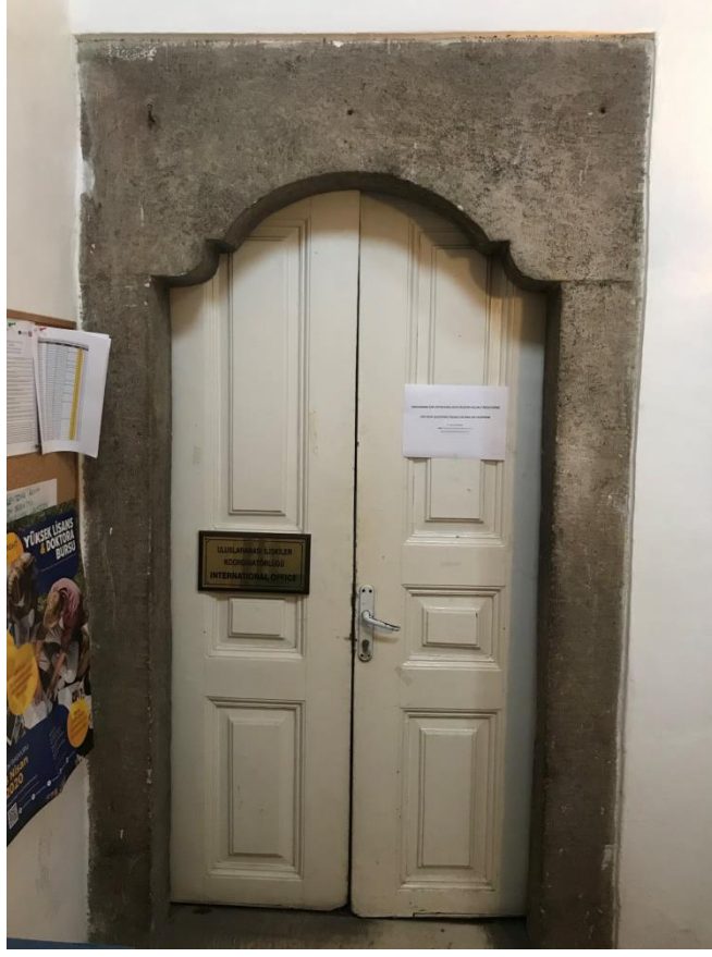
Şekil 69: Merdivenle 1.kata çıkıldıktan sonra derslane bölümüne açılan kapı
