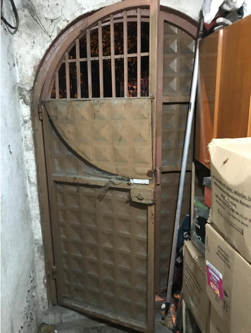
řekil 48: K3 Kapısı içten görünüm (A.GÜVEN 2019)
