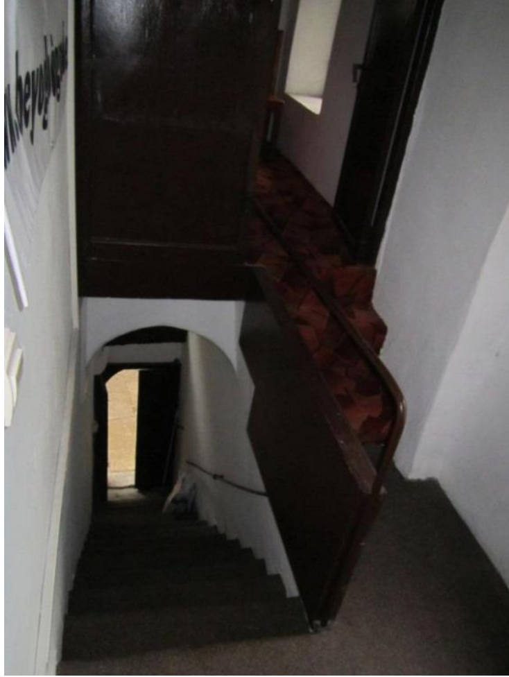
Şekil 76: 1.kata çıkan merdiven ve üstündeki mekana bakış (KUDEB)
