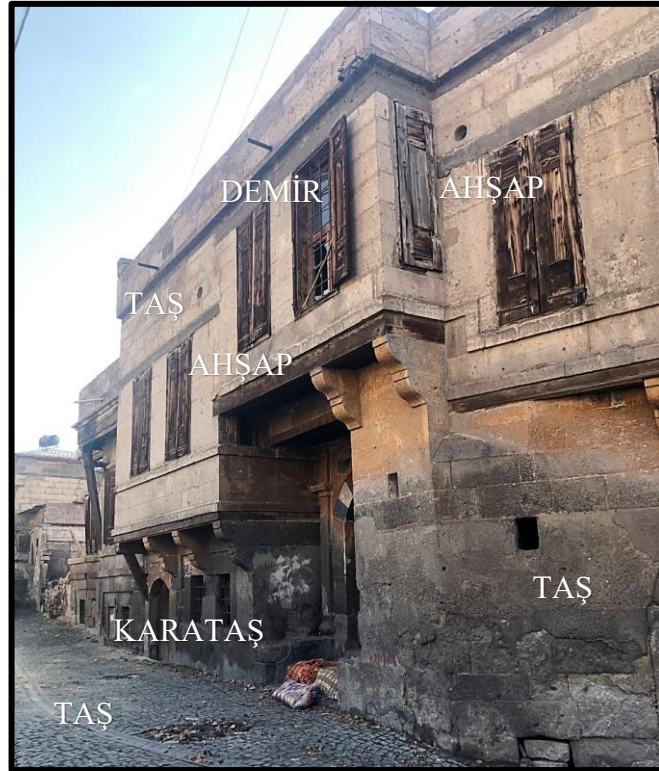
Şekil 27 : Malzemelerin geleneksel Germir evinde kullanım örneği (Belkıs Bahar Alparslan Arşivi, 2021)
