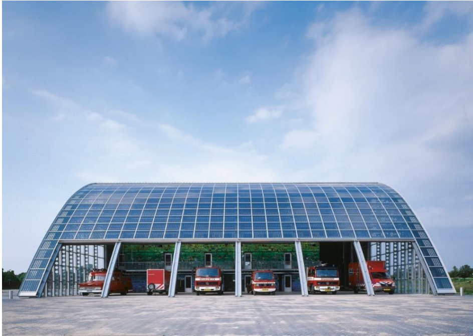
Şekil 1.14: İtfaiye istasyonu cephesinde fotovoltaik hücre uygulaması, Houten, Hollanda (Url-14).
