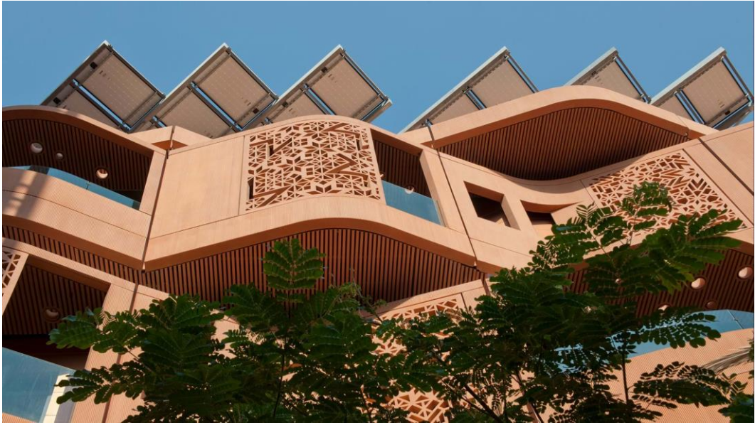
Şekil 4.16: Masdar Enstitü Konutları ceph ve balkonu (Url-40).
