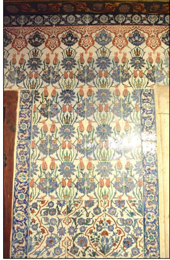
R. 220. Takkeci İbrahim Ağa Camii doğu cephesi çinileri (24.02.2014).
