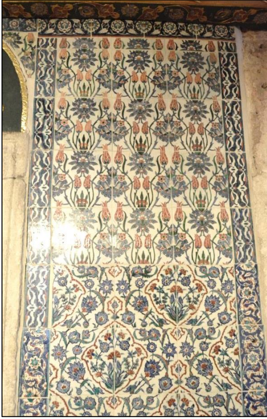
R. 219. Takkeci İbrahim Ağa Camii batı cephesi çinileri (24.02.2014).
