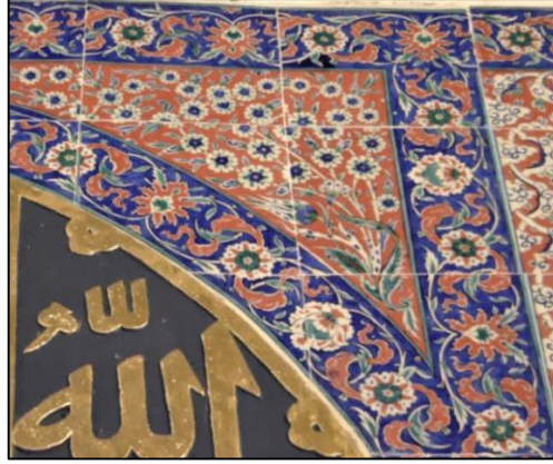
R. 248. Takkeci İbrahim Ağa Camii, kitâbeyi çevreleyen bordür çinisi (24.02.2014).
