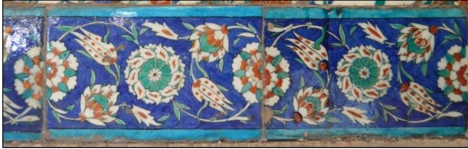
R. 266. Sultan Ahmet Camii, ikinci kat bordür çini detayı (18.02.2014).
