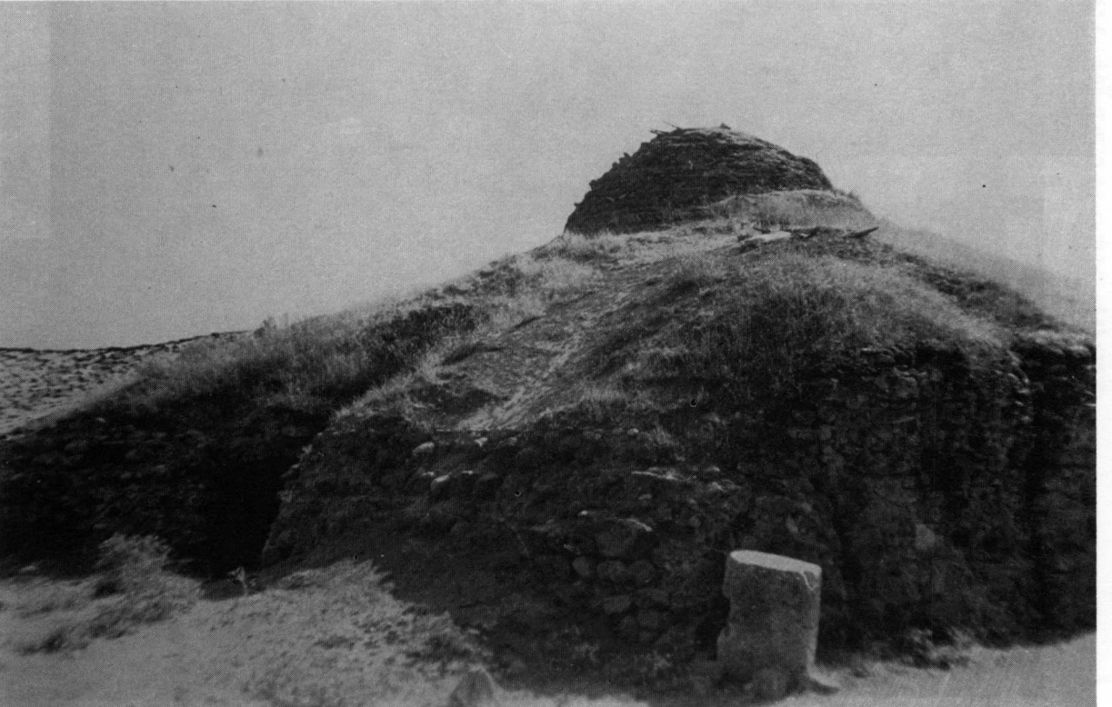
Resim 17: Tek hamam doğu ve kuzey cephelerinden görünüş.
