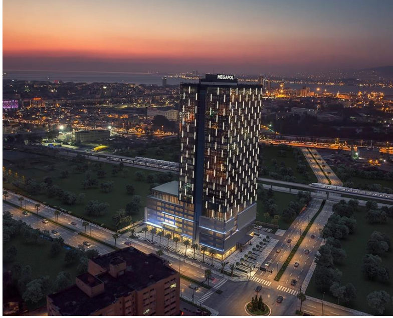
Resim 3.22. İzmir Metropol Tower
