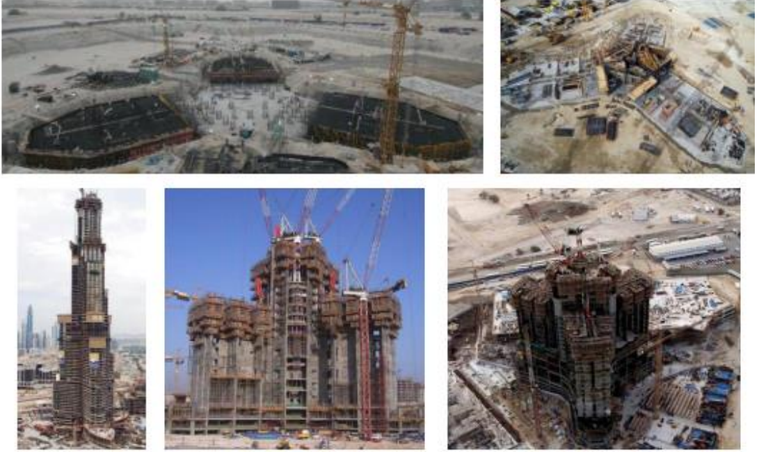
Resim 4.13. : Burj Khalifa Binası yapım aşamaları (Smith, 2020)
