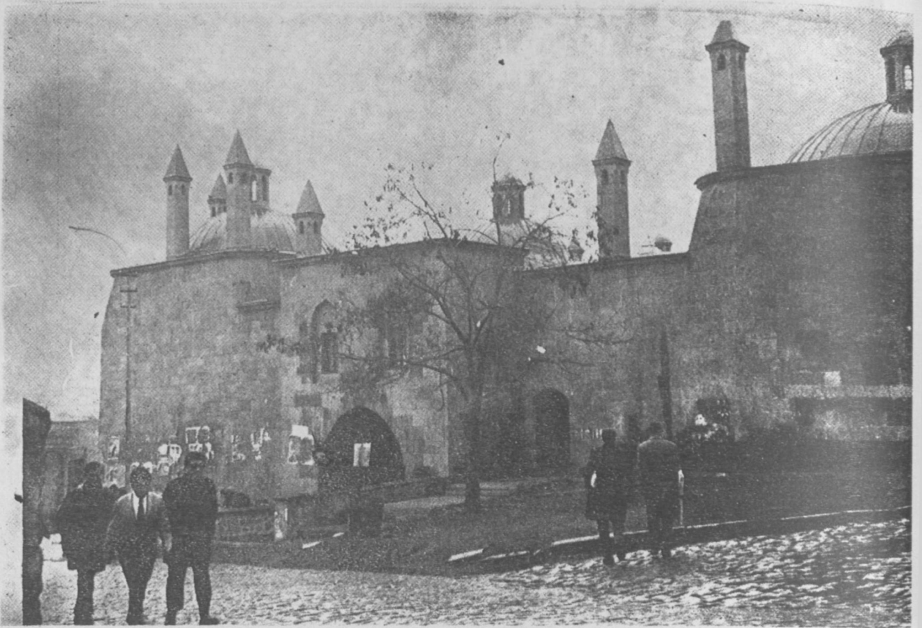
Resim : 11. Erzurum - Rüstem Paşa Hanı dış giriş cephesi (onarımdan sonra)
