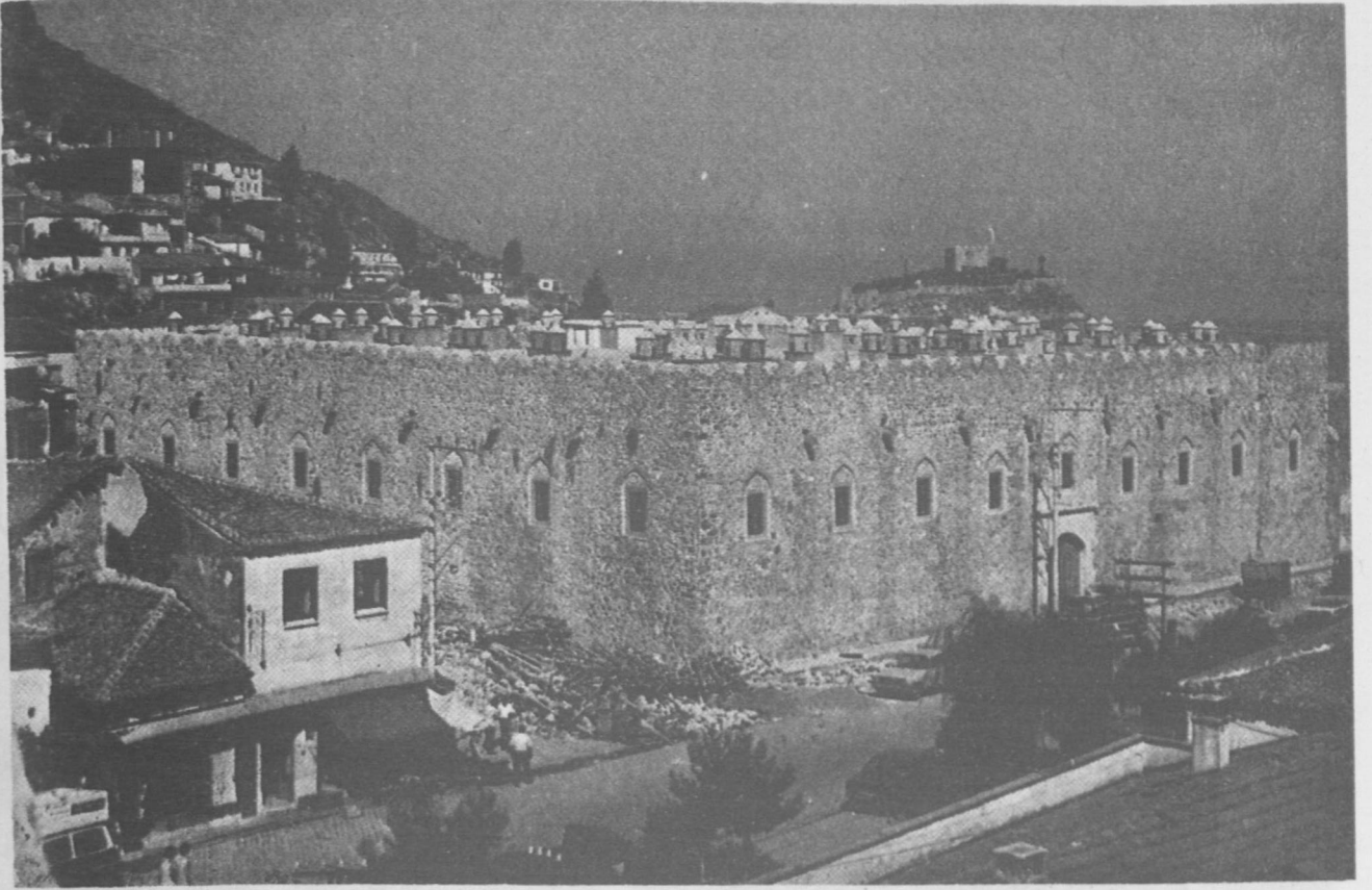
Resim : 9. Aydın Kuşadası Öküz Mehmet Paşa Kervansarayı (genel görünüş)
