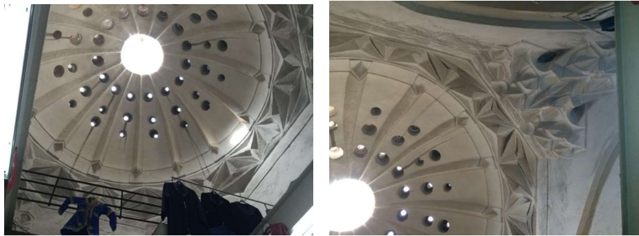
Şekil 3.3: Erkekler kısmı ılıklık mekan görseli
