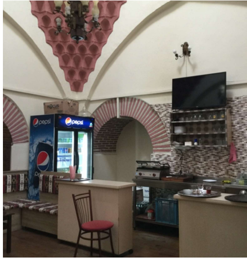
Şekil 3.7: Alçıpan ile kapatılan sıcaklığa geçiş, Kadınlar ılıklik kısmı güncel malzeme durumu ve çayevi olarak kullanımı
