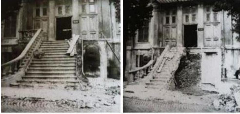
Görsel 3.53: Sanayi-i Nefise Mektebinin ana giriş merdivenlerinin yıkılması,1966 197
