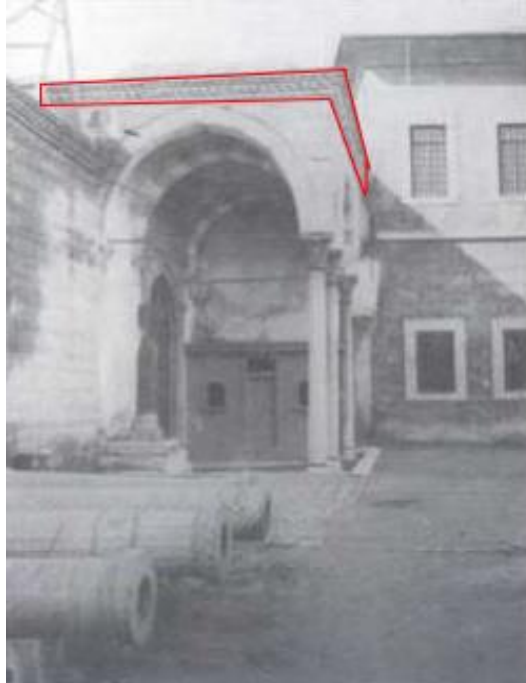
Görsel 3.7: 1955 tarihli onarım sonrası kuzey giriş revakı 127
