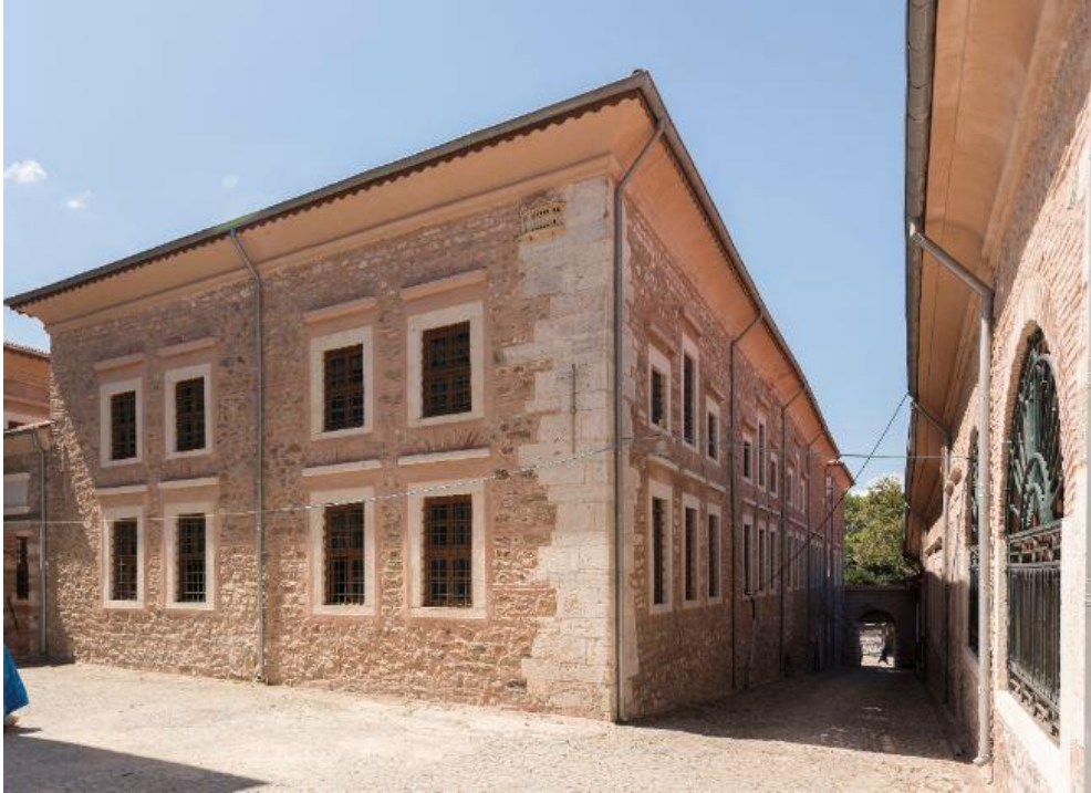
Görsel 3.63: Kalıp atölyesi ve damga matbaası (3 ve 13 numaralı yapılar), TSMA, 2021
