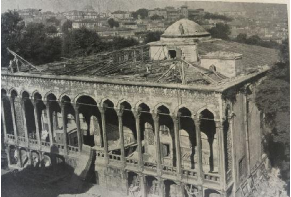
Görsel 3.33: Çinili Köşk'ün çatısı onarımı, Tahsin Öz, 1942
