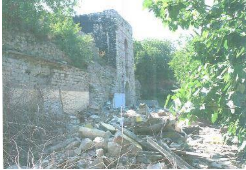
Görsel 3.80: Dış Karakol Binası etrafındaki muhdes yapıların yıkımı, 2007, İRAMA
