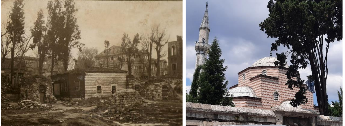
Şekil 29. Solda Şeyh Vefa Camii kalıntıları, Sağda Vefa Camii günümüzdeki durum 2020
