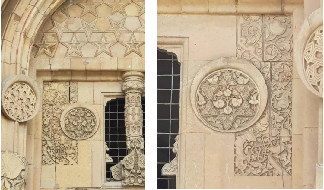
R. 19: Şifahane Taçkapısı Ayrıntıları
