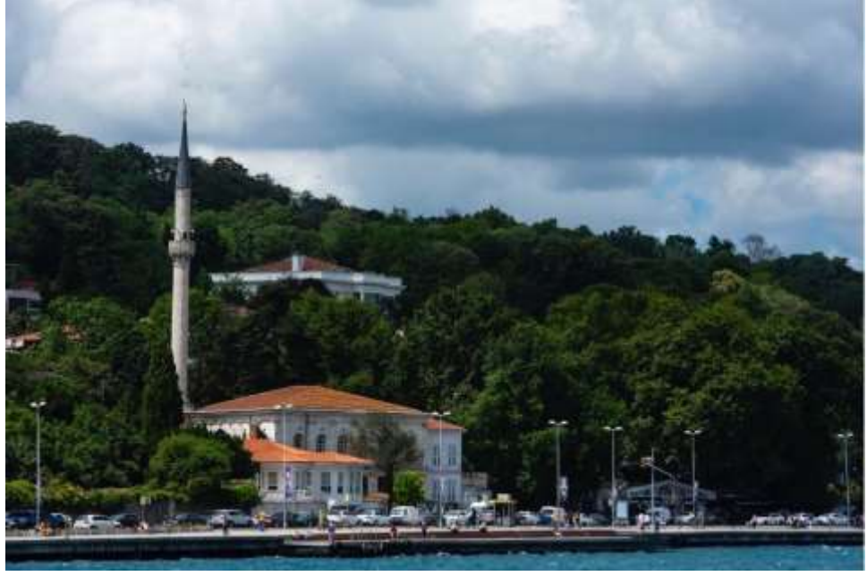
Şekil 1.34 Hamid-İ Evvel Emirgân Camii Denizden Görünüm (Ayşegül Kurt Fotoğraf Arşivi 2020)
