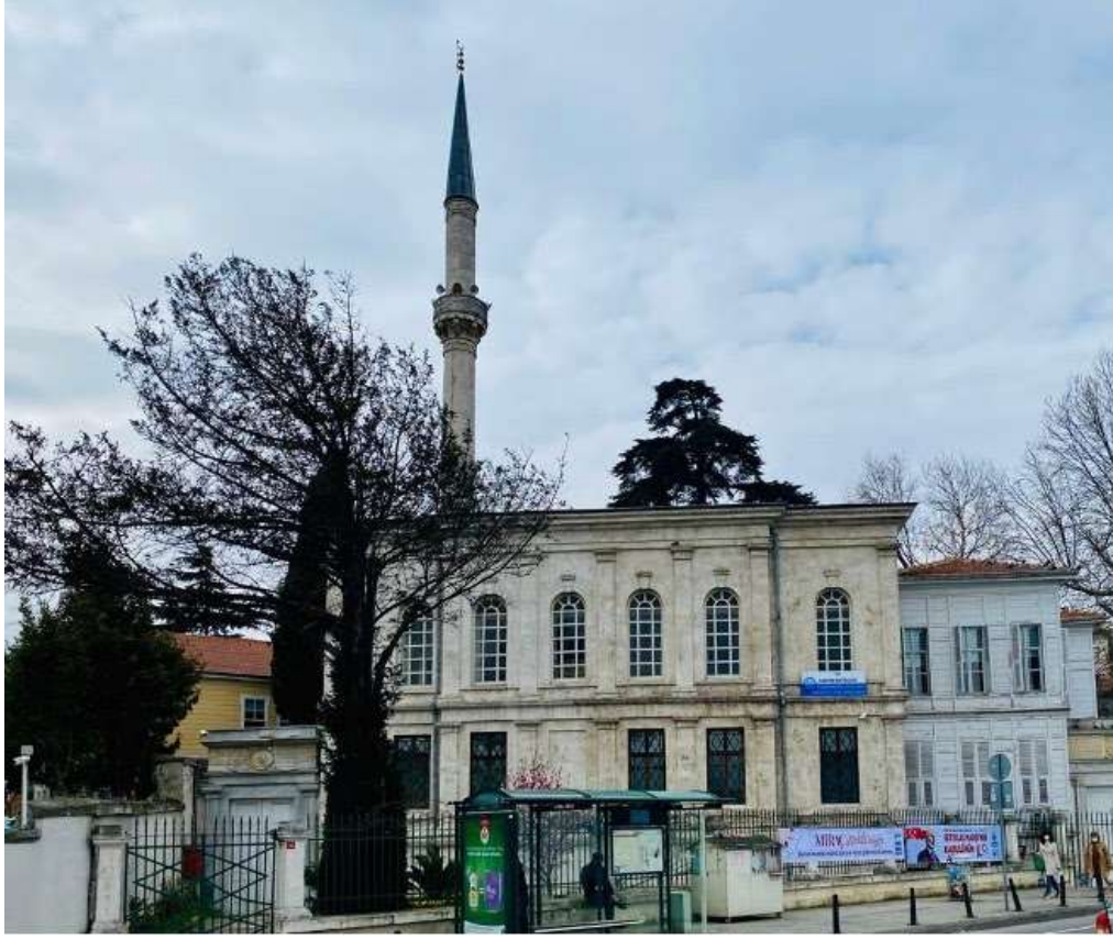
Şekil 1.30 Hamid-i Evvel Emirgân Camii Sakıp Sabancı Caddesinden görünümü
