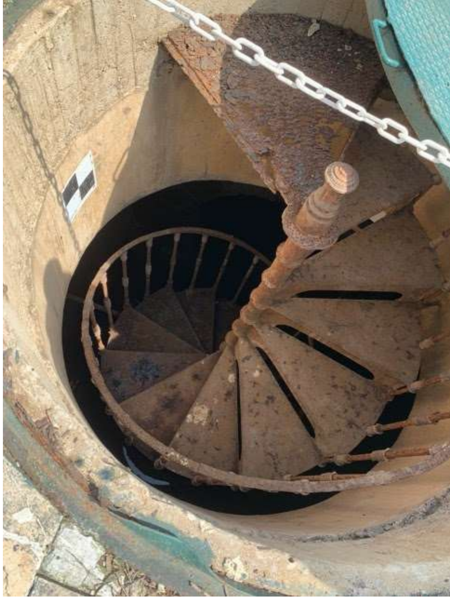
Şekil 1.65 Su sarnıcına inen merdivenler
