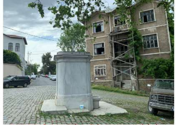
2. ÇAM FISTIĞİ SOKAK İLE ŞİRİN SOKAK KESİŞİMİ
