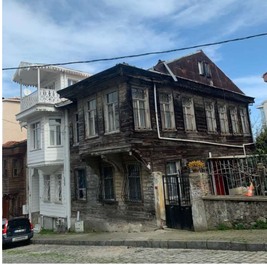
Şekil 1.105 117 ada üzerinde bulunan rekonstrüksiyon yapı ve az müdahale görmüş yapı
