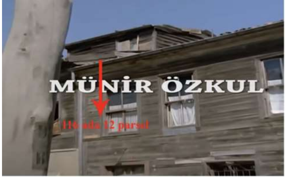
Şekil 2.44 116 ada 12 parselde bulunan yapının balkona çevrilen katı (Sev Kardeşim, 1972)
