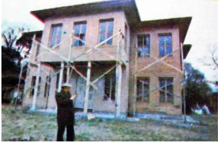
Şekil 1.78 Pembe Köşk Restorasyonu (emlakkulisi.com)
