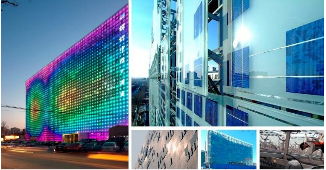
Şekil 3.40: Greenpix Sıfır Enerji Medya Duvarı, Pekin, Çin.
