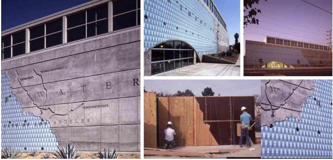
Şekil 3.28: Kuzey Hollywood Su Şebekesi İstasyonu, Kaliforniya, USA.
