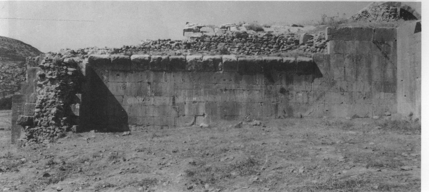
14. İncir Hanı ahır cephesi batı kesimi.
