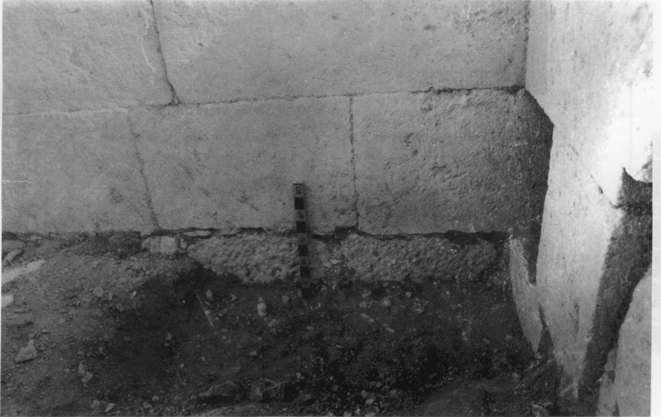
30. Incir Hanı . Avlunun güneybatı köşesinde, avlu zemin kotunun saptanmasını sağlayan düzgün yüzeyli ilk kesme taş sırası.
