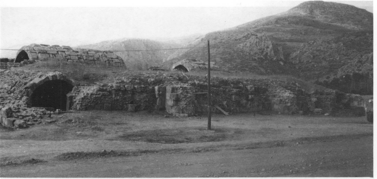
5. Incir Hanı ahırının dođu cephesi.
