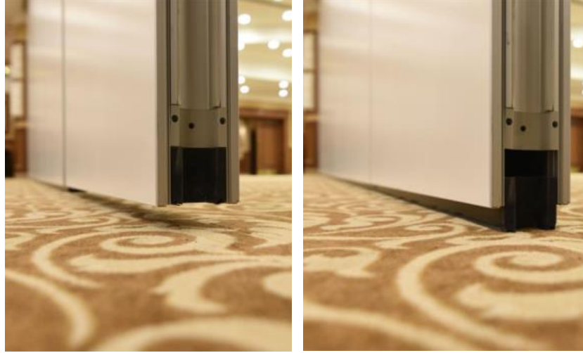
Şekil 3. 9 :Hareketli panel duvar kilit sistemi (Url-12).
