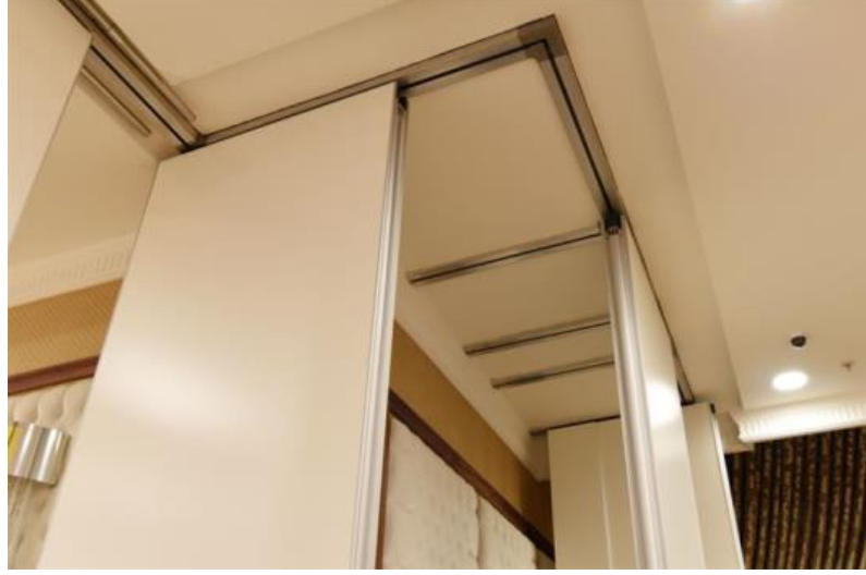
Şekil 3. 8 :Hareketli panel duvar ray sistemi (Url-12).
