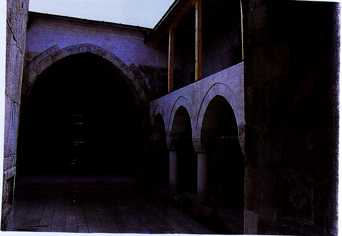
Res. 27: Onarımdan sonra auluya bakış.
