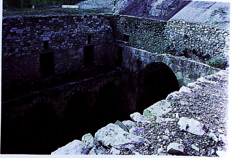
Res. 13: Giriş eyvanı ve güney revakının damdan görünüşü.
