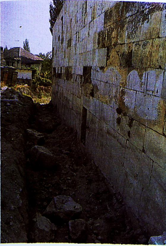
Res. 6: Kuzey cephenin temizlenmiş hali.
